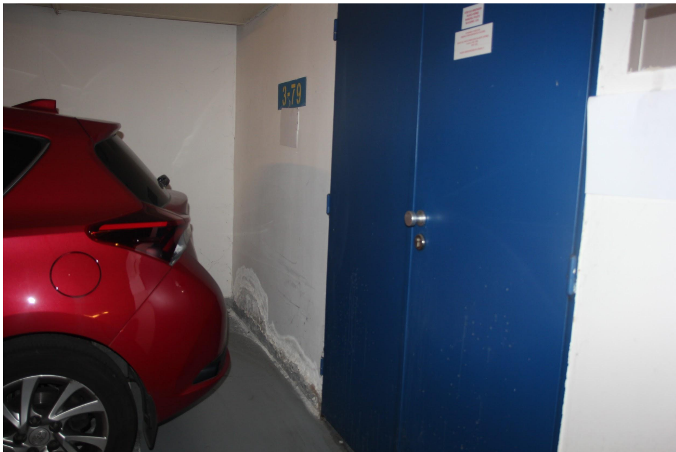
Detail poškodeného sokla vplyvom vzliňajúcej vlhkosti
