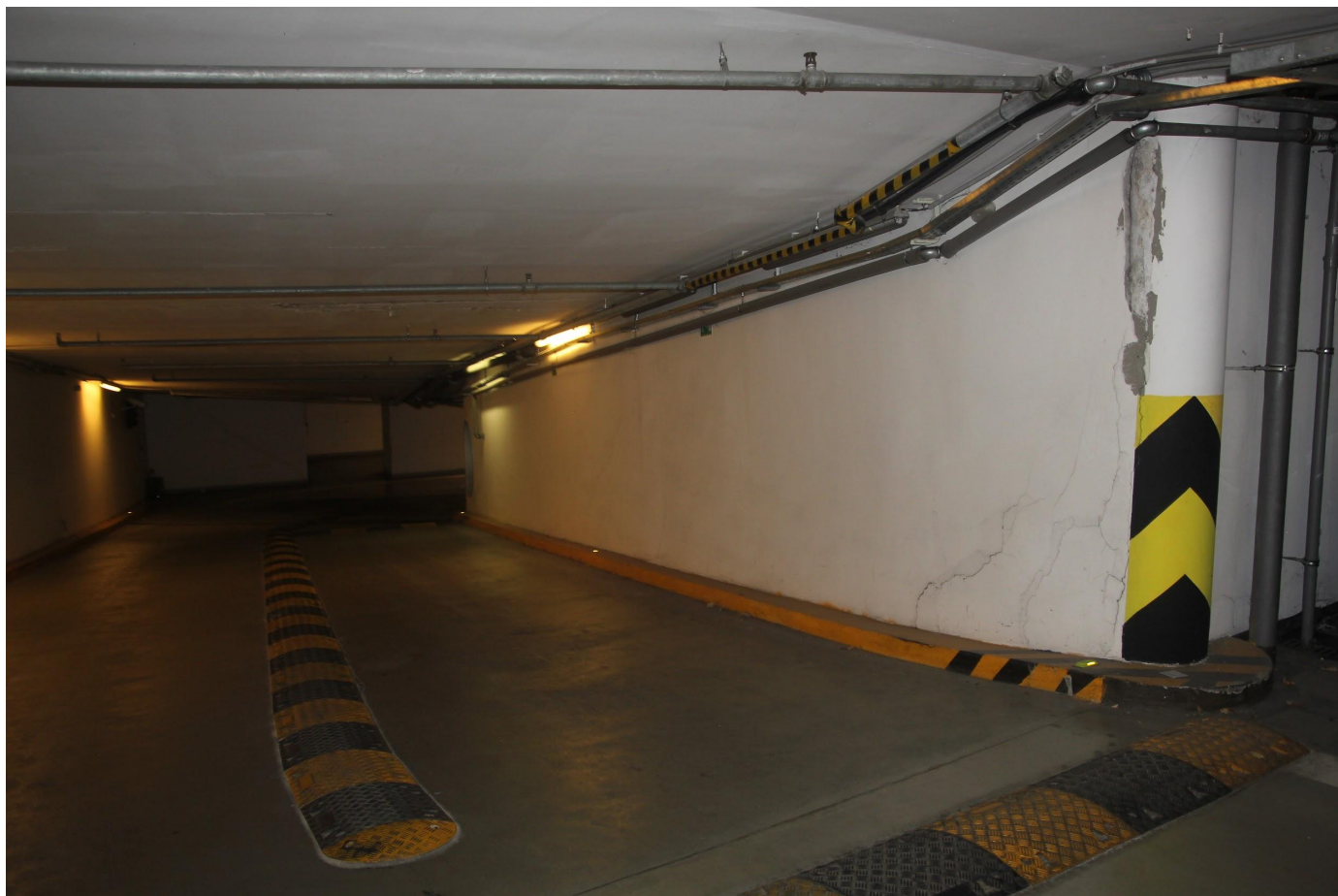
Detail poškodenej steny pri rampe
