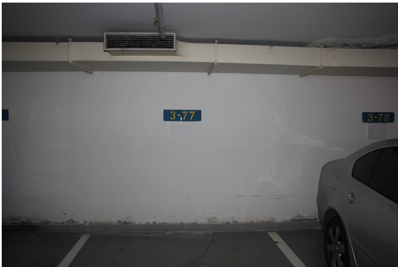
Detail zvislých zmrašťovacích trhlín
