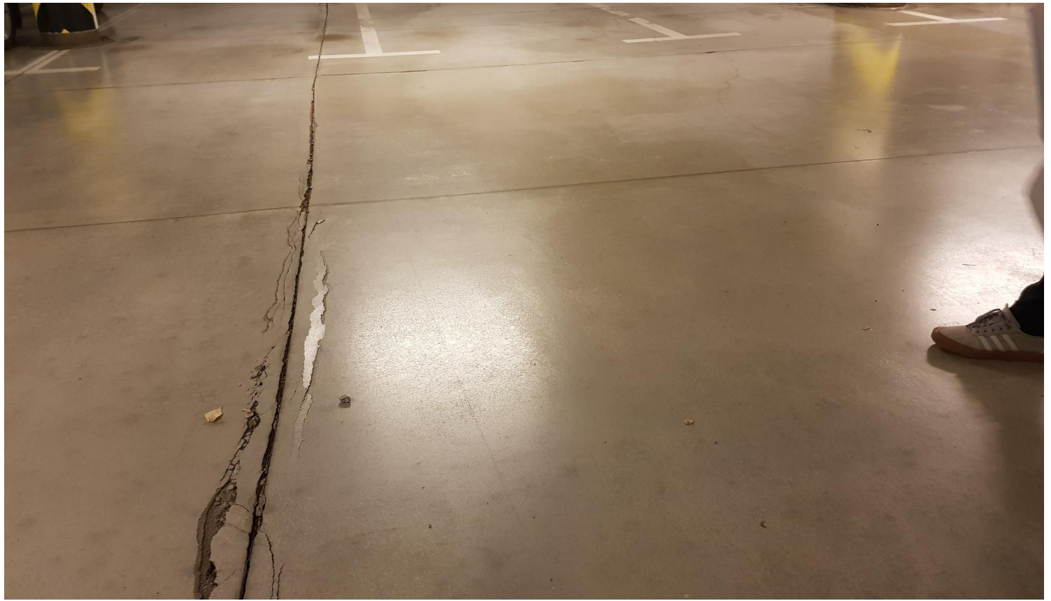
Detail porušenej dilatácie podlahy
