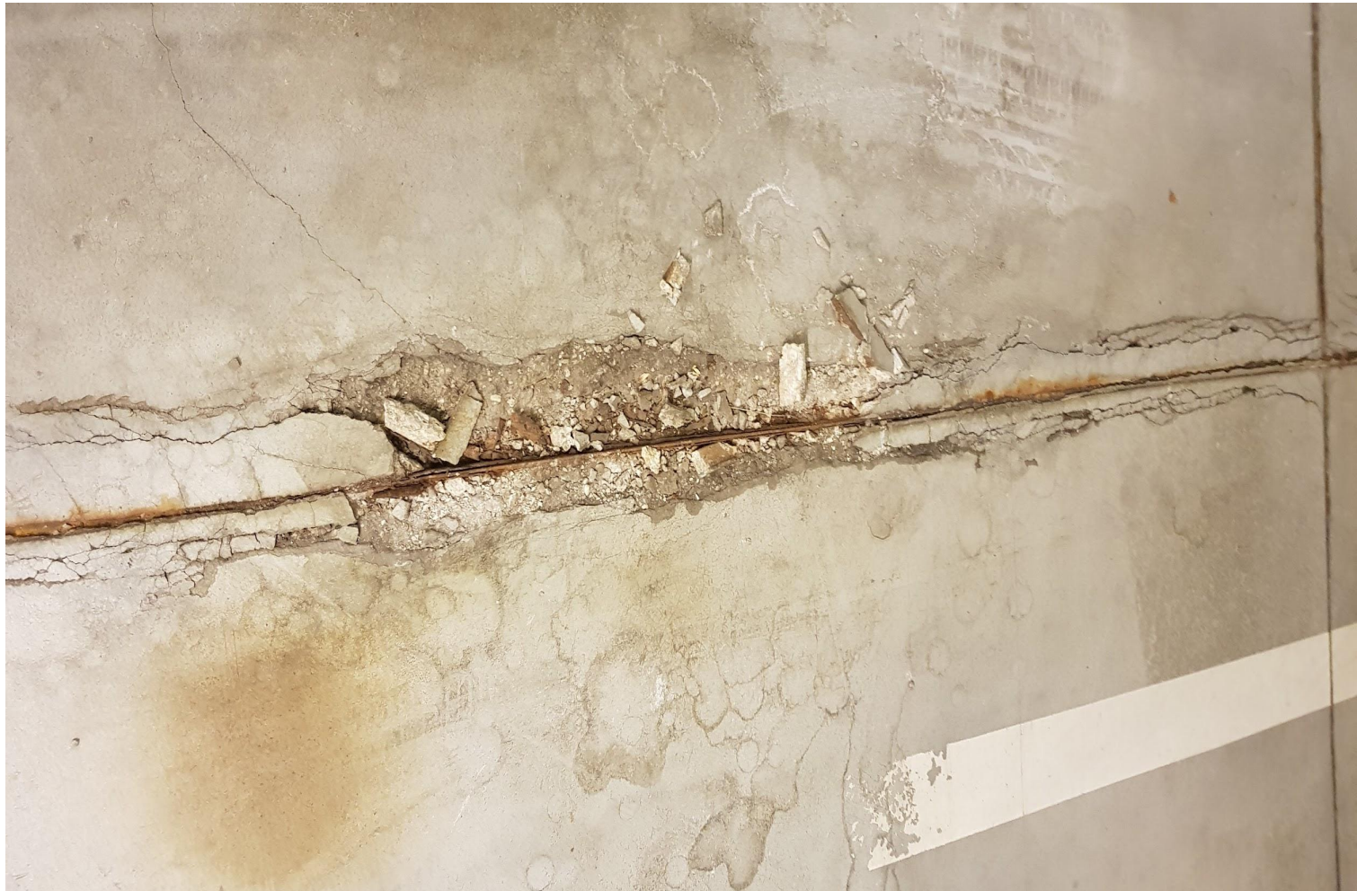
Detail porušenej dilatácie podlahy
