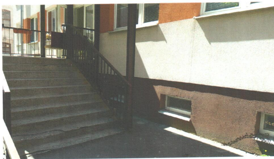
Obr. č. 2 Miesto realizácie bezbariérového vstupu do budovy (pohľad 2)
