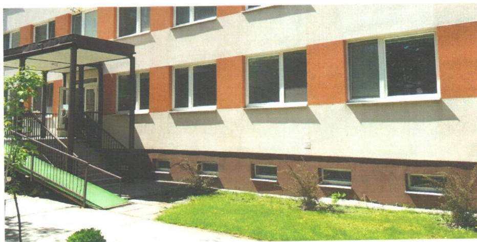
Obr. č. 1 Miesto realizácie bezbariérového vstupu do budovy (pohľad 1)
