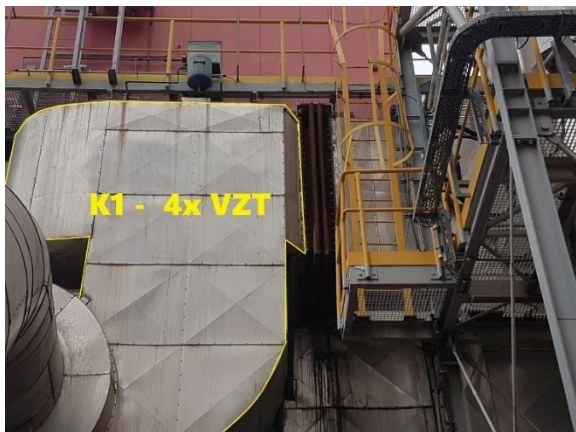
Obr. č. 6: Plášť by-passových klapky filtru TF2.
