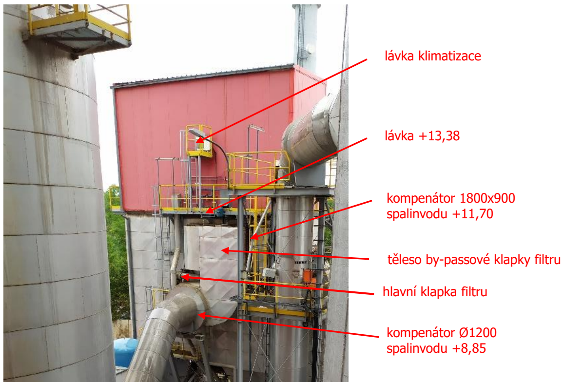
Obr. č. 11: Dispozice klapky filtru.
