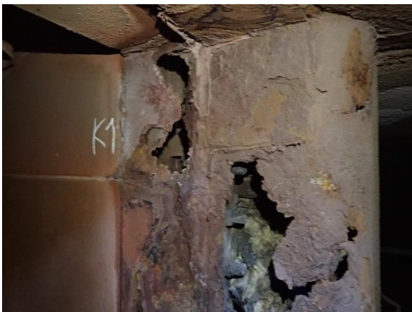
Obr. č. 7: Koroze pláště by-passových klapiek.
