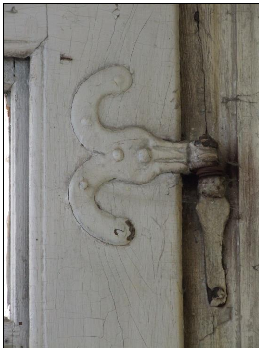
Detail ozdobného trňového závesu.
