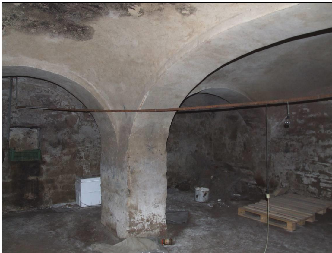
Pivnica s pruskými klenbami a stredným pilierom.
