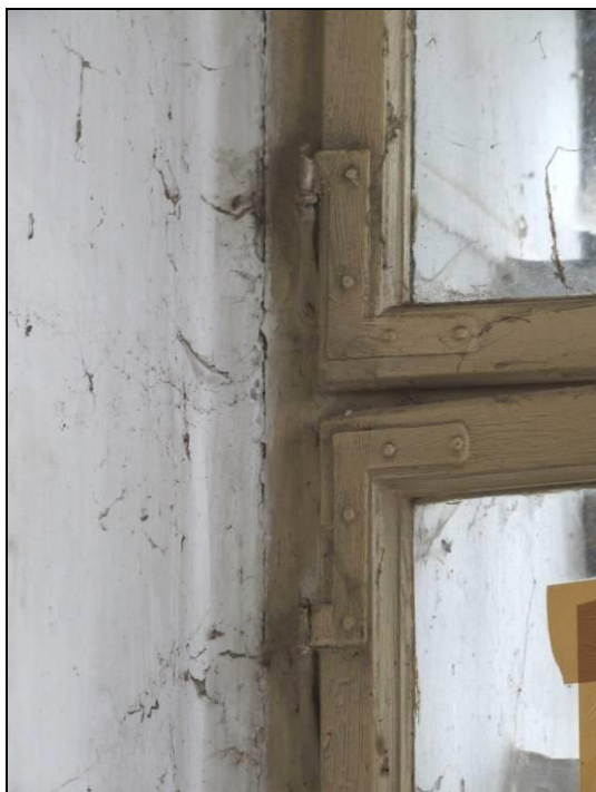
Detail vnútorných krídel s uholníkom a trňovým závesom.
