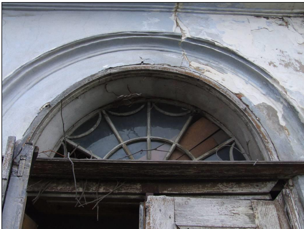
Detail vnútorného svetlíka a profilovanej rímsy pravých dverí.
