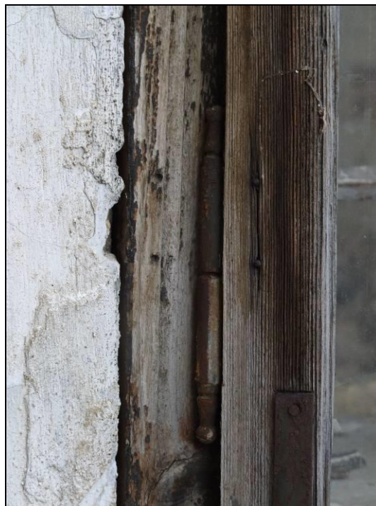
Detail kuželového závesu s guľovitým ukončením.
