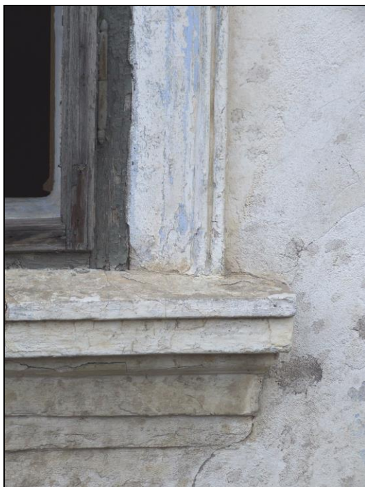
Detail vonkajšieho rámu okna so závesom ukončeným v tvare žalud'a.
