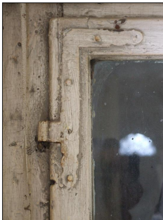
Uholník s chýbajúcim trňovým závesom.
