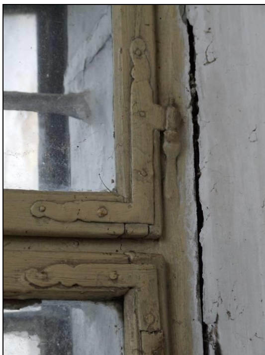
Detail dolného křídla s uholníkom a třínovým závesom.
