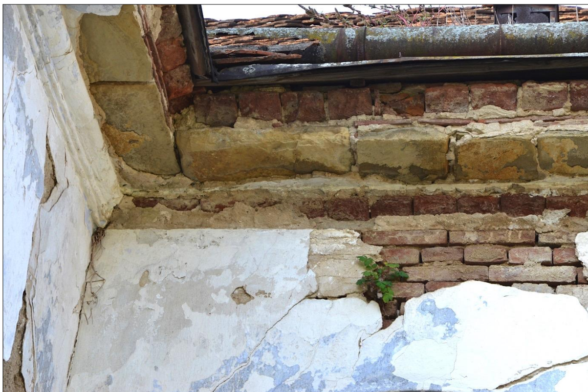
Murivo korunnej rímsy s kamennými platňami a sekundárne použitými škridľami z 2. stavebnej etapy.
