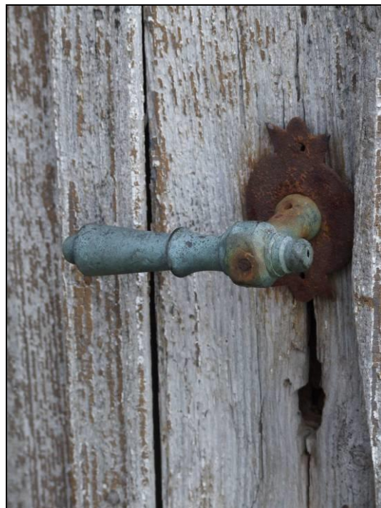
Detail pôvodnej kľučky z vonkajšej strany.
