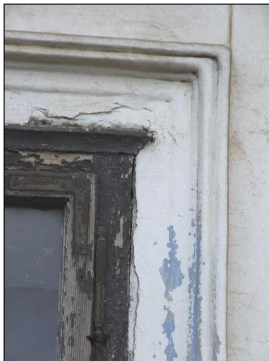
Detail hornej časti rámu s rímsičkou.
