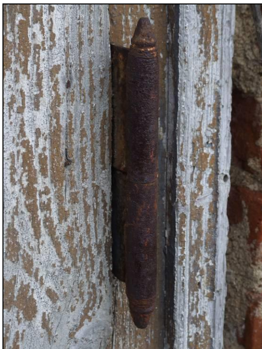
Detail predsadeného závesu s kužeľovým ukončením.
