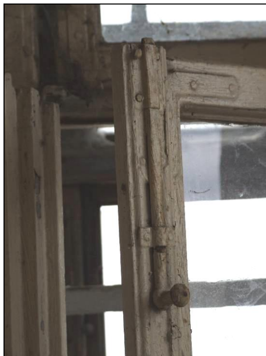
Detail klapacej lišty so zástrčkovým mechanizmom.
