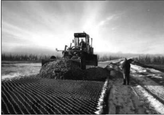
Rys. 8. Zасыpywanie kruszywem komórek geosiatki przy pracach budowlanych
