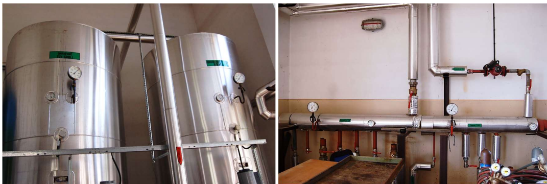
Obr. 17: Vyvedenie TV a C-TV - kotolňa
