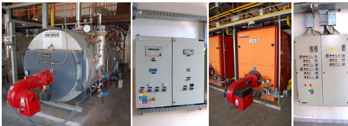
Obr. 10: Kotle a rozvádzač parnej resp. teplovodnej časti
