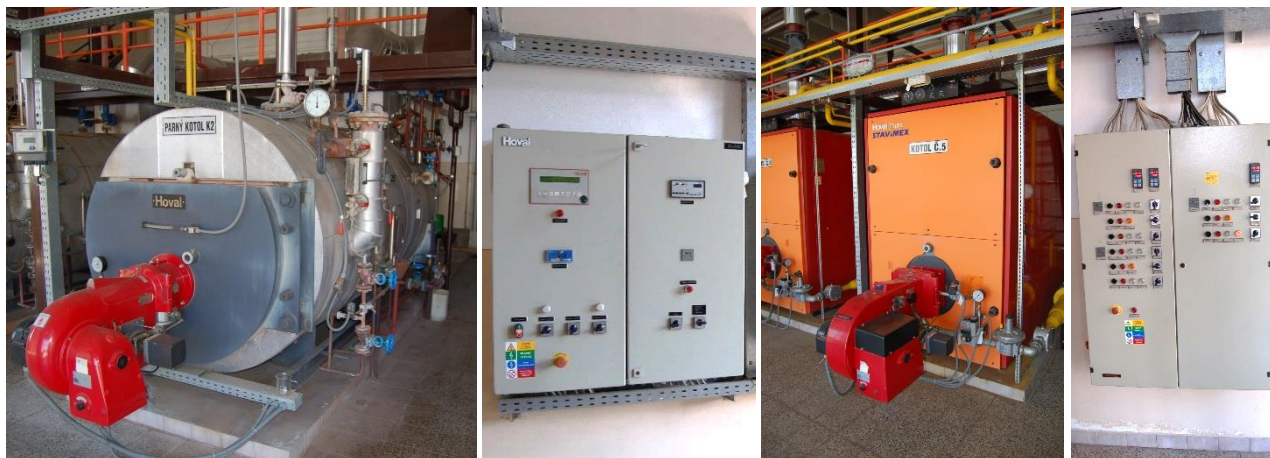
Obr. 10: Kotle a rozvádzač parnej resp. teplovodnej časti
