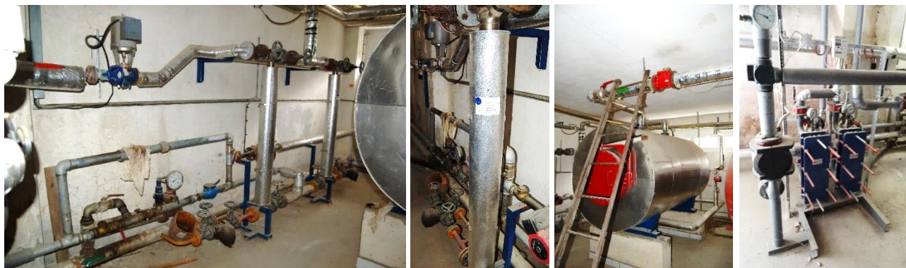
Obr. 18: Ohrev TV v ženskom pavilóne
