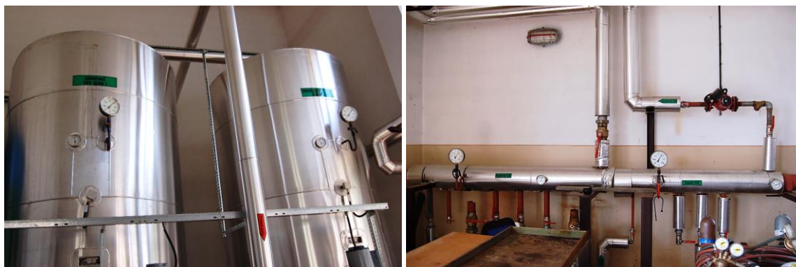
Obr. 17: Vyvedenie TV a C-TV - kotolňa
