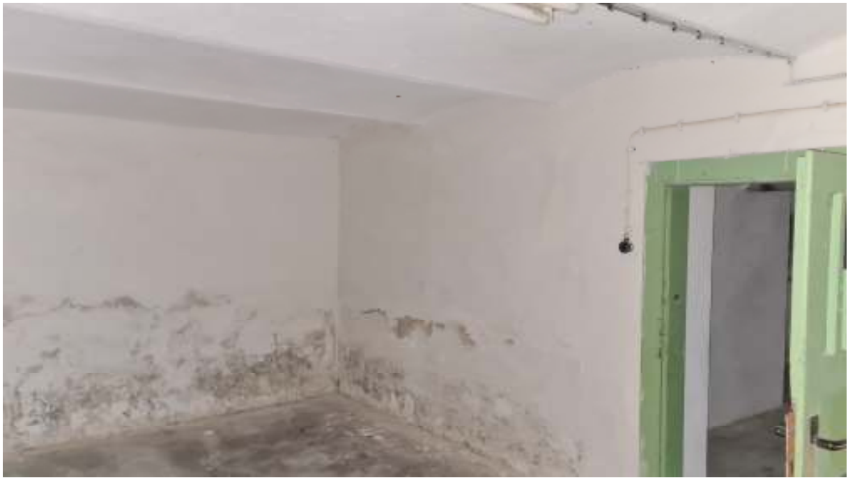
Zavlhnutie stien pod úrovňou terénu.
