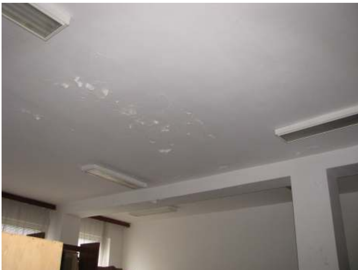
Zatečený panelový strop a priečla.
