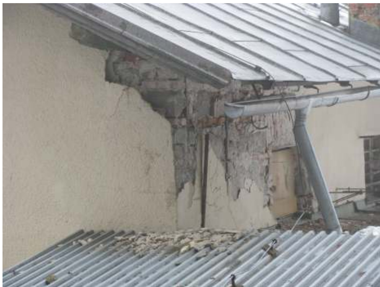
Stena poškodená zatekaním.
