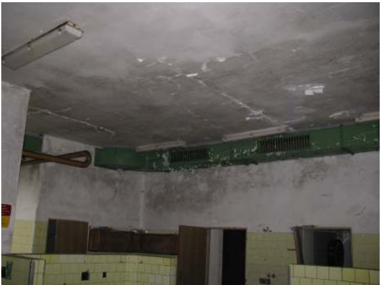
Zatečené stropné konštrukcie a steny.
