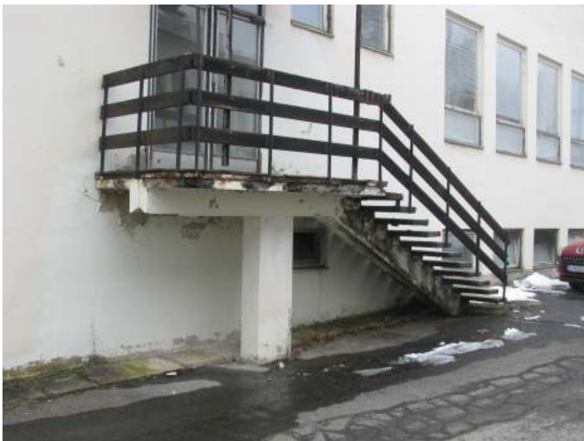
Poškodené vonkajšie schodisko.
