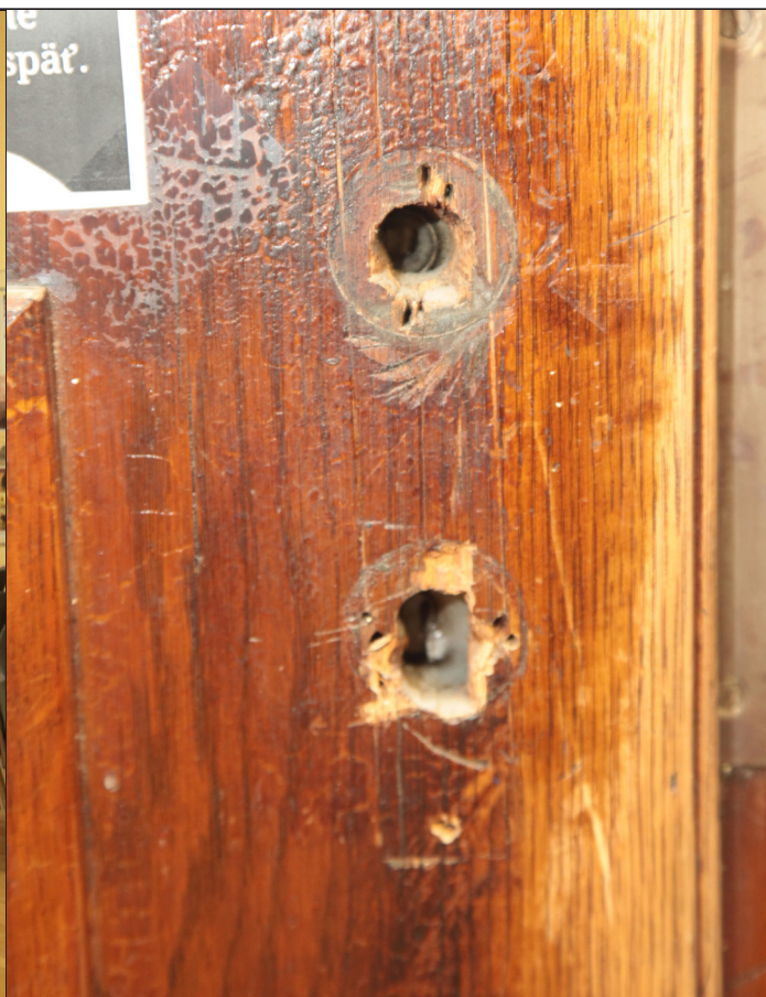
D6.1 - detail otvorov po kľučke a zámku
