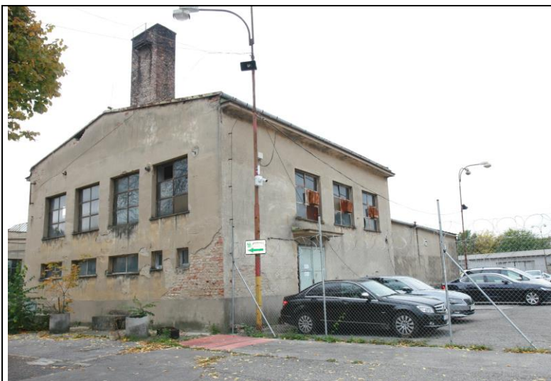
Obrázok IMG_8275.jpg Poškodená omietka obvodovej steny
