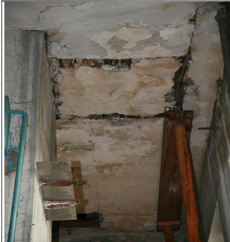
Obrázok IMG_8282.jpg Veľmi poškodený podhl'ad v havarijnom stave, zabezpečený podopretím
