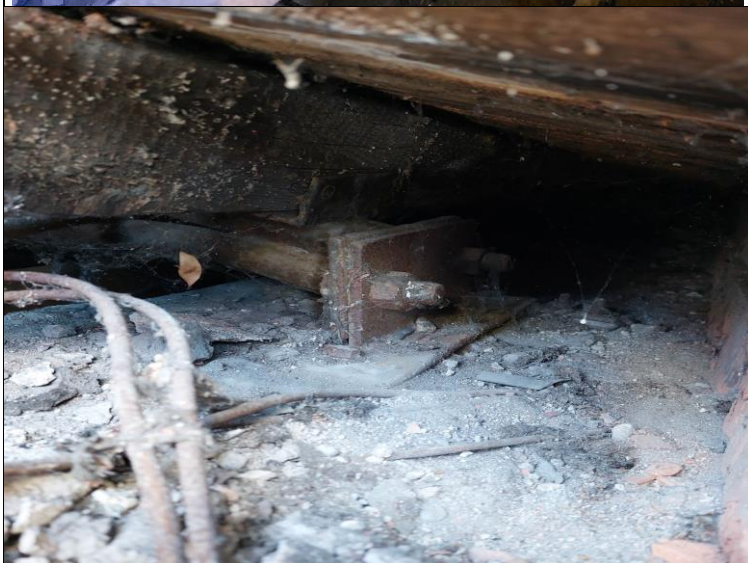
Obrázok 20211014_142313.jpg Konštrukcia strechy Priehradový nosník, kotvenie spodného pásu do obvodového venca
