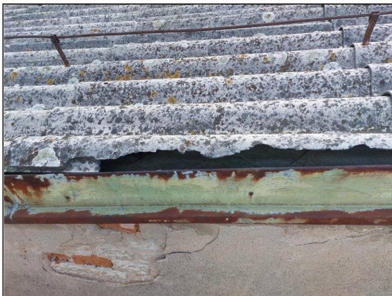
Obrázok 20211014_151119.jpg Strešná krytina – azbestocementové vlnovky
