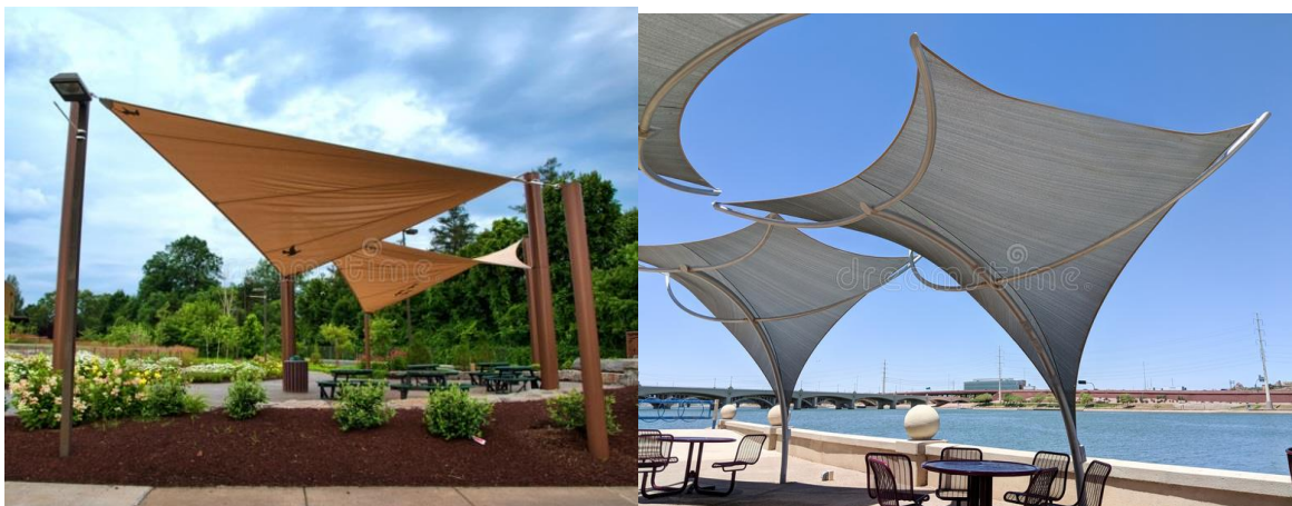
Obr. 30 Tienenie s použitím trojrohých plachiet
