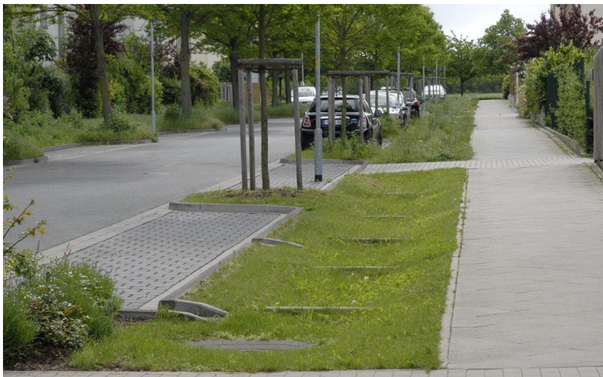
Obr. 18 Zadržiavanie dažďovej vody s komunikácie
