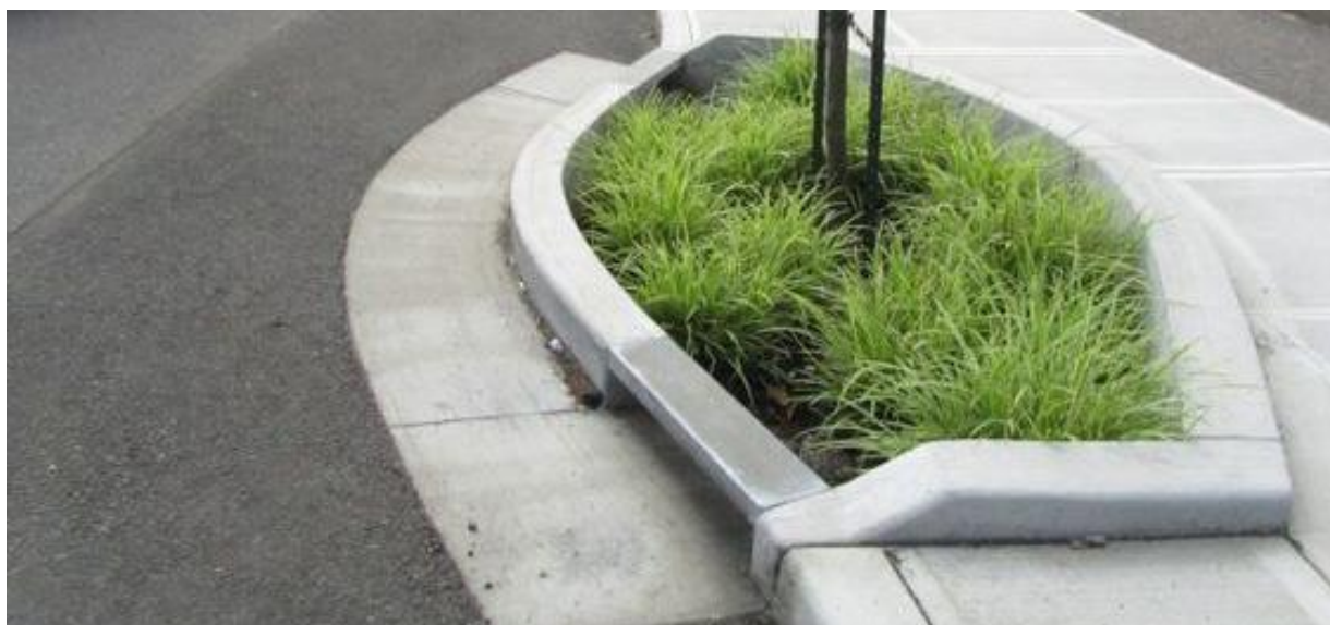
Obr. 19 Odvádzanie a zadržiavanie vody s komunikácie
