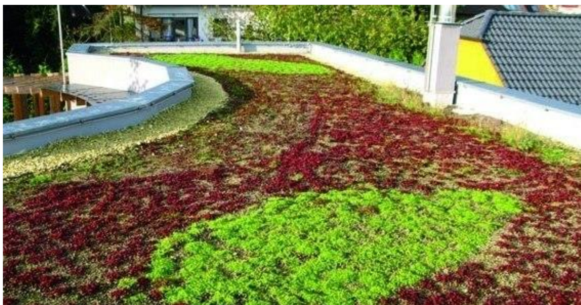
Obr. 37 Extenzívna zelená strecha
