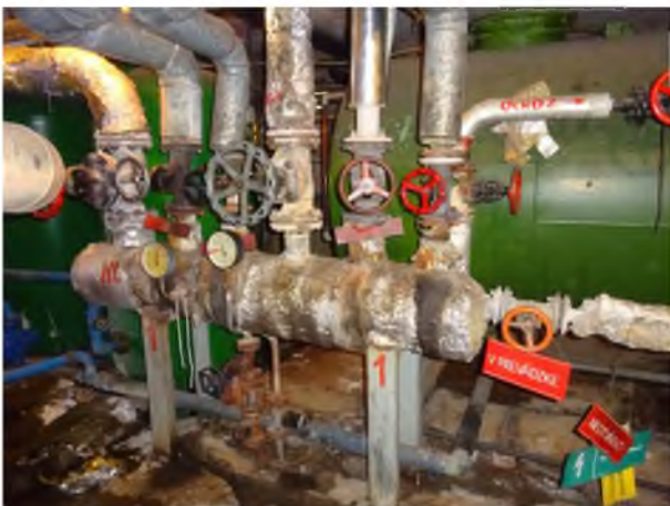
Obrázok 19 – Rozdeľovač pary 1 vo VS 2
