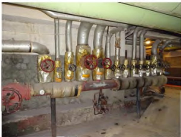
Obrázok 21 – Hlavný parný rozdeľovač
