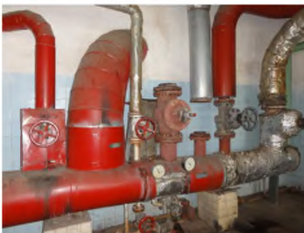
Obrázok 16 – Rozdeľovač pary vo VS 1
