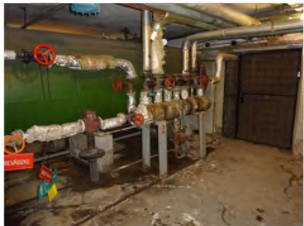
Obrázok 20 – Rozdeľovač pary 2 vo VS 2
