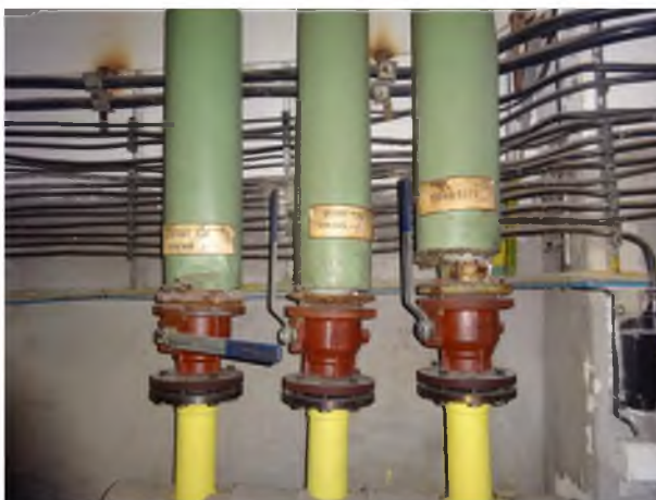
Obrázok 24 – Rozdeľovač TÚV pre monoblok
