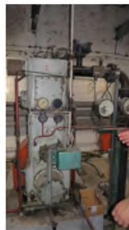
Obrázok 28 – Kompresor na výrobu stlačeného vzduchu
