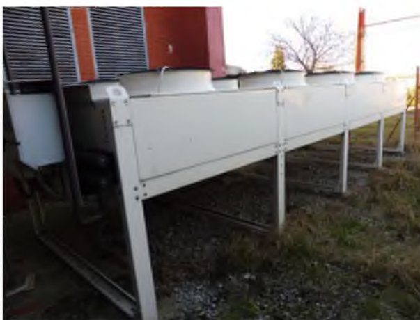
Obrázok 26 – Kondenzačná jednotka
