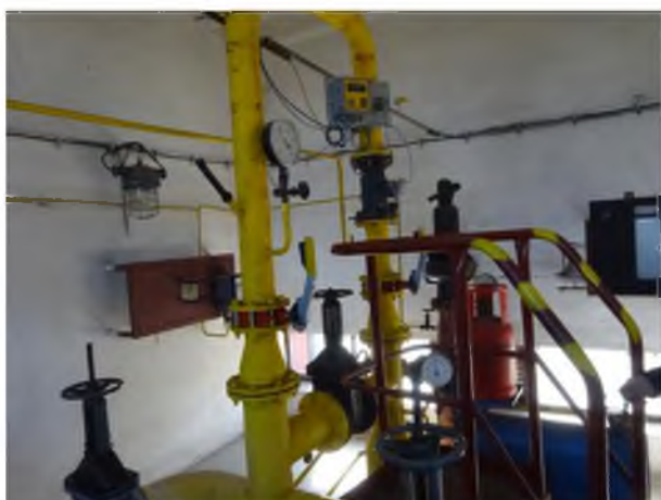
Obrázok 12 – Regulačná stanica plynu s prepočítavačom
