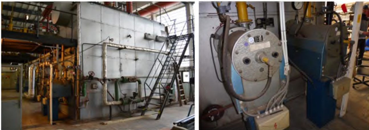
Obrázok 9 – Plynové parné kotly s horákmi
