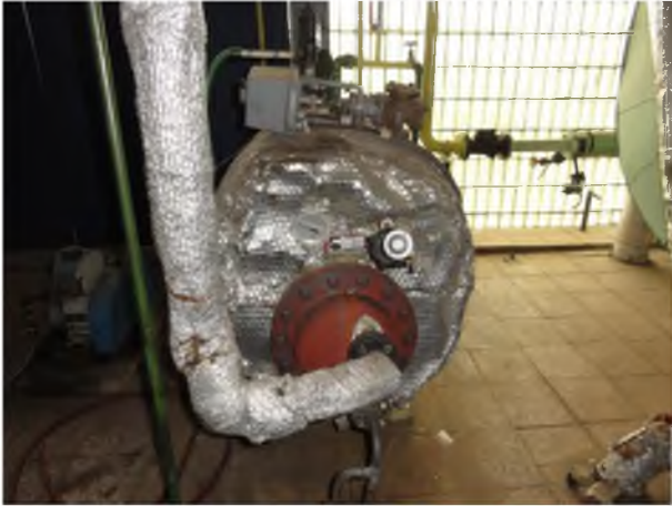
Obrázok 17 – Zásobníkový ohrievač vo VS 1
