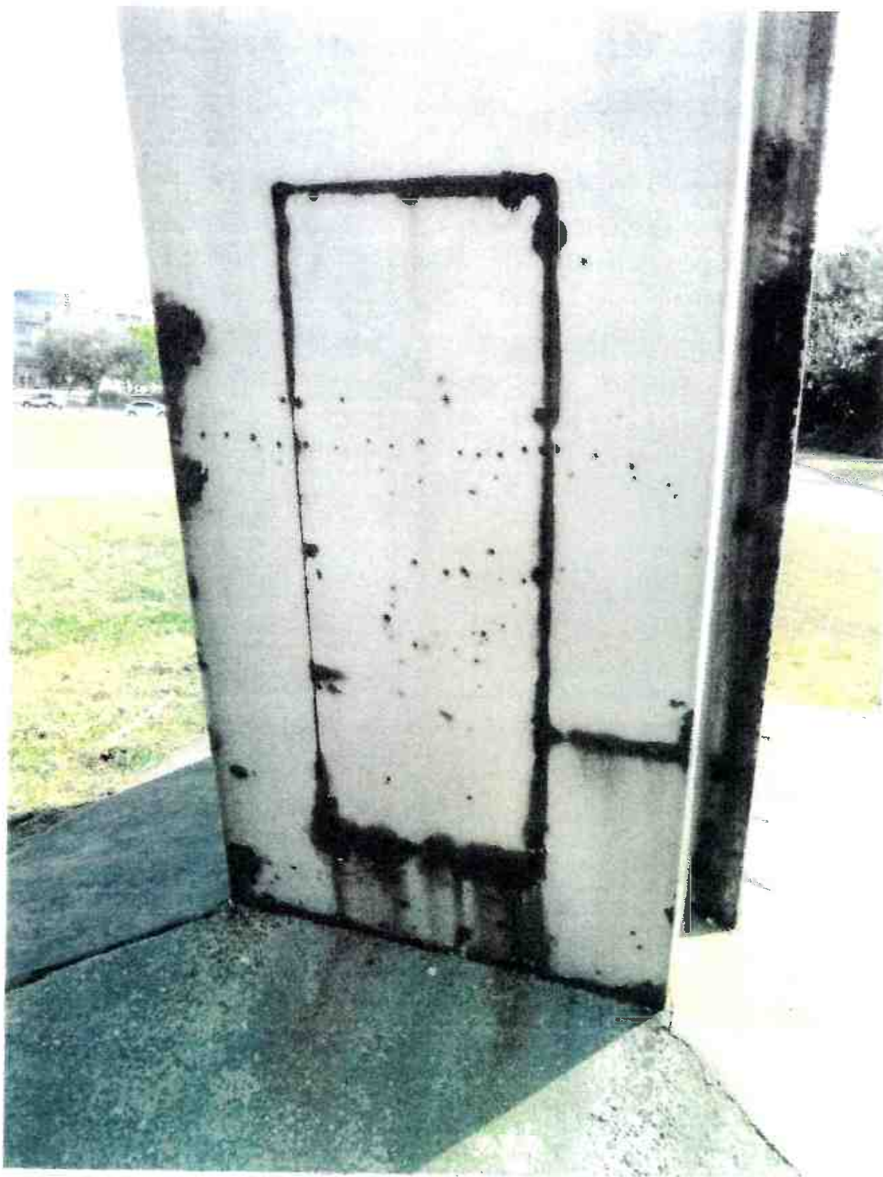
Obr. 3 - Vstupný otvor prekrytý priskrutkovaným plechom
