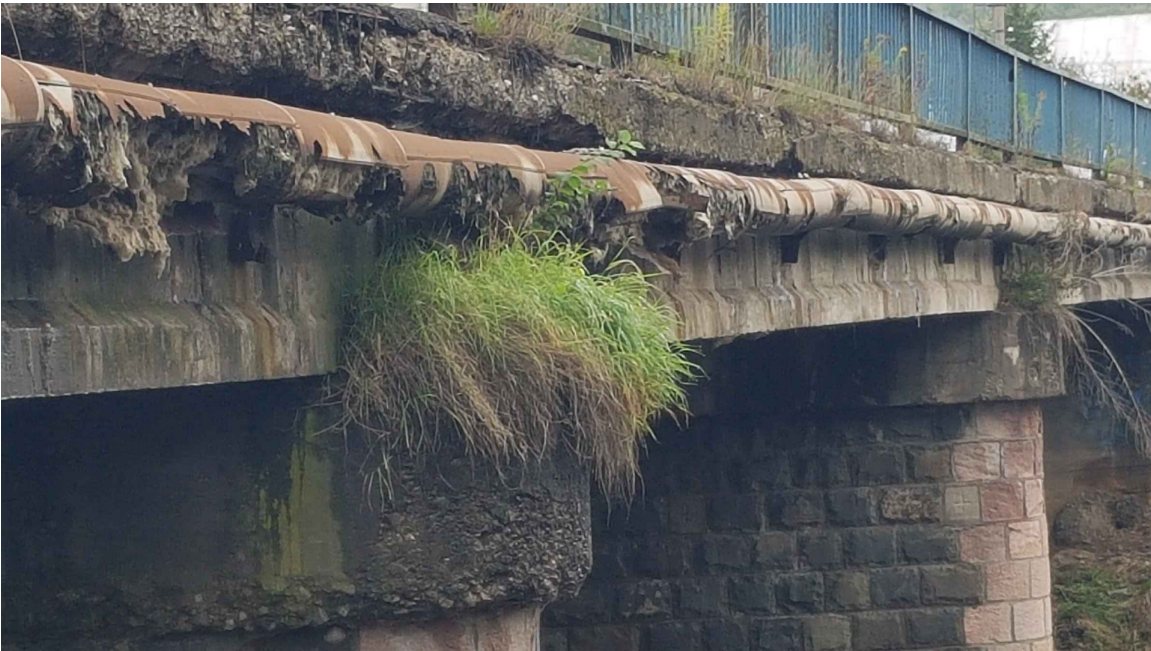
SÚČASNÝ STAV VODOVODNÉHO POTRUBIA A TEPELNEJ IZOLÁCIE
