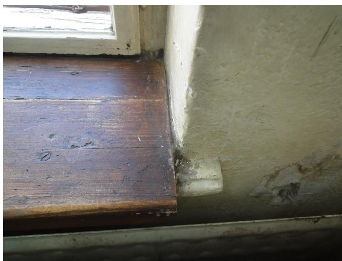
Profilácia vonkajšieho stredového križa / Novšia parapetná doska prekrývajúca pôvodnú
