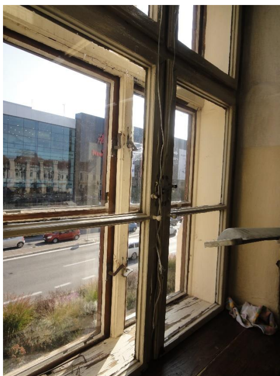
Vonkajšia okenný výplň / Uchytenie krídel k zvislej stojke pevného kríža pomocou polobrtlíkov
