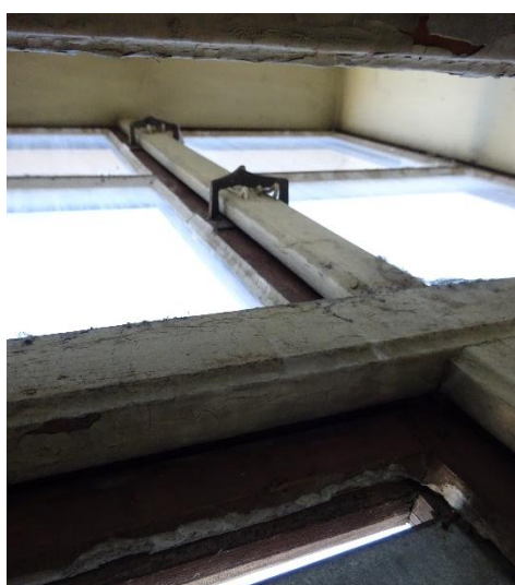
Profilácia vonkajšieho stredového križa / Novšia parapetná doska prekrývajúca pôvodnú
