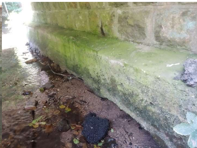
Obnažený základ opory, zanesenie koryta
