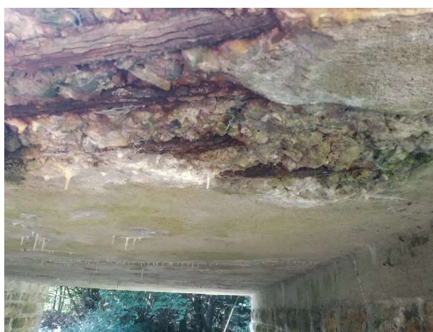
Detail obnaženej výstuže NK
