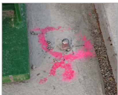
Obr č.1 - Pozorovaný bod – čapová značka na mostovke
