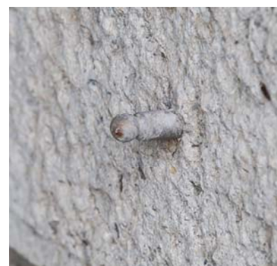
Obr č.2 - Pozorovaný bod – kotva na pilieri č.5 a č.34
