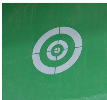
Obr č.1 - Pozorovaný bod – čapová značka na mostovke
