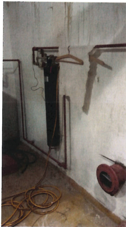
fotografia č.8 a 9 Dopúšťač vody s filtrom do ÚK, zmäkčovač vody v strojovni ÚK v suteréne
