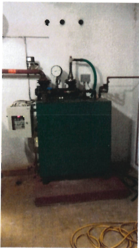
fotografia č.8 a 9 Dopúšťač vody s filtrom do ÚK, zmäkčovač vody v strojovni ÚK v suteréne
