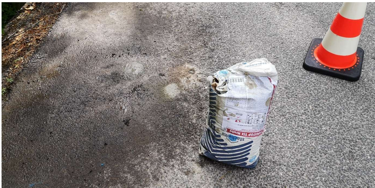
Obr. 5 Vyspravenie miest po odbere jadrových vývrtv
