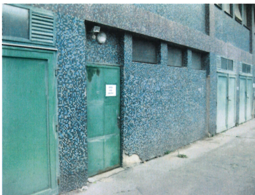
fotografia č.4 Zadný vstup na 1.PP do budovy OÚ Michalovce od ulice Jaroslawskej
