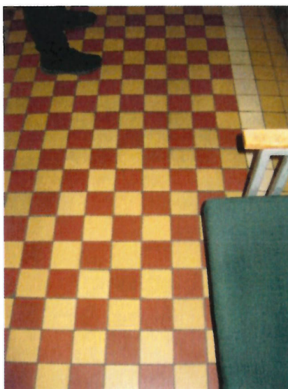
fotografia č.24 Dlažba na chodbe odbor pozemkový a lesný
