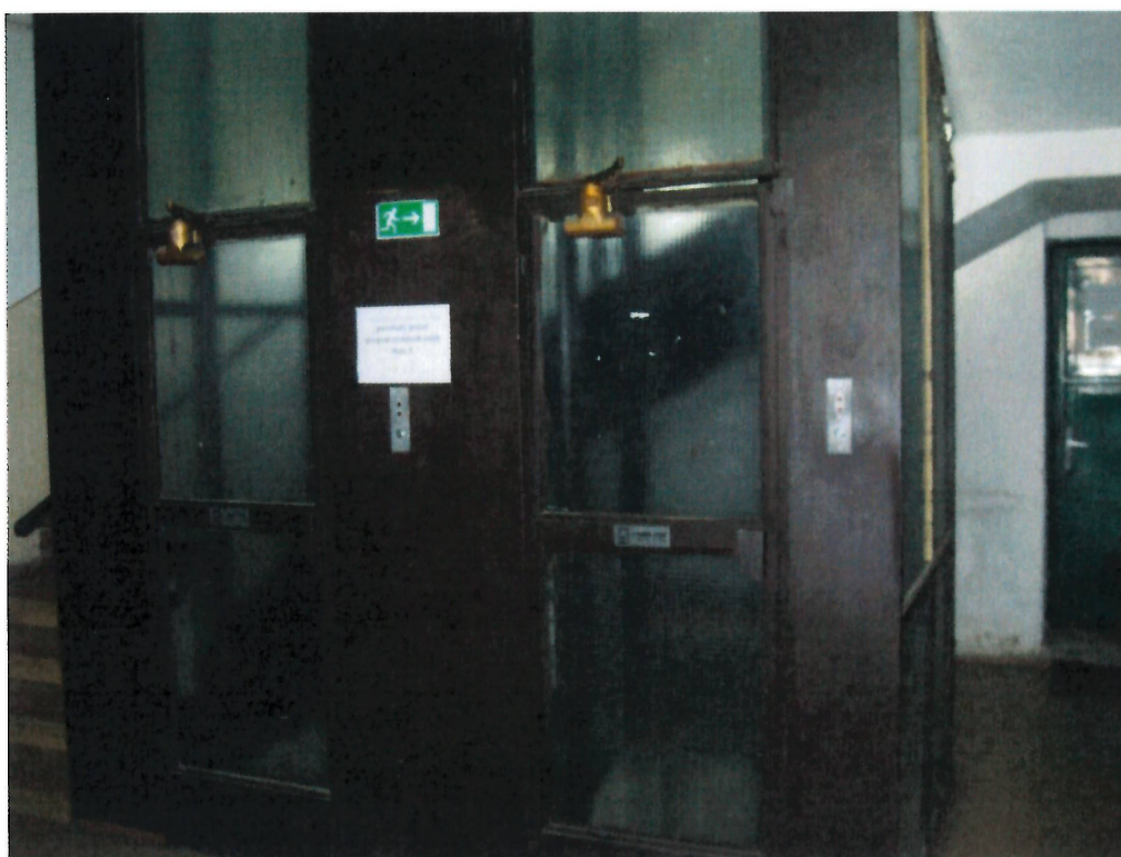
fotografia č.6 Výťahy v budove OÚ Michalovce
