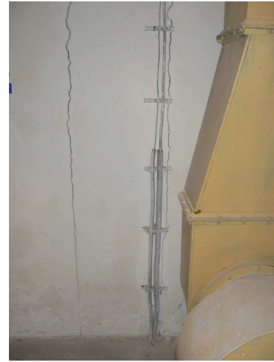
F56 Detail zvislých trhlín v spodnej časti napojenia priečok na stĺp v strojovni VZT
