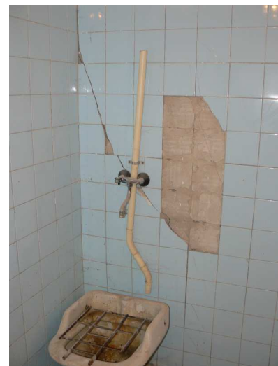
F6 Šikmá a zvislá trhlina v priečke medzi skladom a miestnosťou prípravy zeleniny
