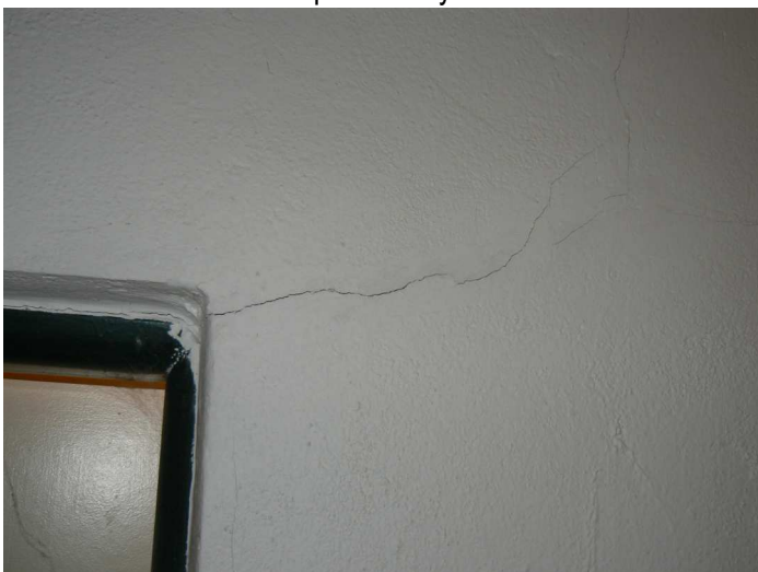
F5 Trhlina pri dverách v priečke medzi chodbou a miestnosťou prípravy zeleniny
