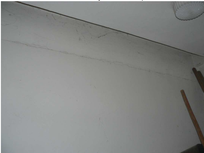
F65 Detail trhliny v styku fasádneho muriva a žb. venca v mieste budúceho skladu mrazených potravín
