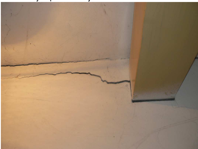
F59 Detail priebehu trhlín v hornej časti priečky medzi skladosm a strojovňou VZT
