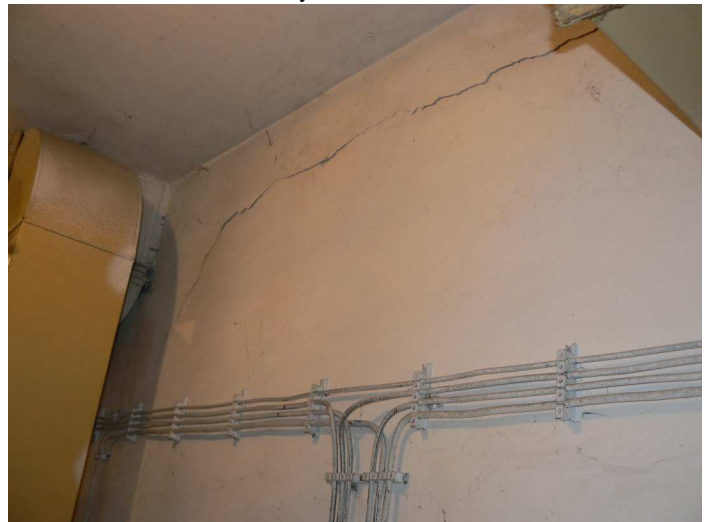
F54 Priebeh trhlín v hornej časti priečky medzi chodbou k miestnostiam chladenia a strojovňou VZT
