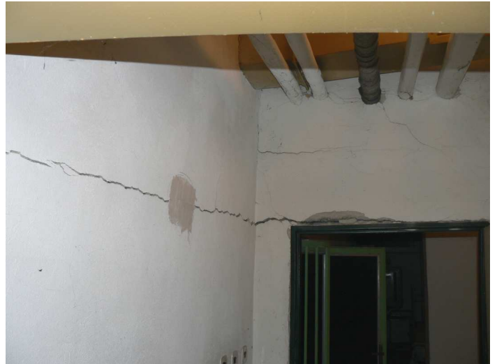
F64 Detail horizontálnej trhliny v styku priečok vnútornej chodby k suchému skladu potravín
