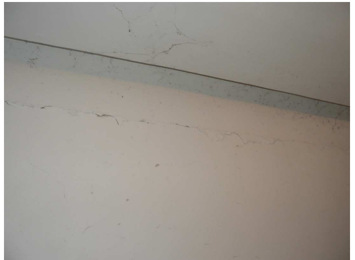
F36 Detail horizontálnej trhliny v obvodovej stene skladu medzi murivom a žb. vencom
