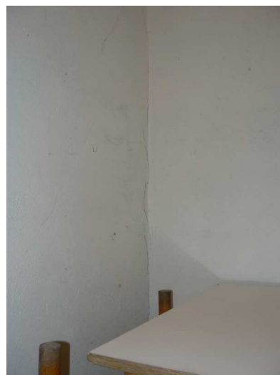
F68 Detail zvislej trhliny v styku priečok v budúcom sklade DKP
