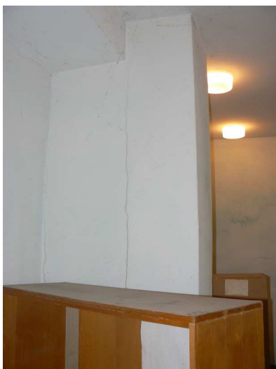
F67 Detail zvislej trhliny v styku žb. stĺpa a obmúrovky inštaláčného jadra v budúcom sklade DKP
