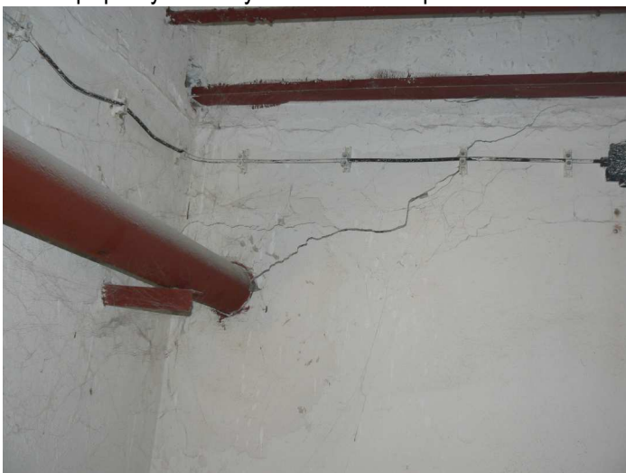
F11 Šikmá trhlina pri prestupe kanalizačného potrubia v priečke medzi skladmi
