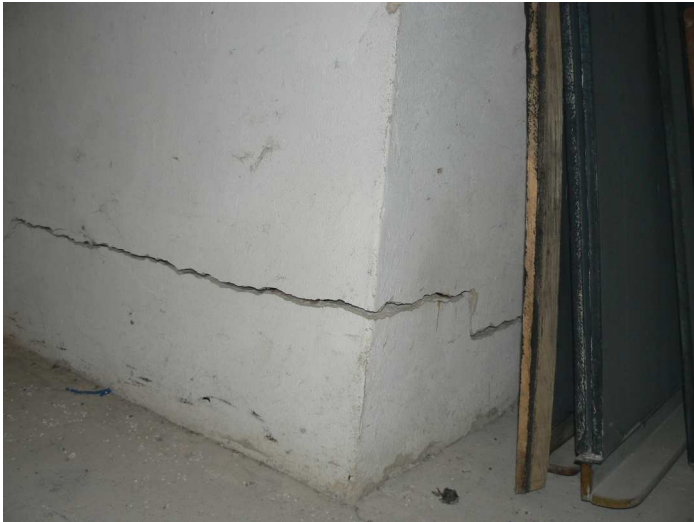
F63 Detail priebehu trhliny v priečke medzi budúcim sklantom DKP a suchým sklantom potravín
