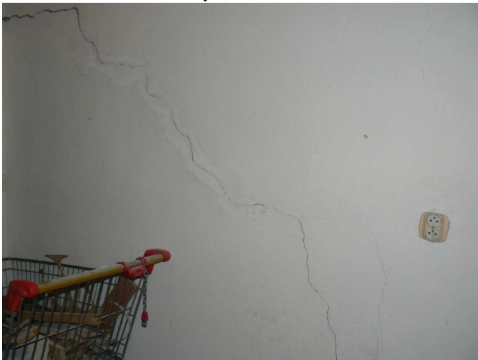
F53 Priebeh trhlín v priečke medzi strojovňou vzduchotechniky a chodbou
