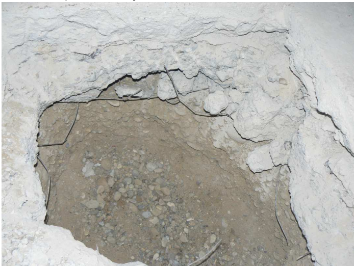
F15 Detail skladby prepadnutej podlahy a podložia v prieskumnej sonde "S2" miestnosti skladu
