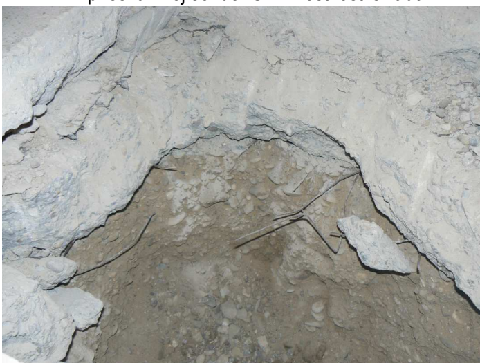
F17 Detail skladby prepadnutej podlahy a podložia v prieskumnej sonde "S2" miestnosti skladu
