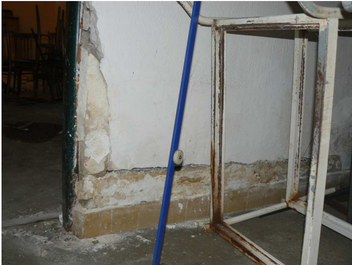
F27 Pohľad na horizontálnu trhlinu v priečke medzi skladoom a chodbou nad presadnutou podlahou
