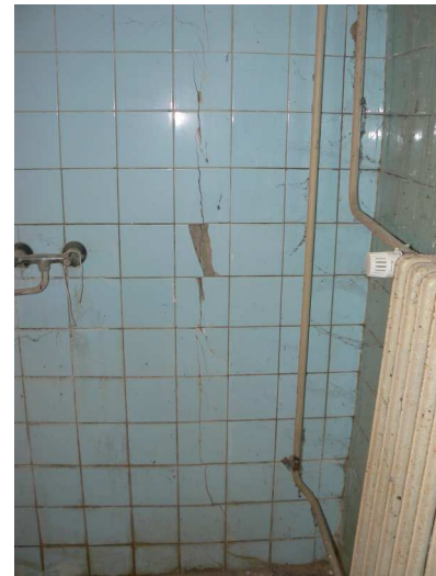
F8 Zvislá trhlina v napojení priečky na stĺp medzi skladom a miestnosťou prípravy zeleniny
