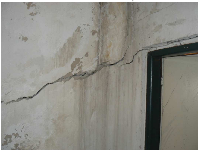
F41 Detail priebehu trhlín v rohovom styku priečok strojovne chladenia v úrovni nadpražia dverí
