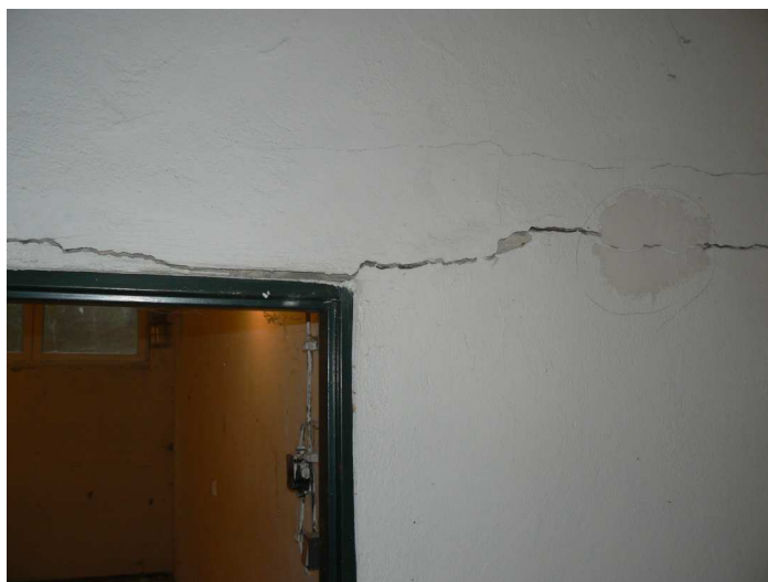
F20 Horizontálna trhlina v priečke medzi sklalom a chodbou nad dverami
