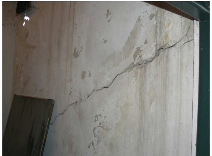
F40 Detail horizontálnej trhliny v priečke medzi skladom a strojovňou chladenia v úrovni nadpražia dverí
