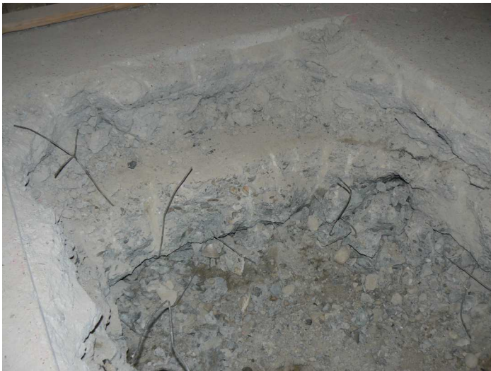
F13 Detail skladby prepadnutej podlahy a podložia v prieskumnej sonde "S1" miestnosti skladu
