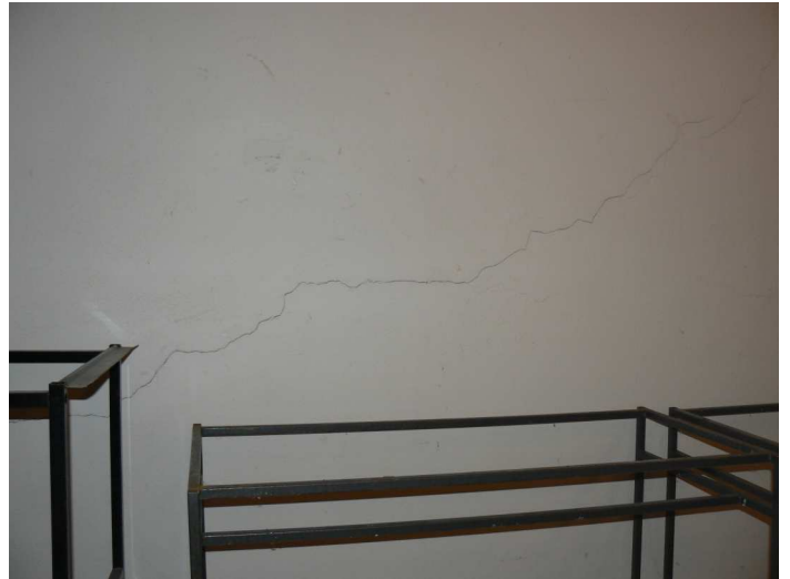
F34 Detail priebehu trhliny v priečke medzi chladiacou miestnosťou a sklalom
