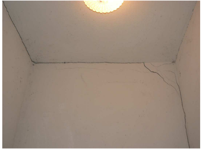
F2 Trhliny v styku priečok a tesne pod stropu miestnosti upratovačky
