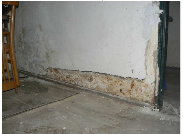
F30 Pohľad na horizontálnu trhlinu v priečke medzi chodbou a skladoom nad presadnutou podlahou
