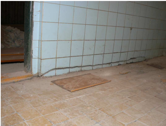
F7 Horizontálna trhlina v priečke medzi sklado a miestnosťou prípravy zeleniny nad podlahou
