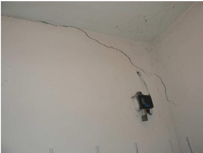
F43 Detail priebehu trhlín v hornej časti styku priečky a stĺpa miestnosti strojovne chladenia
