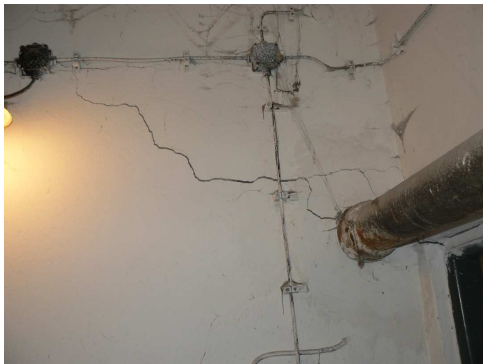
F22 Detail priebehu trhliny v priečke medzi skladiami pri vstupných dverách z chodby
