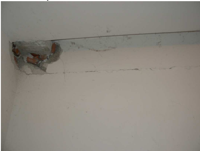
F35 Detail horizontálnej trhliny v obvodovej stene skladu medzi murivom a žb. vencom
