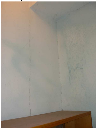
F69 Detail zvislej trhliny v styku žb. stĺpa a obmúrovky inštaláčného jadra v budúcom sklade DKP
