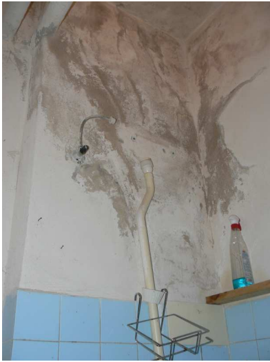
F1 Zatečený horný roh miestnosti upratovačky nad výlevkou
