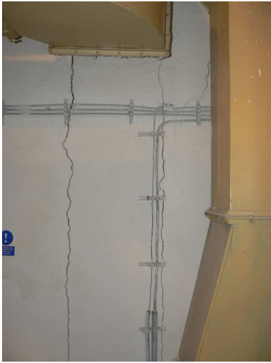
F55 Detail zvislých trhlín v hornej časti napojenia priečok na stĺp v strojovni VZT
