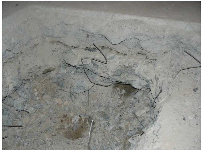
F14 Detail skladby prepadnutej podlahy a podložia v prieskumnej sonde "S1" miestnosti skladu
