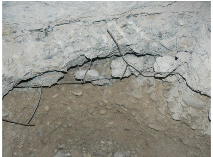
F16 Detail skladby prepadnutej podlahy a podložia v prieskumnej sonde "S2" miestnosti skladu
