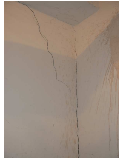
F44 Detail priebehu trhlín v hornej časti rohového styku priečok miestnosti strojovne chladenia
