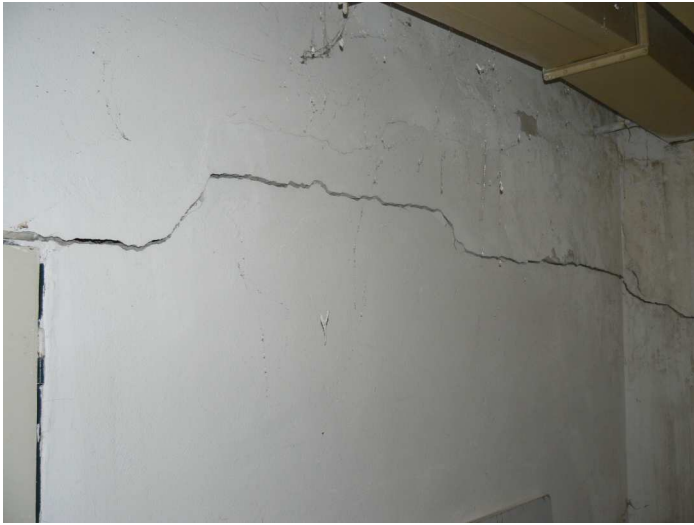
F31 Pohľad na priebeh trhliny v priečke medzi chodbou a sklalom v úrovni nadpražia dverí
