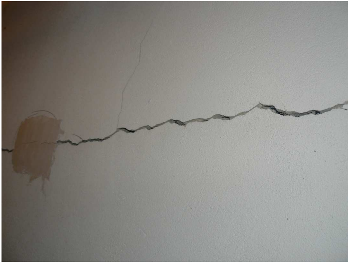
F61 Detail horizontálnej trhliny v priečke medzi strojovňou VZT a vnútornou chodbou skladu
