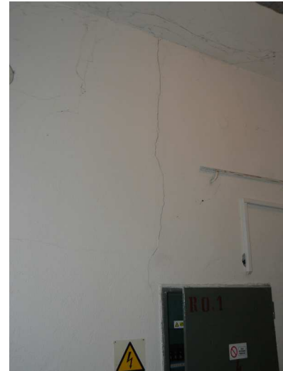
F4 Zvislá trhlina v priečke chodby nad elektrorozvádzačom
