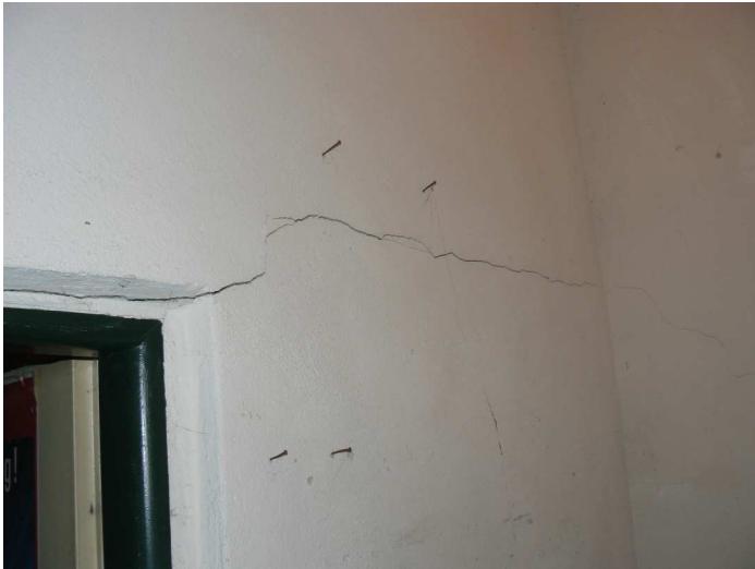
F3 Trhlina v priečke medzi schodiskovou halou a miestnosťou upratovačky
