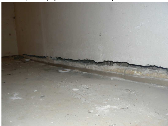
F24 Detail horizontálnej trhliny v priečke medzi skladiami nad presadnutou podlahou
