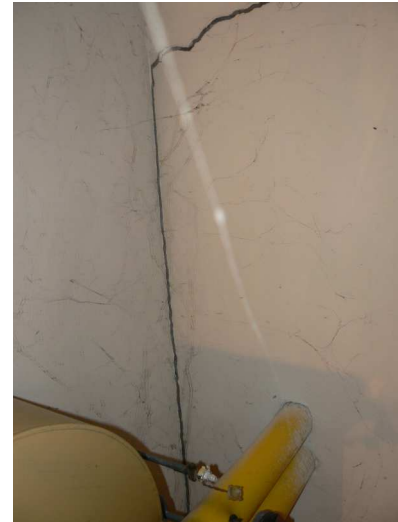
F58 Detail priebehu trhlín v hornej časti rohového styku priečok strojovne VZT
