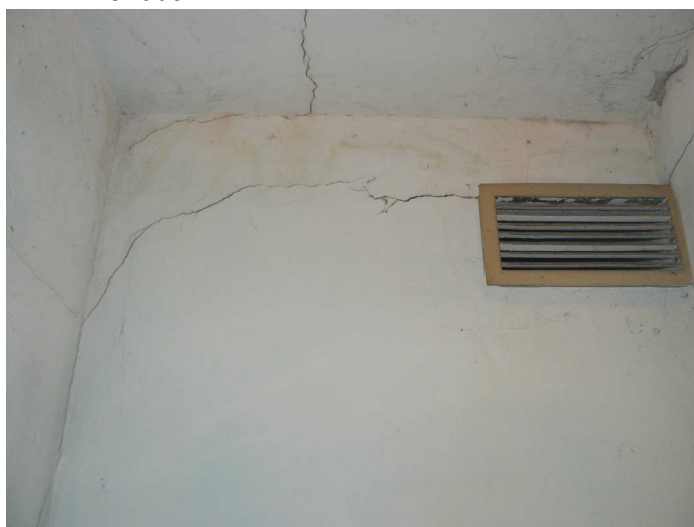
F72 Detail priebehu trhlín v priečke medzi chodbou k skladu suchých potravín a budúcim sklado DKP
