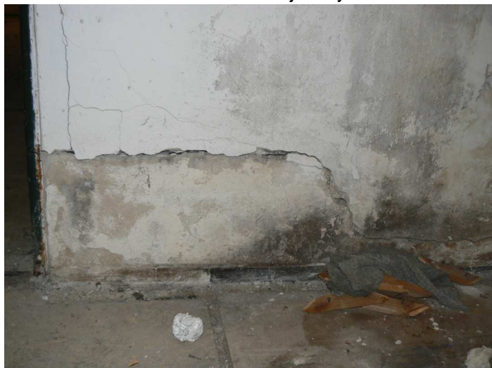
F21 Horizontálna trhlina v priečke medzi chodbou a sklalom nad presadnutou podlahou pri dverách
