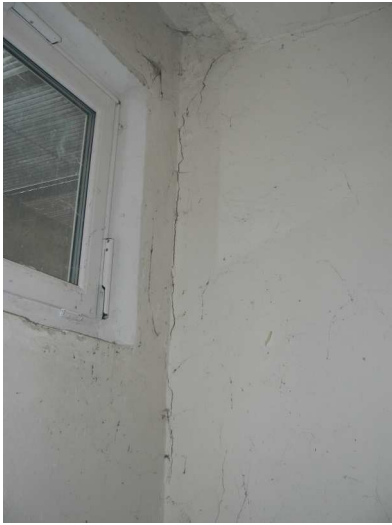
F25 Detail zvislej trhliny v hornej časti napojenia priečky medzi skladmi na fasádne murivo
