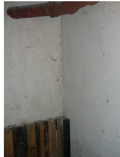
F10 Zvislá trhlina v styku priečok skladu za miestnosťou prípravy zeleniny
