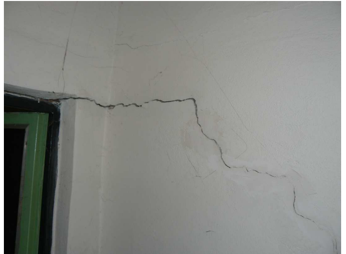
F52 Priebeh trhlín v priečke medzi strojovňou vzduchotechniky a chodbou
