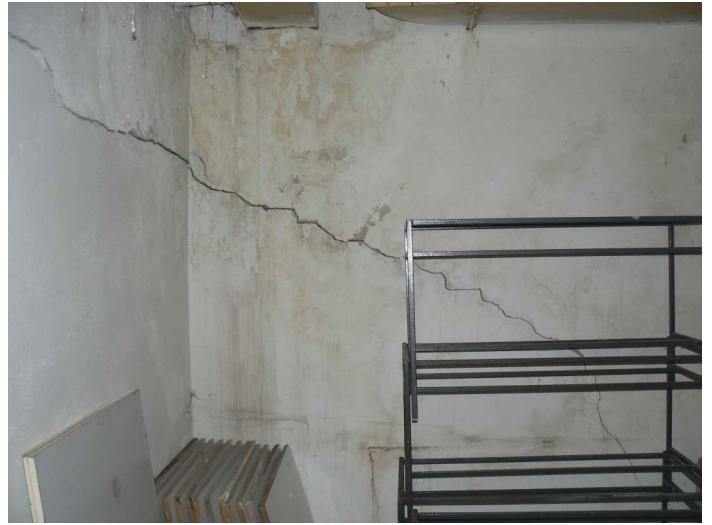
F32 Detail priebehu trhlín v styku priečok v rohu skladu vedľa chodby
