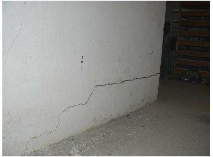
F62 Detail priebehu trhliny v priečke medzi budúcim sklantom DKP a suchým sklantom potravín
