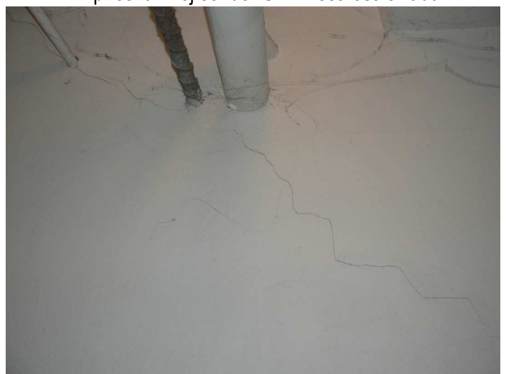
F18 Detail trhlín v priečke medzi skladištom a chodbou pri prestupe inštalovaných potrubí
