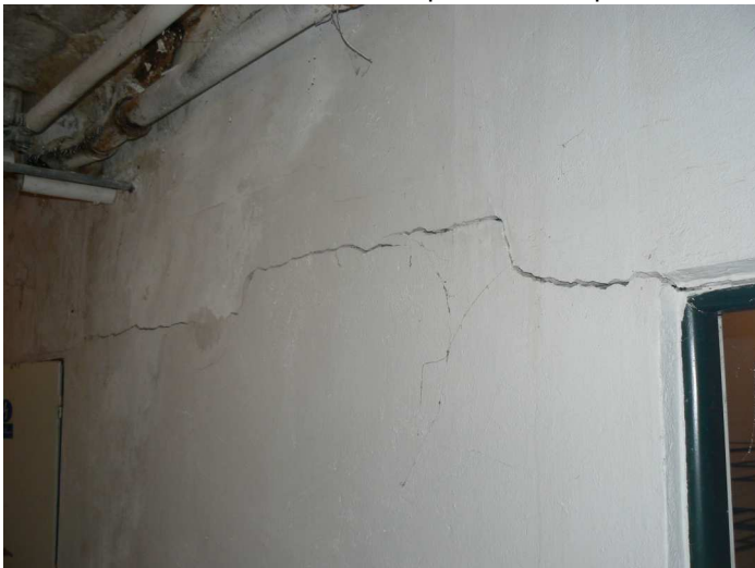
F29 Pohľad na priebeh trhliny v priečke medzi skladoom a chodbou v úrovni nadpražia dverí
