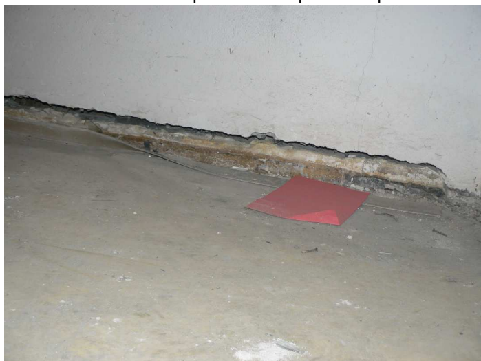
F23 Detail horizontálnej trhliny v priečke medzi skladiami nad presadnutou podlahou
