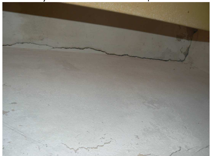
F42 Detail horizontálnej trhliny vstyku priečky a stropného prievlaku strojovne chladenia
