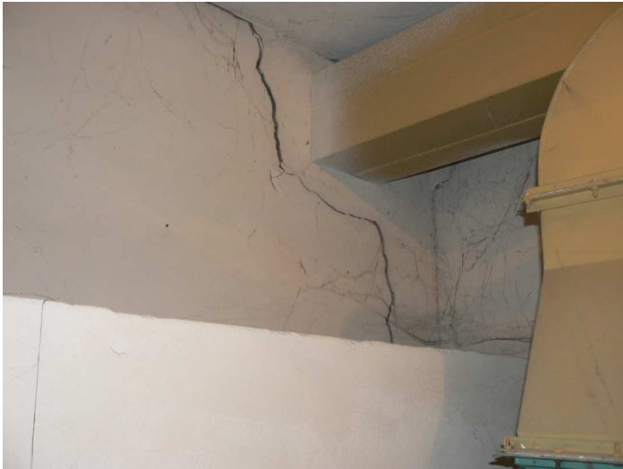
F57 Detail priebehu trhlín v hornej časti rohového styku priečok strojovne VZT
