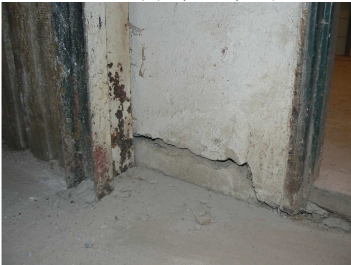
F9 Horizontálna trhlina v priečke medzi miestnosťou prípravy zeleniny a sklado nad podlahou
