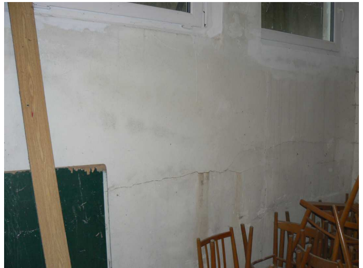
F38 Detail horizontálnej trhliny vo fasádnej stene skladu v jej napojení na dno anglického dvorca
