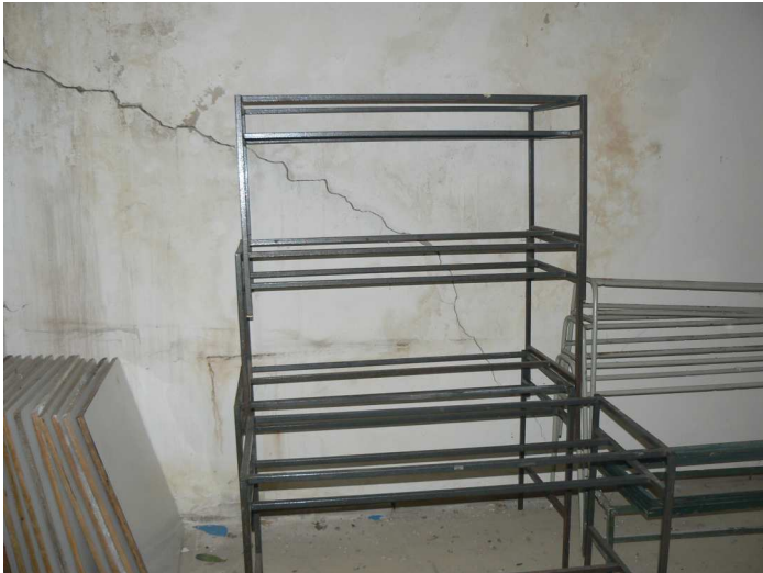
F33 Detail priebehu trhliny v priečke medzi strojovňou chladienia a sklalom
