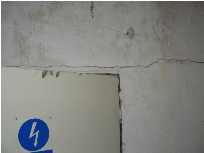
F39 Detail horizontálnej trhliny v priečke medzi strojovňou chladenia a chodbou v úrovni nadpražia dverí
