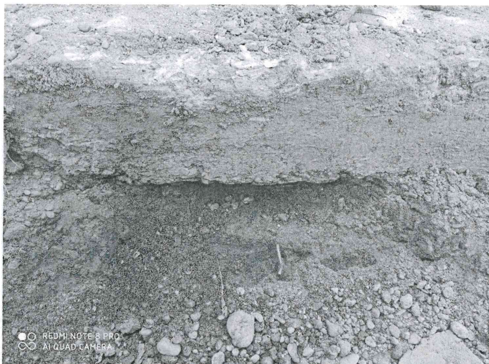
Obr. č.3 – nájdený cestný panel pod terajšou podlahou
