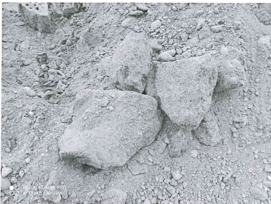
Obr. č.1 – nájdený stavebný odpad pod terajšou podlahou
