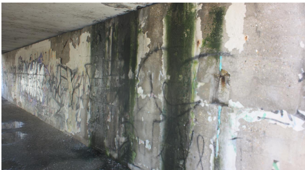
Obr. 6.1: Intenzívne zatekanie opory v dôsledku poškodených odvodňovačov.
