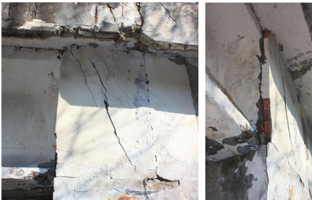
Obr. 6.2 Praskliny na krycej stienke opory, hrozí jej odpadnutie.
