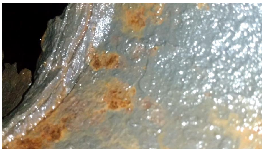
Obr. 6.8 Poškodené, odkorodované odvodňovacie rúry cez ktoré intenzívne zateká nosná konštrukcia – fotka endoskopom
