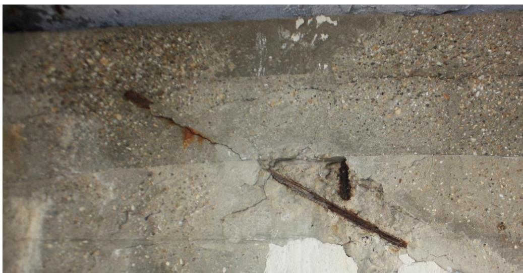
Obr. 6.3 Lokálne obnažená a korodujúca výstuž úložného prahu
