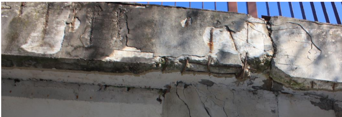
Obr. 6.6 Korózia výstuže ríms a odlamovanie krycej vrstvy – hrozba pádu kusov betónu na chodníky pod mostom
