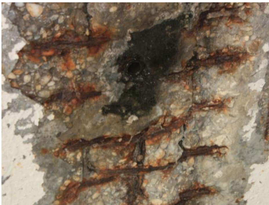
Obr. 6.9 Krátka odvodňovacia rúrka, ktorá spôsobuje zatekanie nosnej konštrukcie
