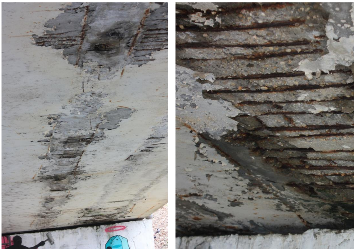
Obr. 6.4 Pokročilá korózia výstuže spojov medzi nosníkmi a strmeňov pri spodnom povrchu nosníkov
