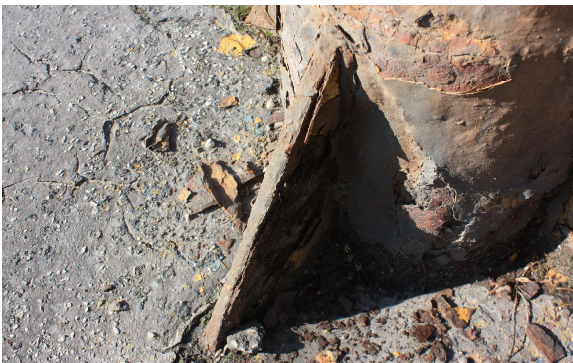
Obr. 6.12 Korózia stĺpov verejného osvetlenia
