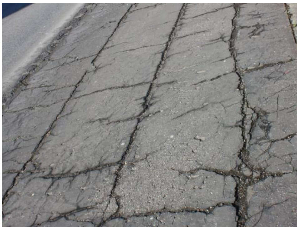
Obr. 6.10 Trhliny v asfalte na rímsach – rozpad krytu chodníka
