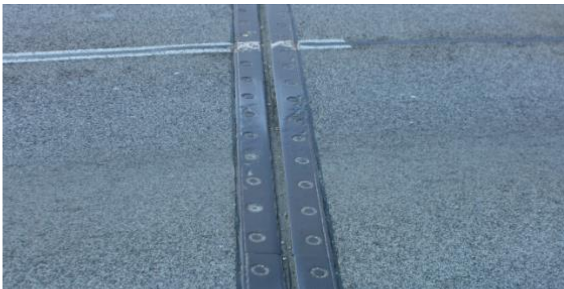
Obr. 6.11 Zanesenie mostných záverov suťou
