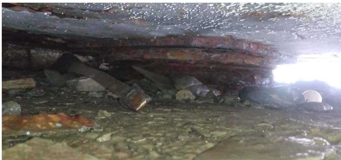
Obr. 6.7 Pokročilá korózia hrncových ložísk
