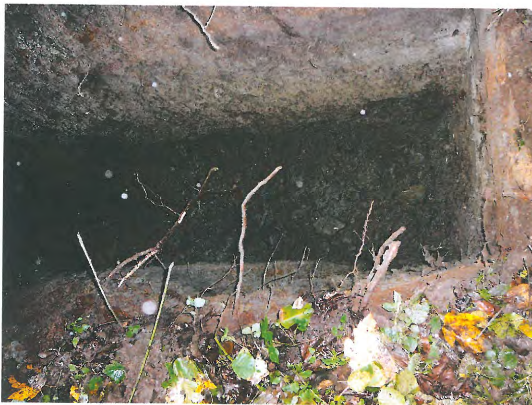
Obr.č.2 Kopená ryha KS na lokalite Alpinka, Čierna dolina s hĺbkou 4,0 m na dne je hladina podzemnej vody.
