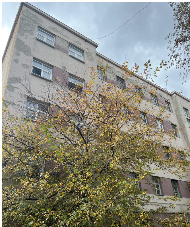
Obr. 8 Súčasný stav exteriéru administratívnej budovy Zdroj: spracovateľ súťažných podmienok a príloh
