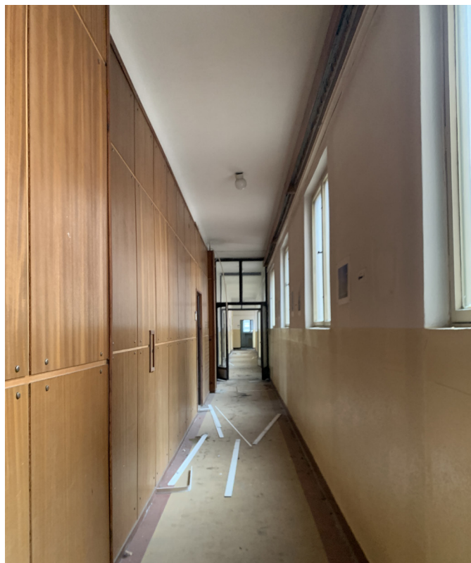
Obr. 9 Súčasný stav interiéru administratívnej budovy Zdroj: spracovateľ súťažných podmienok a príloh
