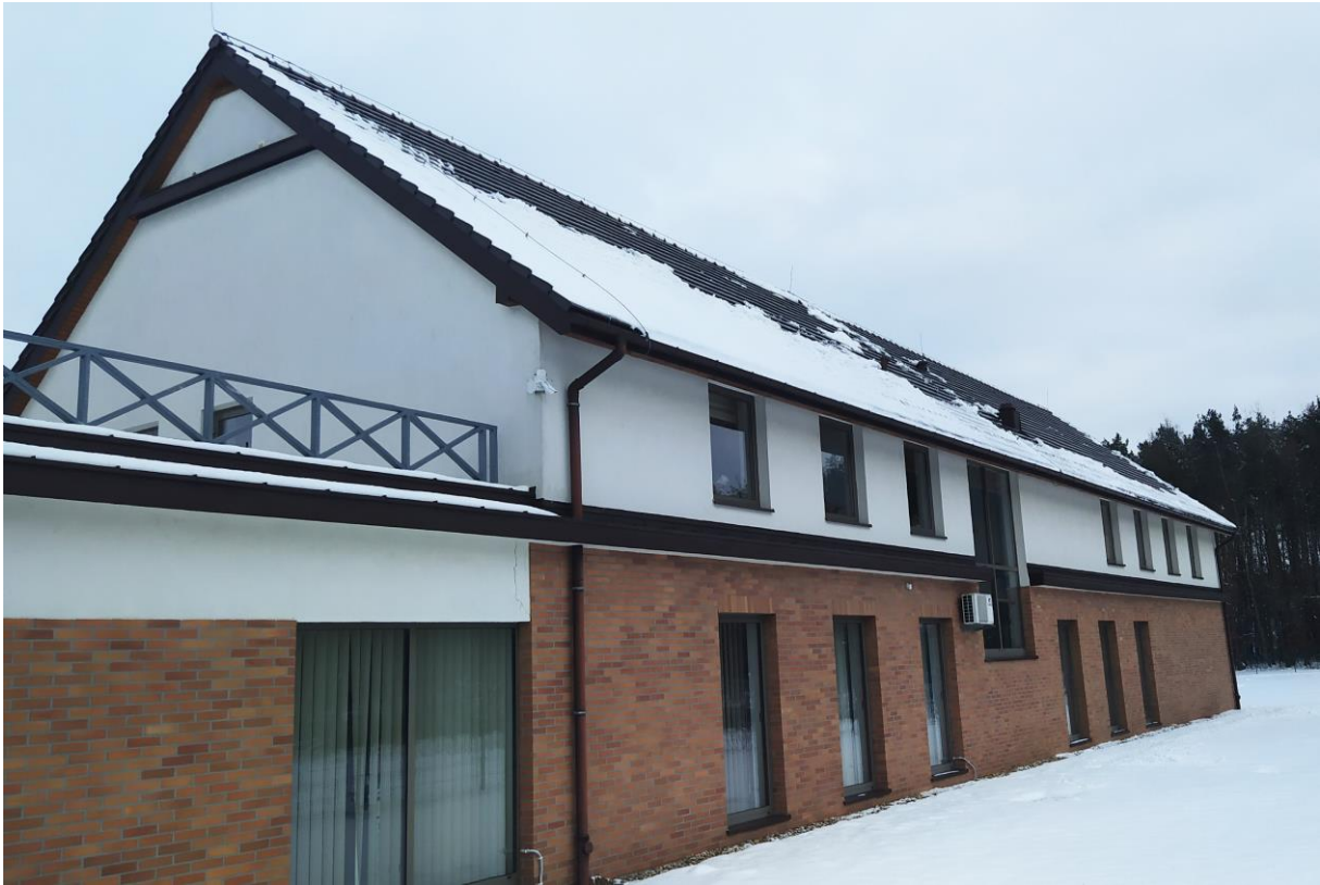
Widok ogólny budynku wraz z połącją przeznaczoną pod montaż instalacji fotowoltaicznej
