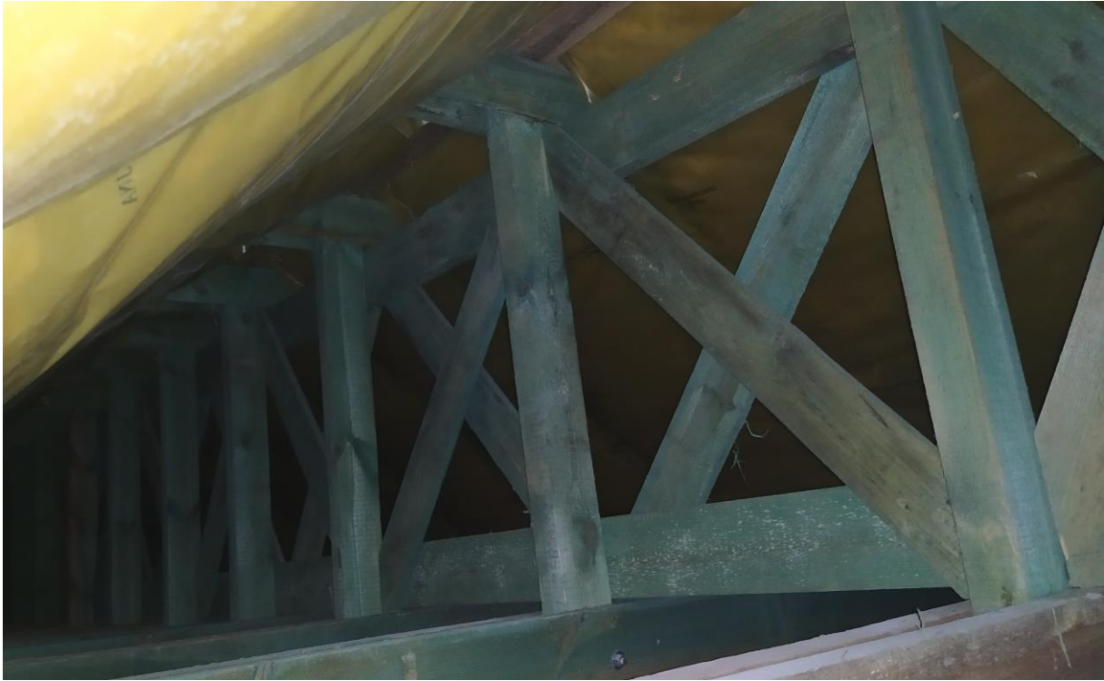
Kratownica podłużna usztywniająca więźbę dachową
