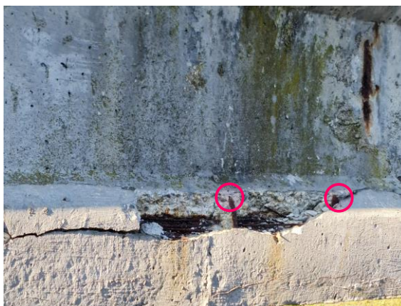
Obr. 77 Detail - poloha strmienkov
