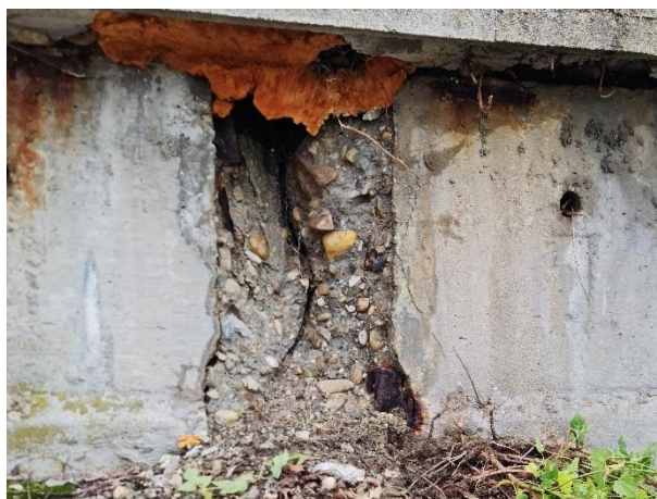
Obr. 6 Pohľad na dobetonávku nosníkov v nadpodperovej oblasti
