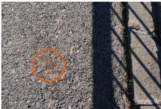
Obr. 49 Vyplnené miesto vývrtu vo vozovke
