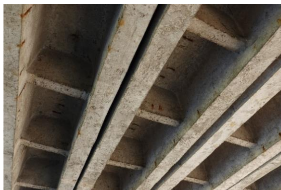
Obr. 63 Korózia mäkkej výstuže nosníkov
