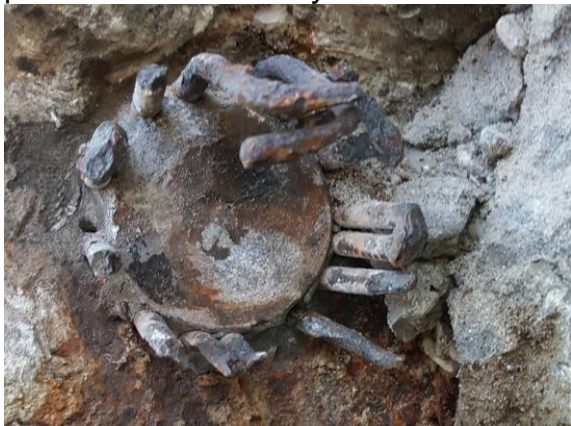
Obr. 72 Kóta kábla predpätej výstuže
