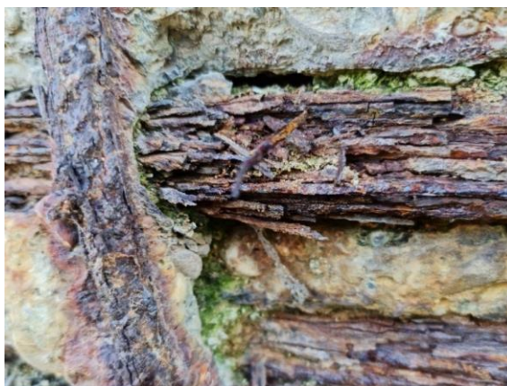
Obr. 79 Skorodovaná a potrhaná predpätá výstuž
