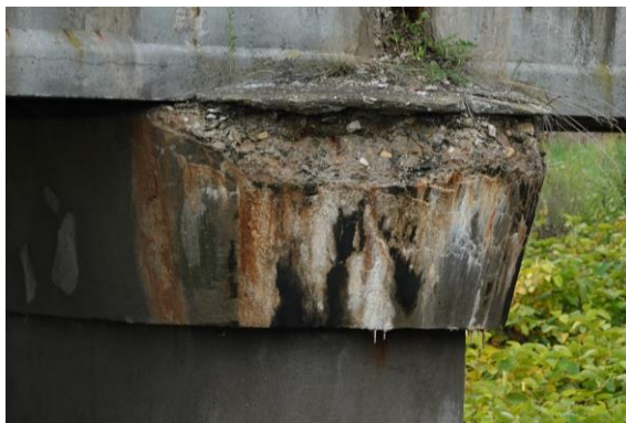
Obr. 16 Detail poruchy úložného prahu podpery
