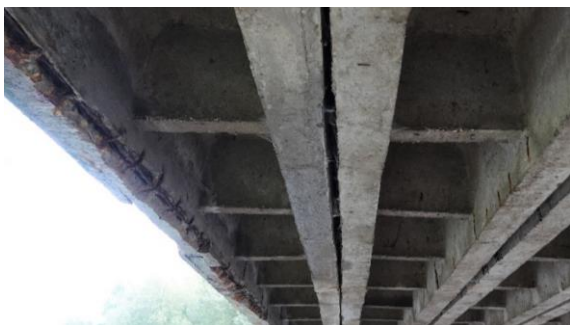
Obr. 23 Korózia káblov - pole 1, ľavá strana
