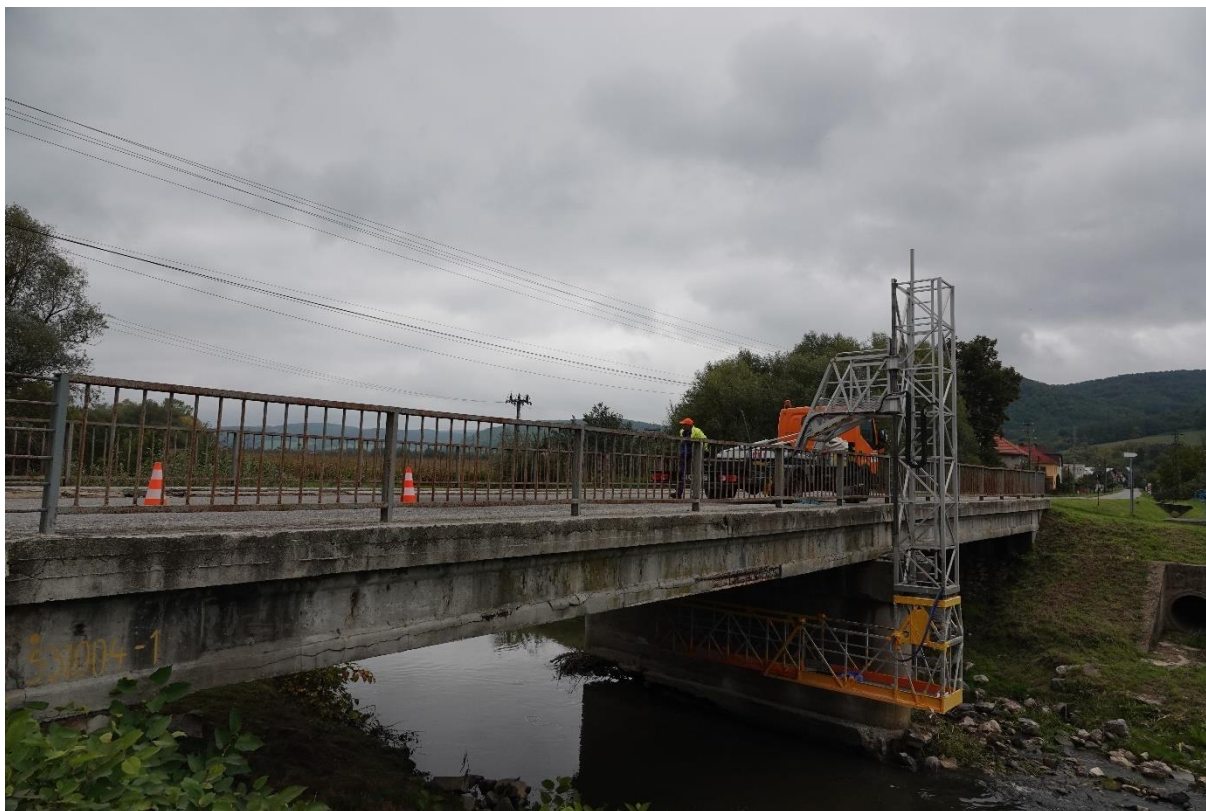
Obr. 5 Kontrola mosta z plošiny BARIN
