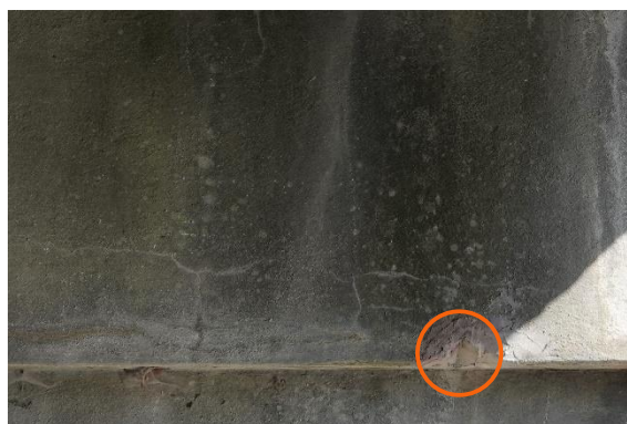
Obr. 69 Oprava sondy reprofilačnou maltou
