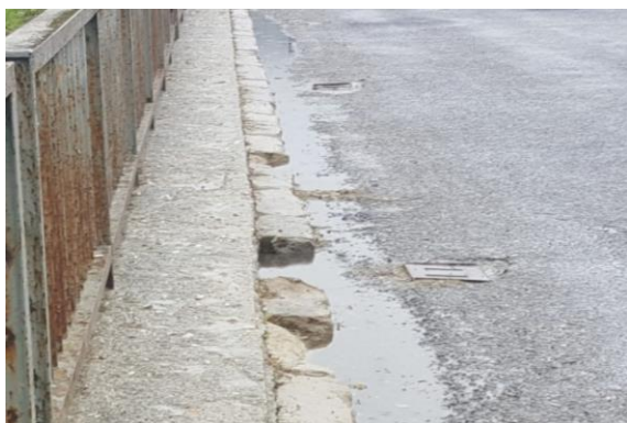
Obr. 41 Zlá poloha odvodňovačov
