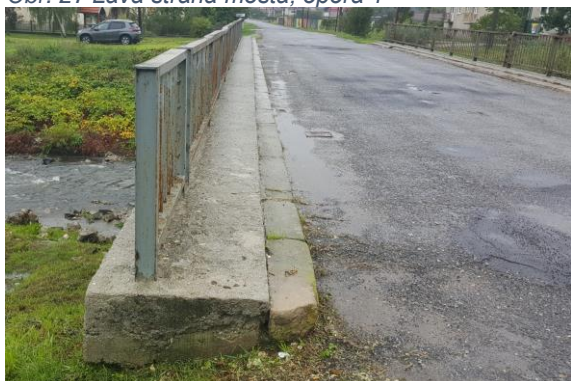
Obr. 29 Neodtekajúca voda na vozovke
