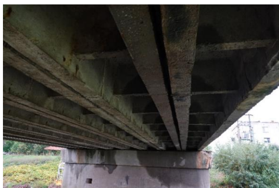
Obr. 34 Zatekanie NK - pole 2, ľavá strana
