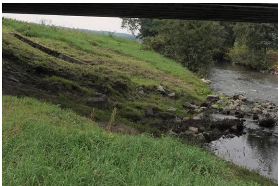
Obr. 45 Poškodenie obkladu svahu - opora 3
