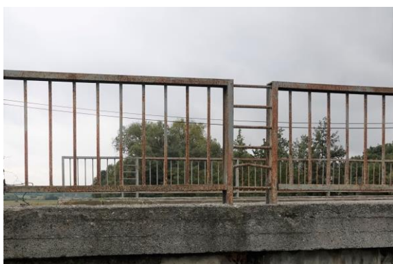
Obr. 43 Povrchová hrdza zábradlia
