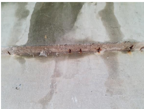
Obr. 17 Nízke krytie výstuže úložného prahu podpery
