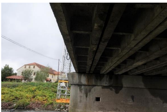
Obr. 33 Zatekanie NK - pole 2, pravá strana
