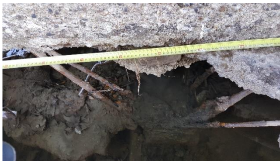
Obr. 71 Pohľad na zvisky pilóty a výstuž pilóty
