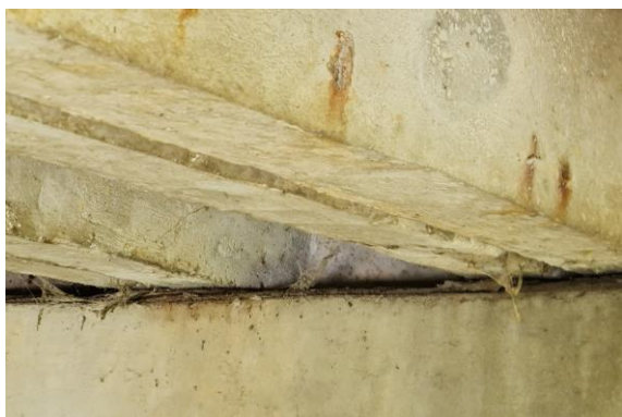
Obr. 35 Uloženie nosníkov na lepenke
