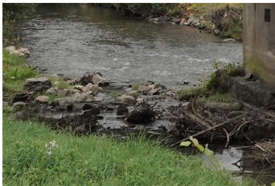
Obr. 46 Poškodenie koryta toku pod mostom v poli 2
