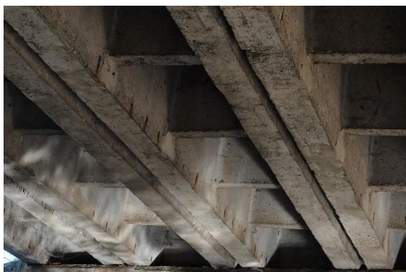
Obr. 62 Korózia strmienkov nosníkov
