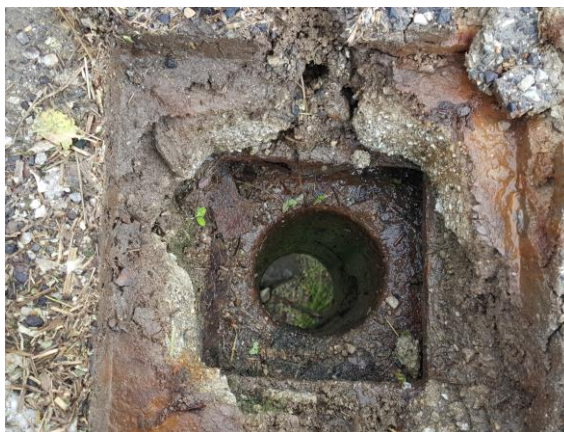
Obr. 40 Odkrytý priestor odvodňovača
