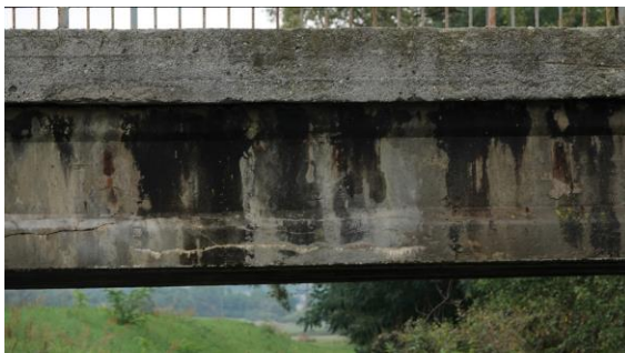
Obr. 20 Zatekanie krajného nosníka
