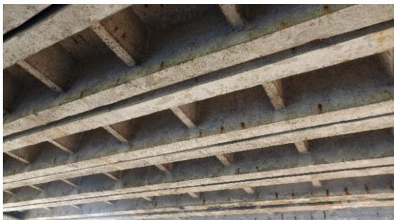
Obr. 19 Poruchy krytia mäkkej výstuže na NK
