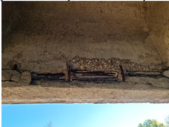
Obr. 73 Zainjektovanie kábla
