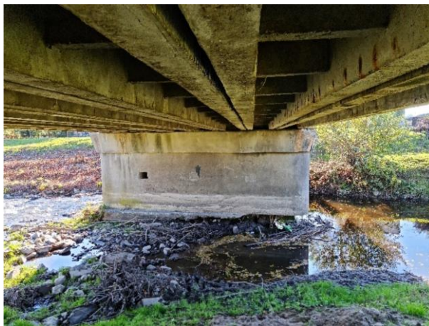
Obr. 47 Znečistenie pod mostom. Pohľad na zvláštne zaradenie v podpere.
