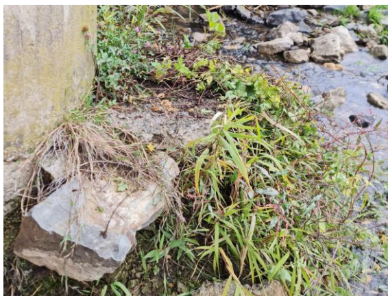
Obr. 18 Stav obkladu základu podpery na výtokovej strane
