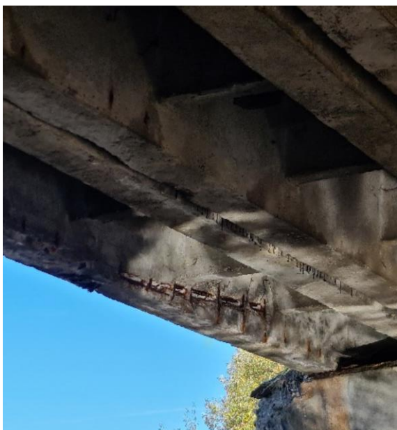
Obr. 25 Korózia výstuží - pole 1, ľavá strana
