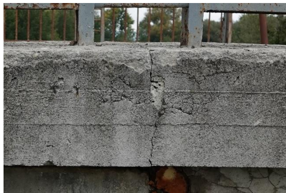
Obr. 38 Trhlina v rímse v mieste dilatácie - opora 3
