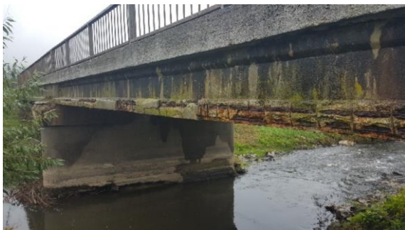
Obr. 21 Korózia káblov - pole 1, ľavá strana
