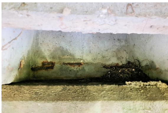
Obr. 36 Stav v mieste uloženia zatekaných nosníkov
