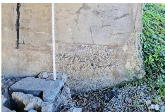
Obr. 44 Meranie sadnutia obkladu svahu - opora 1
