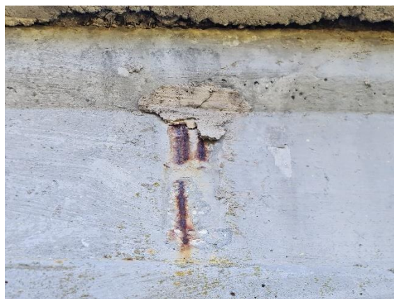
Obr. 65 Korózia výstuže priečneho kĺbového spojenia
