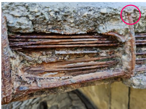
Obr. 78 Stav výstuže, detail - slabé krytie strmienkov
