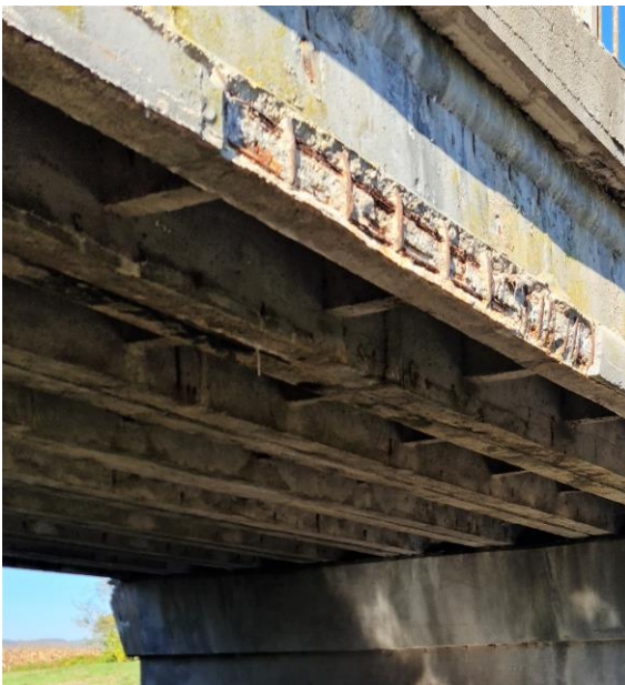
Obr. 26 Korózia výstuží - pole 1, pravá strana
