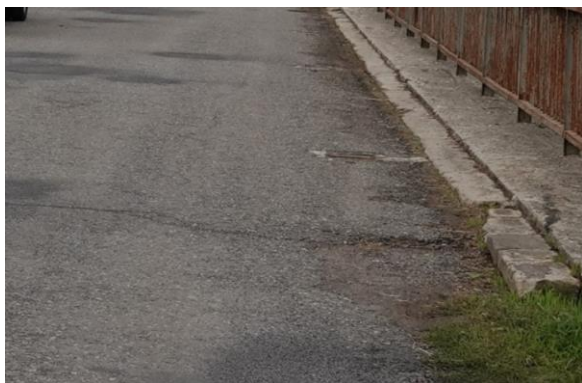
Obr. 37 Trhlina na vozovke v mieste dilatácie - opora 3
