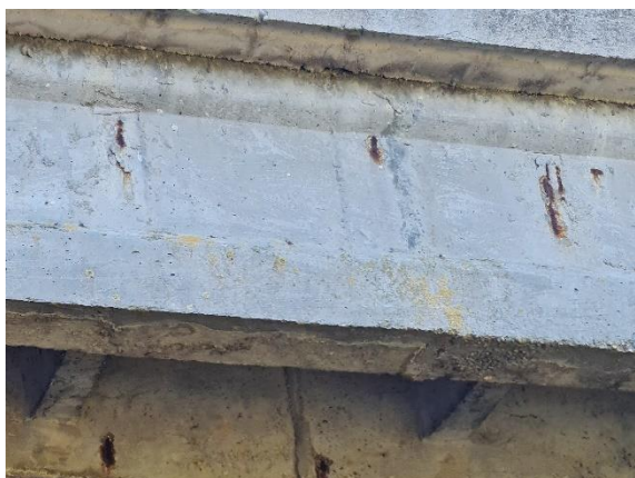
Obr. 64 Výstuž priečneho kĺbového spojenia
