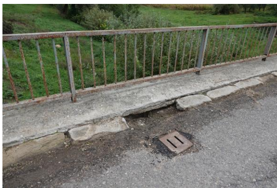
Obr. 42 Spätné uloženie mriežky odvodňovača
