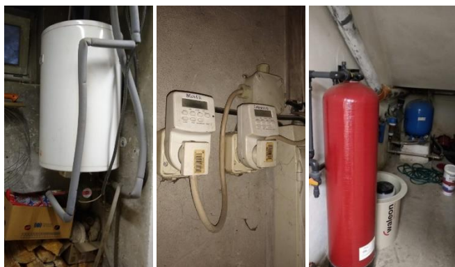
Obr. 9: Ohrev TV a úprava SV
