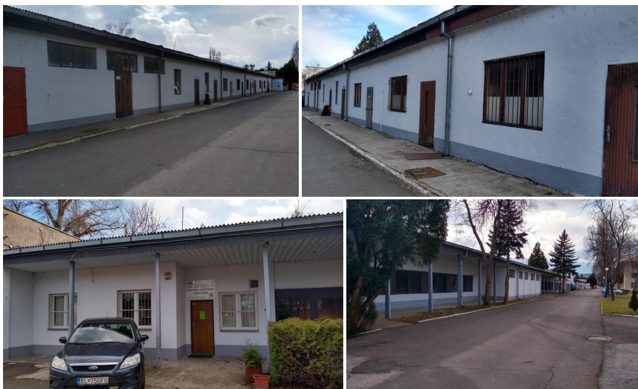
Obr. 6: Prevádzkový budova A a B
