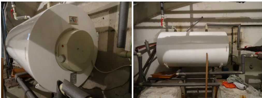
Obr. 9: Ohrev TV – zásobníkový ohrievač a rozdeľovač
