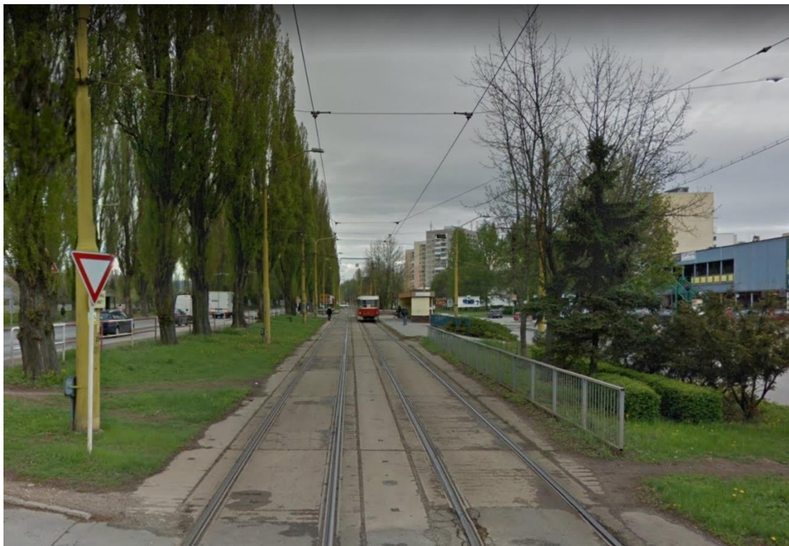
Obr. 4 Električková trať v úseku Slaneckej cesty
