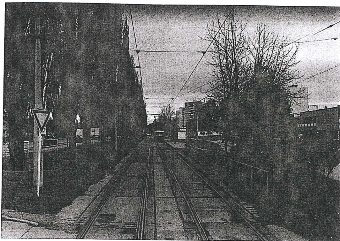
Obr. 4 Električková trať v úseku Slaneckej cesty
