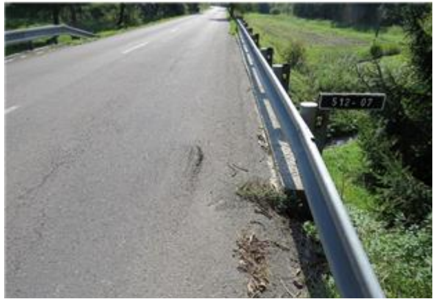
Názov: 512-007_pretlačenie_vozovky s trhlinami voz...JPG
