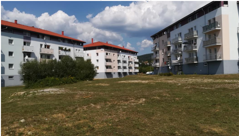
Vyschnutá a udupaná pôda pri bytovke č. 5, vyšliapaný chodník
