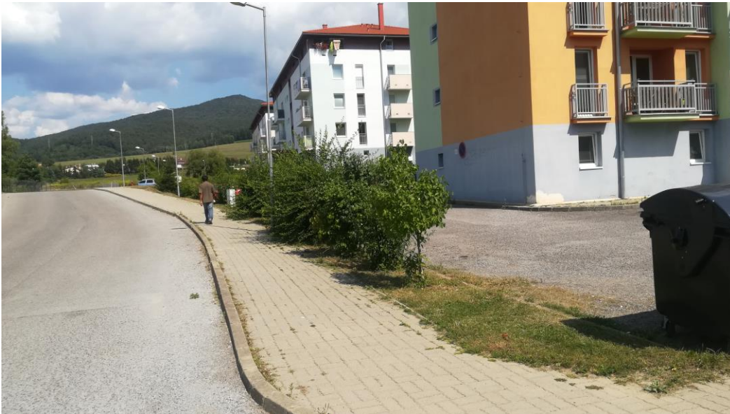
Pohľad zo severnej strany na plochy pred bytovkami č. 4 - 1
