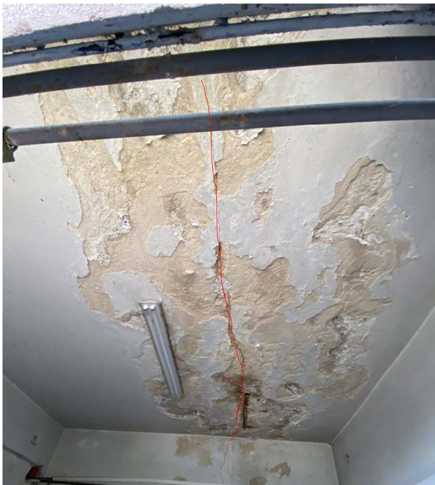
Obrázok 5 Trhlina v stropnej konštrukcii
