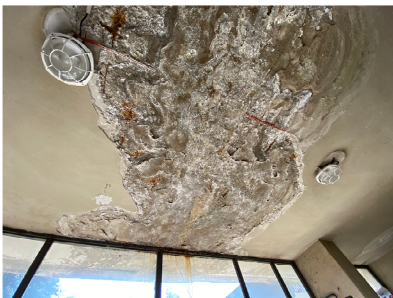
Obrázok 3 Zatekanie vody do stropnej konštrukcie
