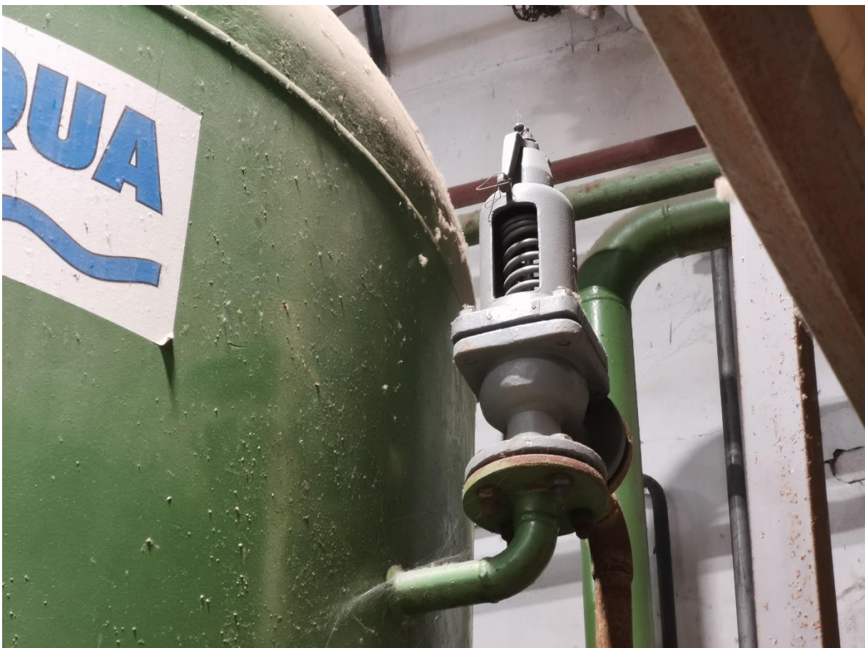
51. Poistné ventily vzdušníkov na CHÚV P15 217 616 DN50 PN16 – umiestnenie: 0m CHÚV
