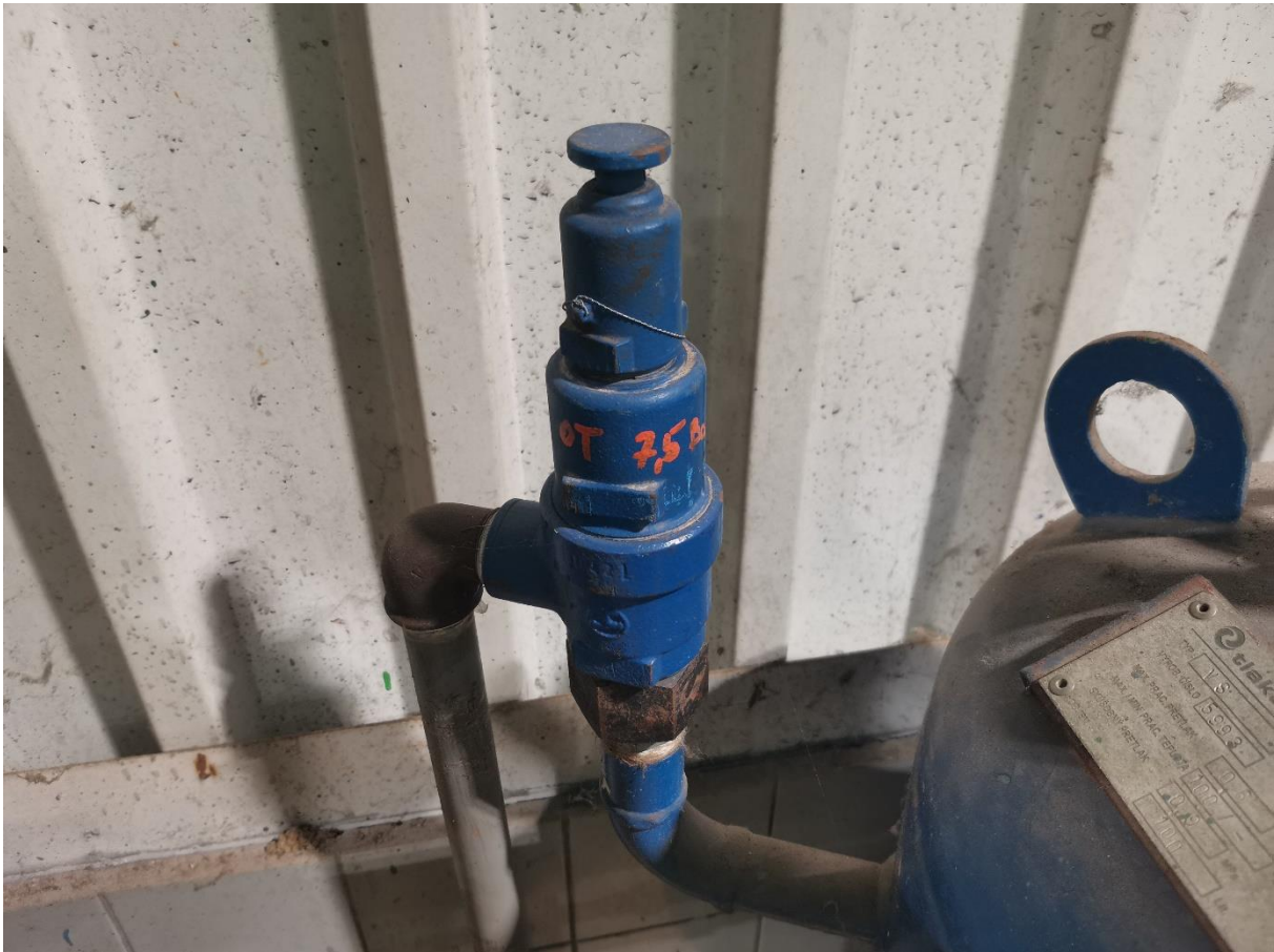
51. Poistné ventily vzdušníkov na CHÚV P15 217 616 DN50 PN16 – umiestnenie: 0m CHÚV
