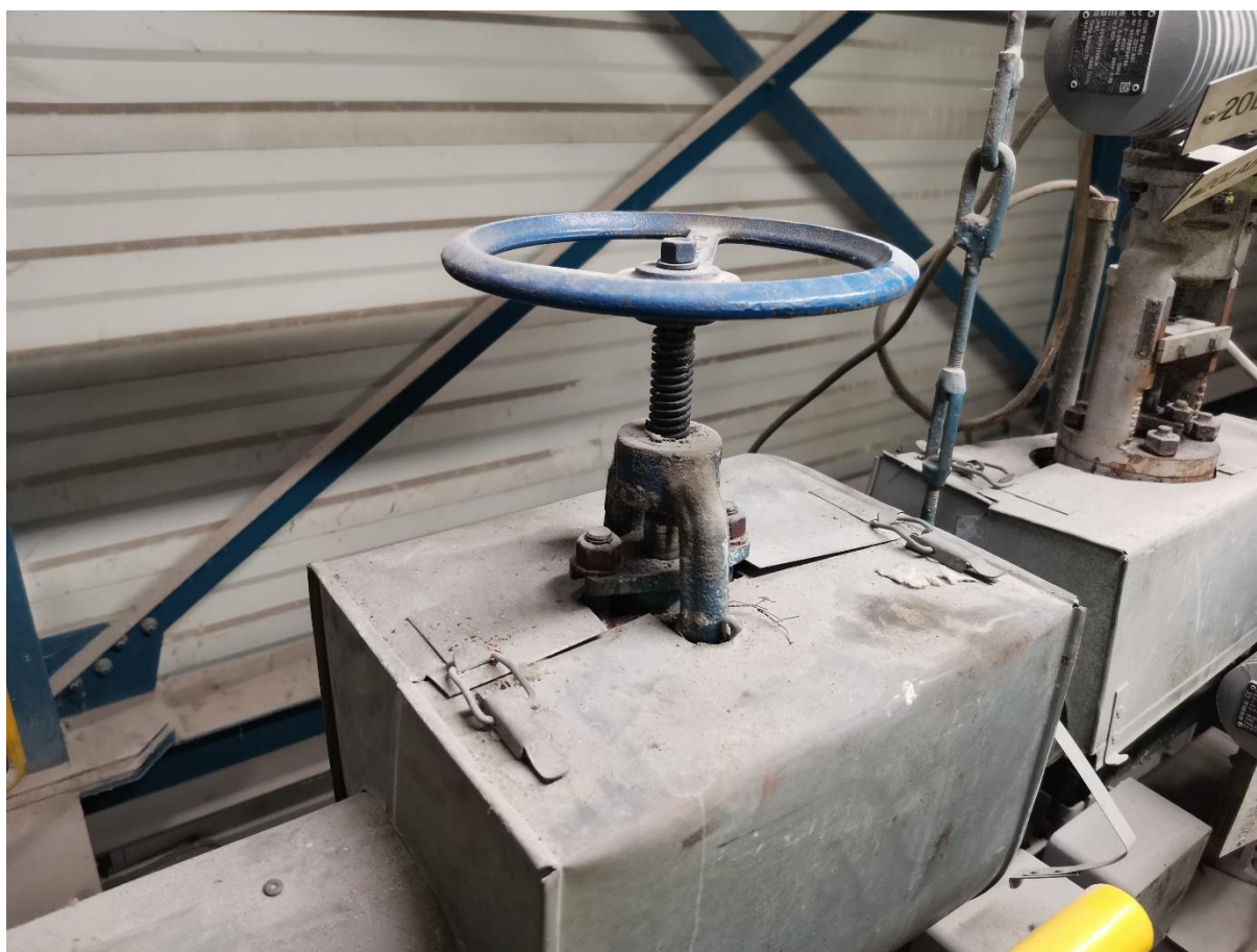
13. Uzatváracie armatúry na napájacej hlave V30 121 5100 DN50 PN100 – umiestnenie: 4. poschodie
