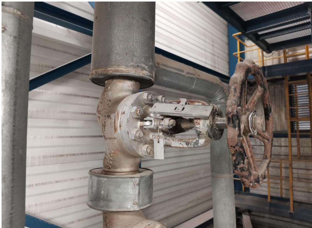
12. Uzatváracie armatúry na napájacej hlave 738 DN80 PN73 130°C – umiestnenie: 4. poschodie
