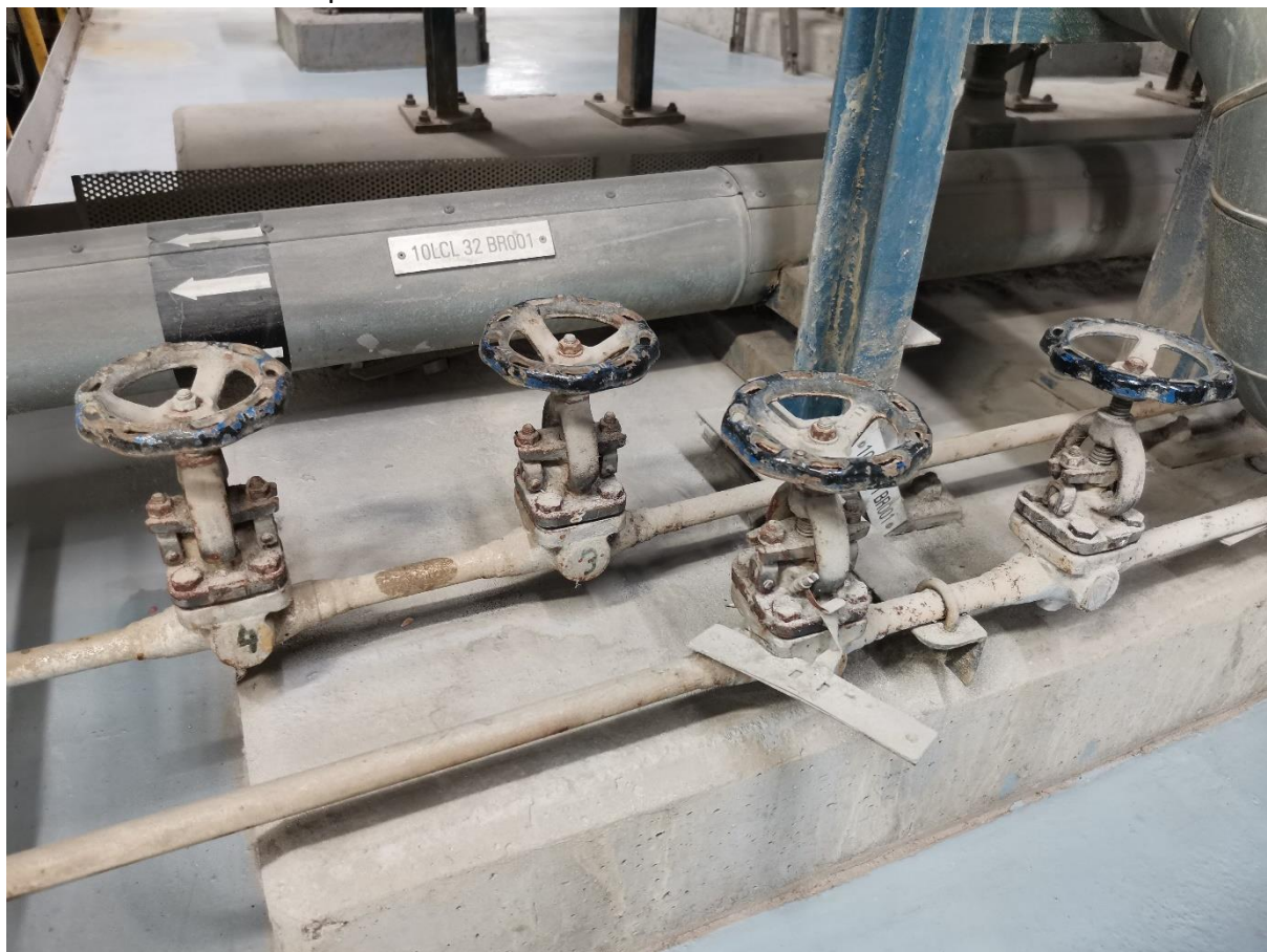
33. Uzatváracie armatúry na ohreve primárneho vzduchu V30 121 540 DN15 PN40 – umiestnenie: 1. poschodie
