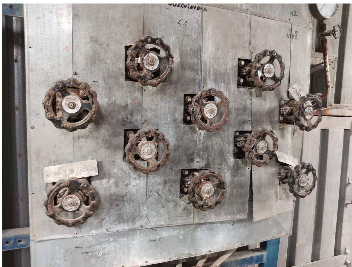
11. Odvzdušňovacie armatúry 200AE 21.2 DN15 PN100 – umiestnenie: 7. poschodie
