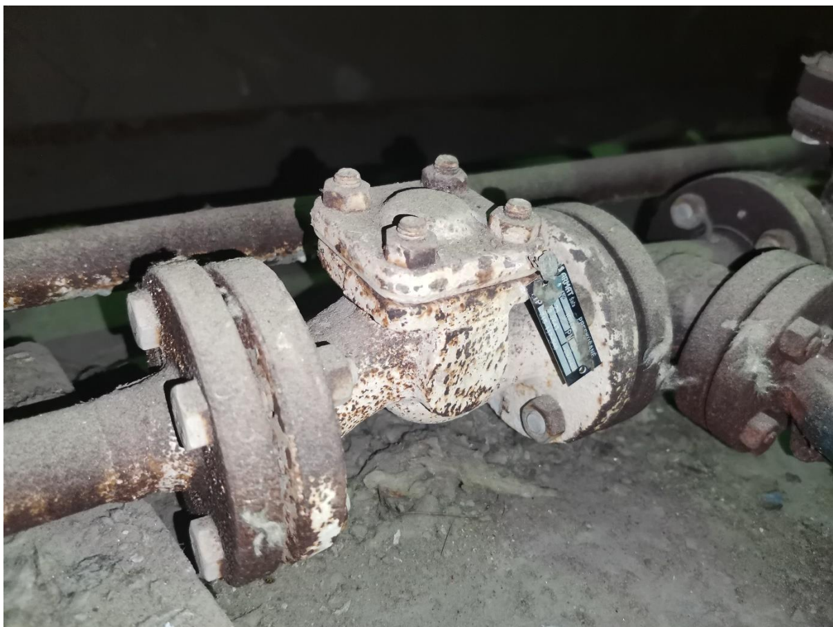
47. Odvádzač kondenzátu na 19bar rozdeľovači č.2 215 117 50 DN25 PN40 – umiestnenie: 1. poschodie K3
