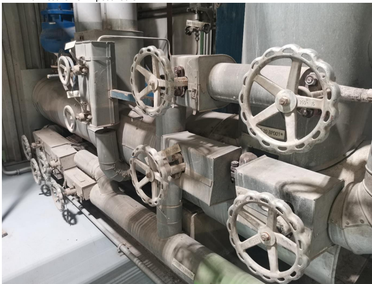
37. Uzatváracie armatúry na 19bar rozdeľovači pary č.1 V46 121 3100 DN25 PN100 – umiestnenie: 1. poschodie
