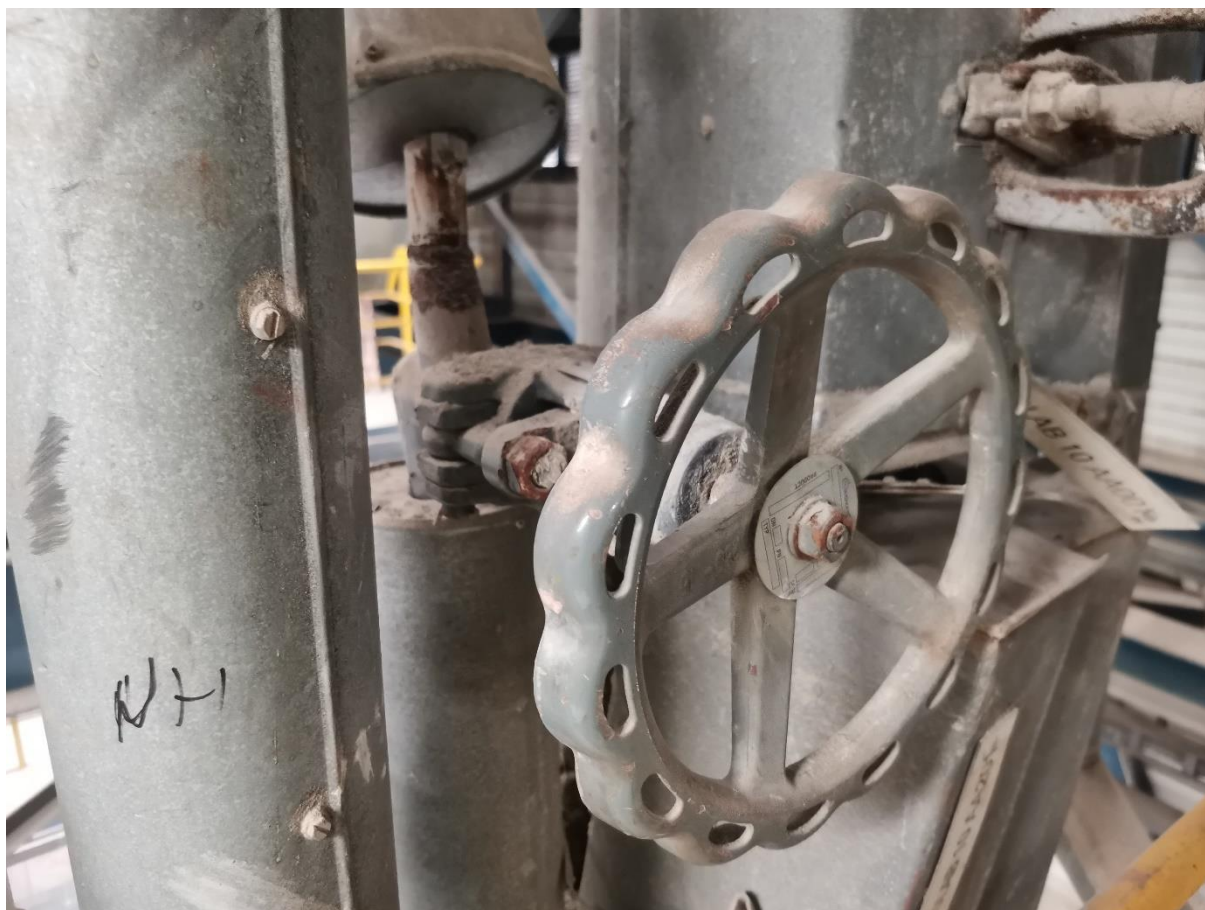
15. Uzatváracia armatúra na napájacej hlave V46 121 4100 DN25 PN100 – umiestnenie: 4. poschodie
