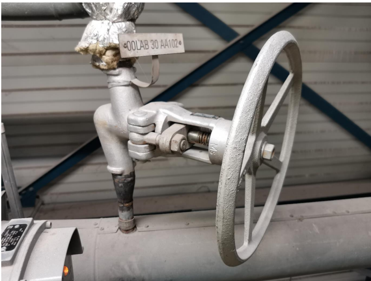
15. Uzatváracia armatúra na napájacej hlave V46 121 4100 DN25 PN100 – umiestnenie: 4. poschodie
