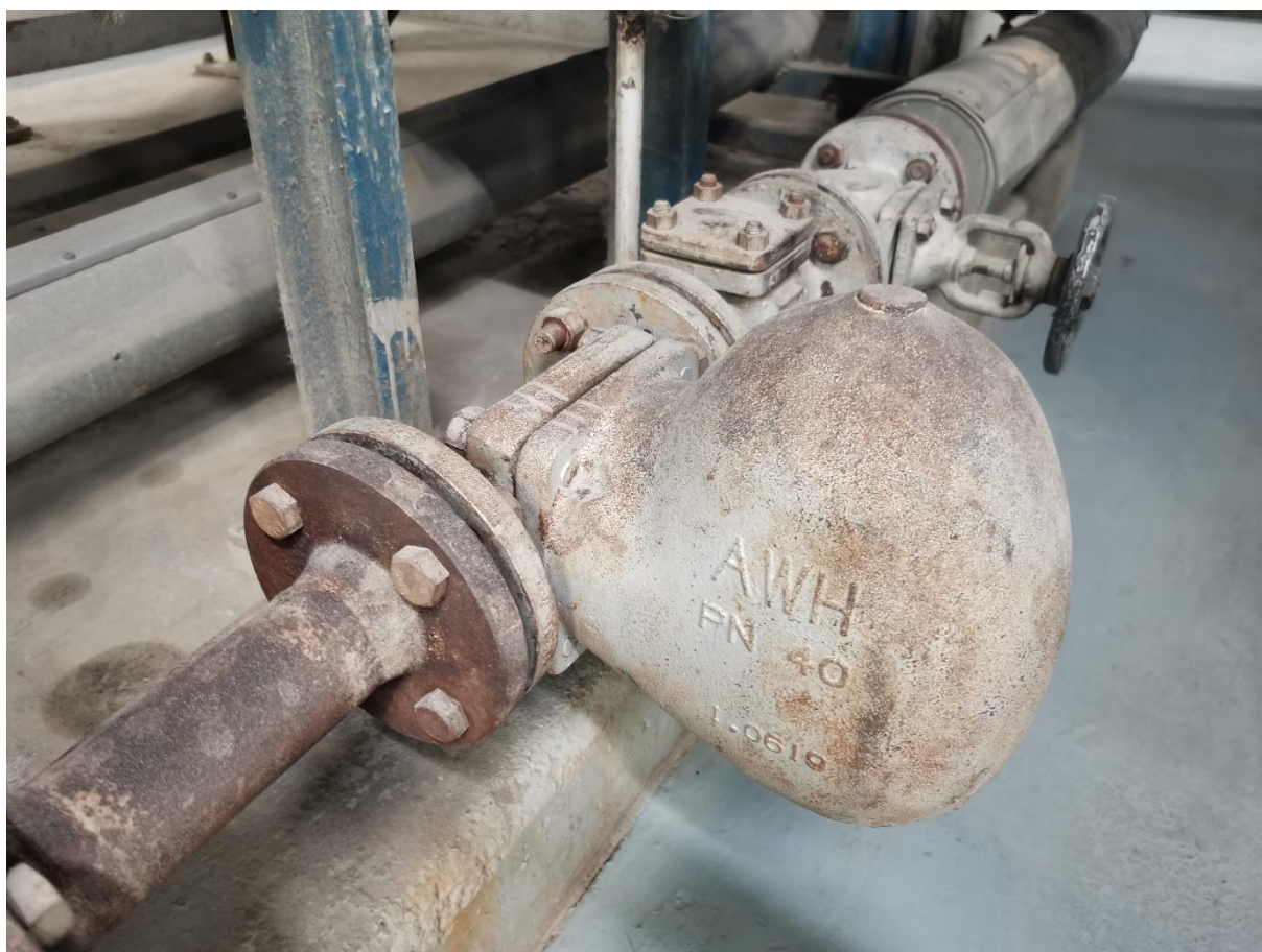
35. Odvádzače kondenzátu na ohreve primárneho vzduchu CNU 117 540 DN50 PN40 – umiestnenie: 1. poschodie
