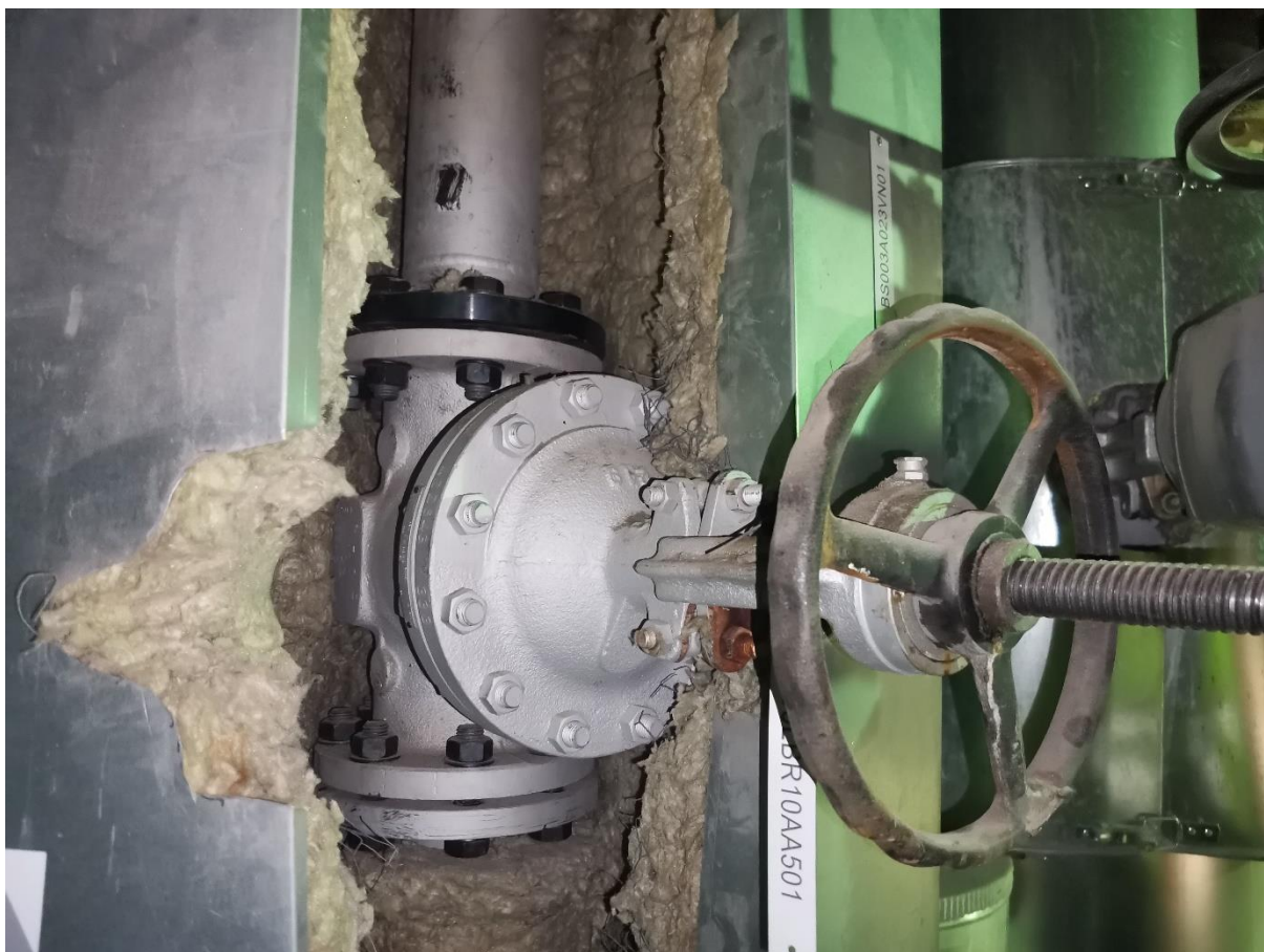
45. Uzatváracia armatúra na 19bar rozdeľovači č.2 S38 111 540 DN100 PN40 – umiestnenie: 1. poschodie K3
