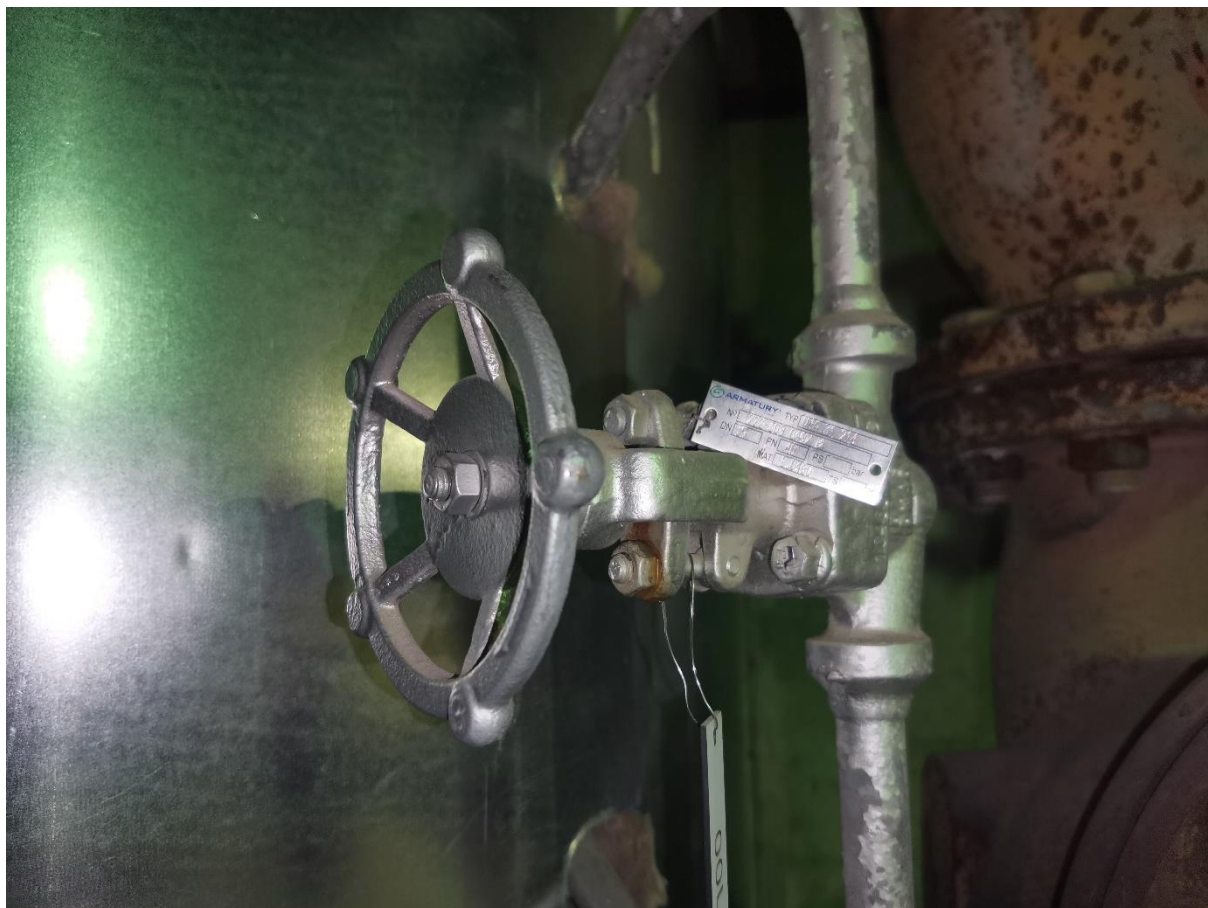
43. Uzatváracia armatúra na 19bar rozdeľovači č.2 422643 DN250 PN40 – umiestnenie: 1. poschodie K3
