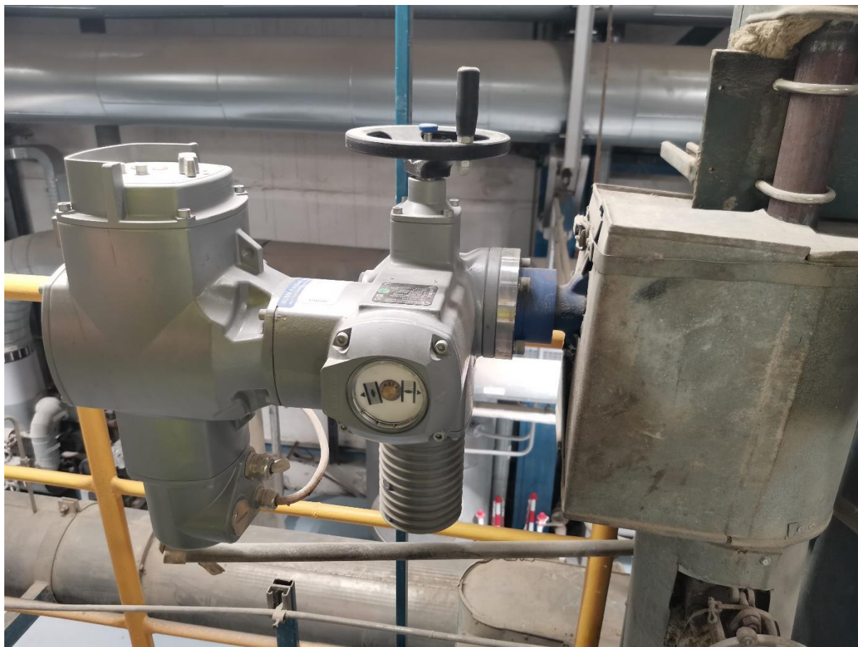
29. Uzatváracie armatúry na výpuste bubna 810-SWA105N DN40 136bar – umiestnenie: 2. poschodie
