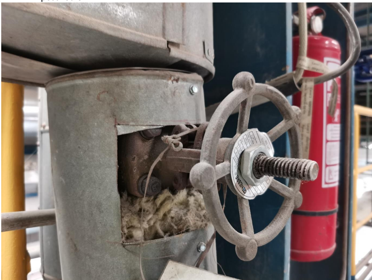
29. Uzatváracie armatúry na výpuste bubna 810-SWA105N DN40 136bar – umiestnenie: 2. poschodie
