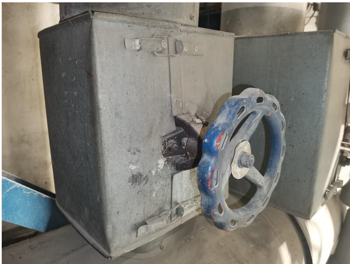
39. Uzatváracia armatúra na 19bar rozdeľovači pary č.1 do napájacej nádrže DN80 PN40 – umiestnenie: 1. poschodie
