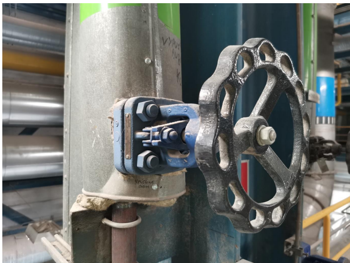
27. Uzatváracie armatúry na výpuste bubna DN40 PN10 – umiestnenie: 2. poschodie
