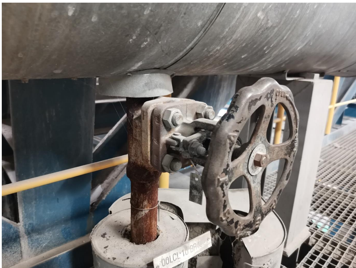
31. Odkalovacie armatúry hlavné 200AE 21.2 DN50 PN100 – umiestnenie: 1. poschodie
