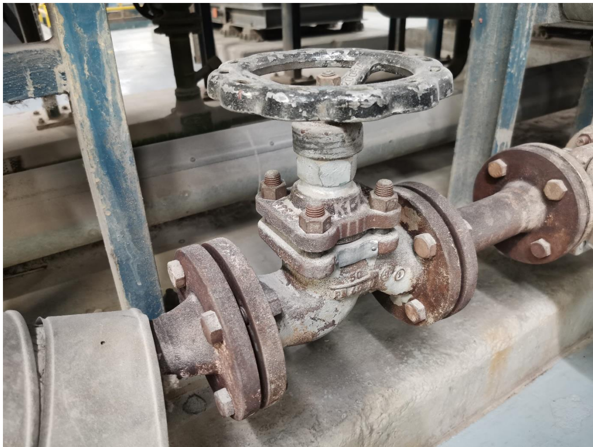
33. Uzatváracie armatúry na ohreve primárneho vzduchu V30 121 540 DN15 PN40 – umiestnenie: 1. poschodie
