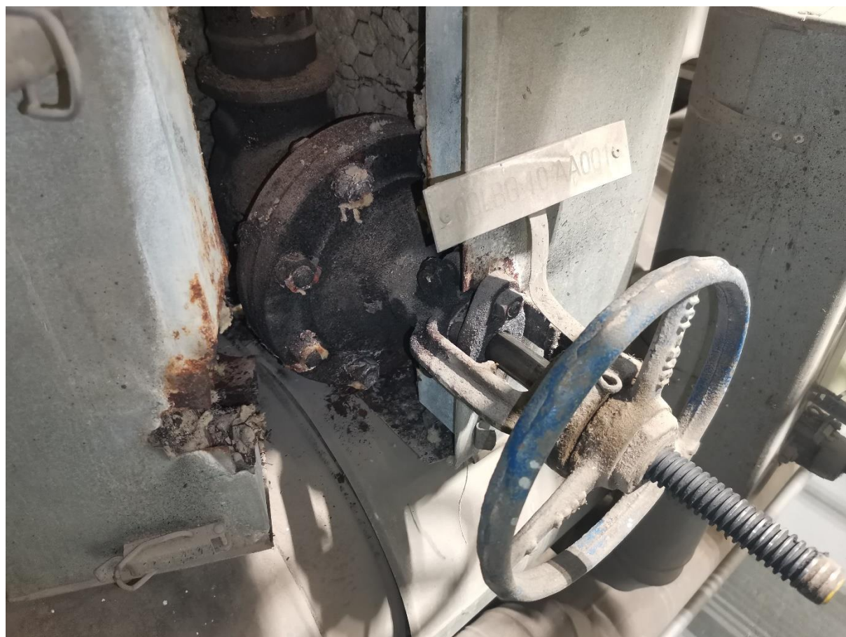
39. Uzatváracia armatúra na 19bar rozdeľovači pary č.1 do napájacej nádrže DN80 PN40 – umiestnenie: 1. poschodie
