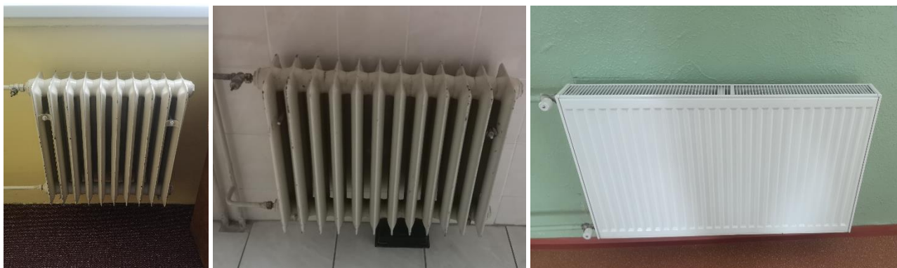
Obr. 13: Vykurovacie telesá v objekte „B“
