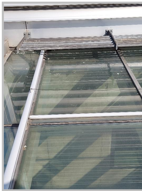
Obrázek č. 8 a 9 : Poškozená skla 2ks u levého okraje světlíku při pohledu ze střechy. Úzké / větší.
