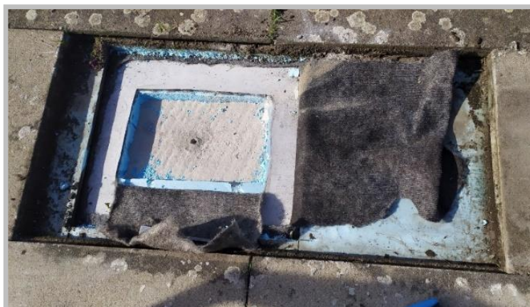
Obrázek č. 2: Sonda do konstrukce střešního pláště
