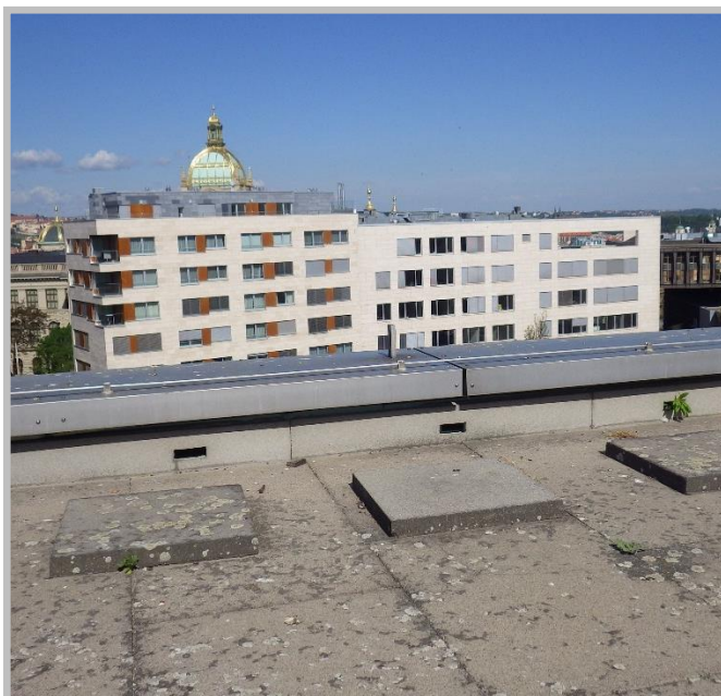
Obrázek č. 4 a 5: Oplechování atiky s kotevním prvkem pro horolezce / pojistné přepady
