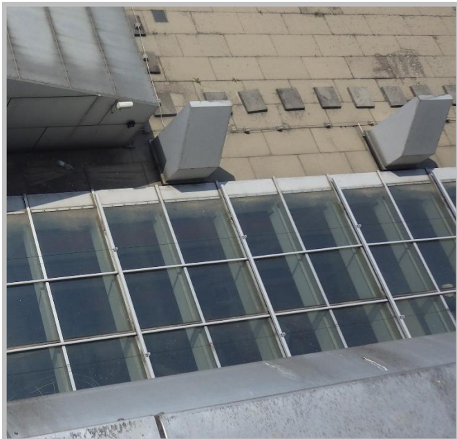
Obrázek č. 8 a 9 : Poškozená skla 2ks u levého okraje světlíku při pohledu ze střechy. Úzké / větší.
