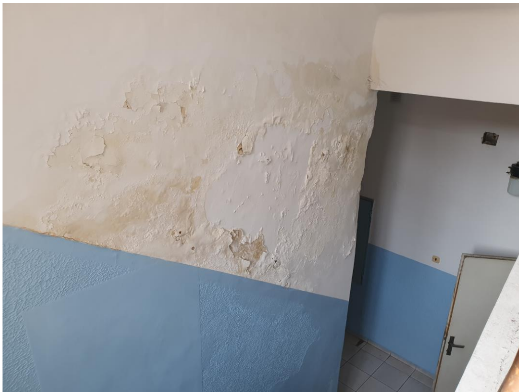
Foto 2 : Zatečená schodisková stena popri severnom schodisku pod stropom prízemia (zatekanie zo sociálnych zariadení na 2.NP).
