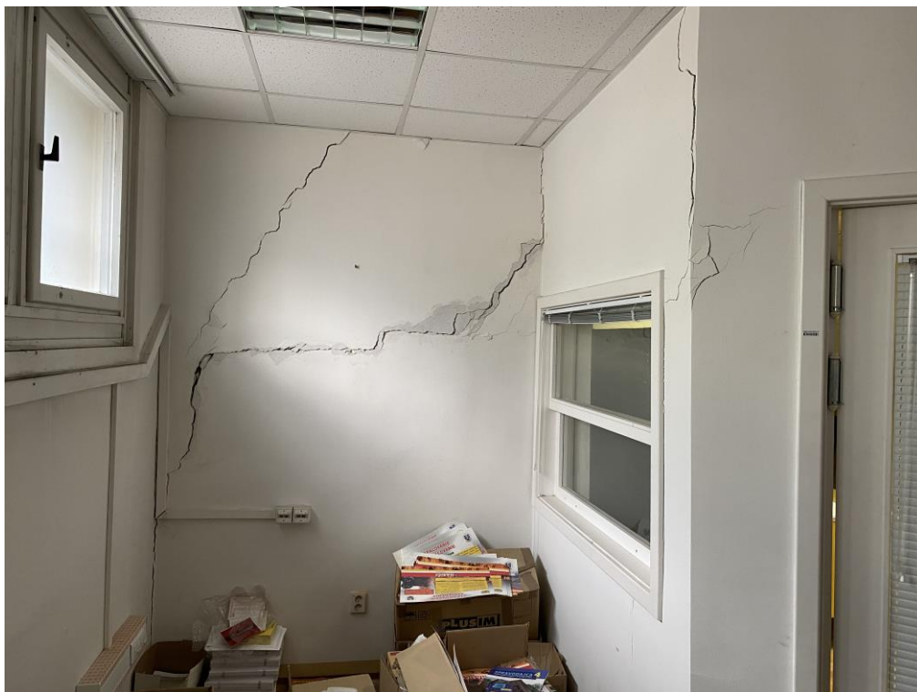
Foto 4 : Potrhané deliace priečky na prízemí v priestore medzi severným schodiskom a zaslepenými pôvodnými bránami na uličnej fasáde (sú na obrázku za oknom vľavo).
