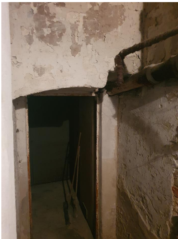
Foto 11 : Oslabený kľenbový pás v suteréne kvôli nevhodne vedenej kanalizácii.
