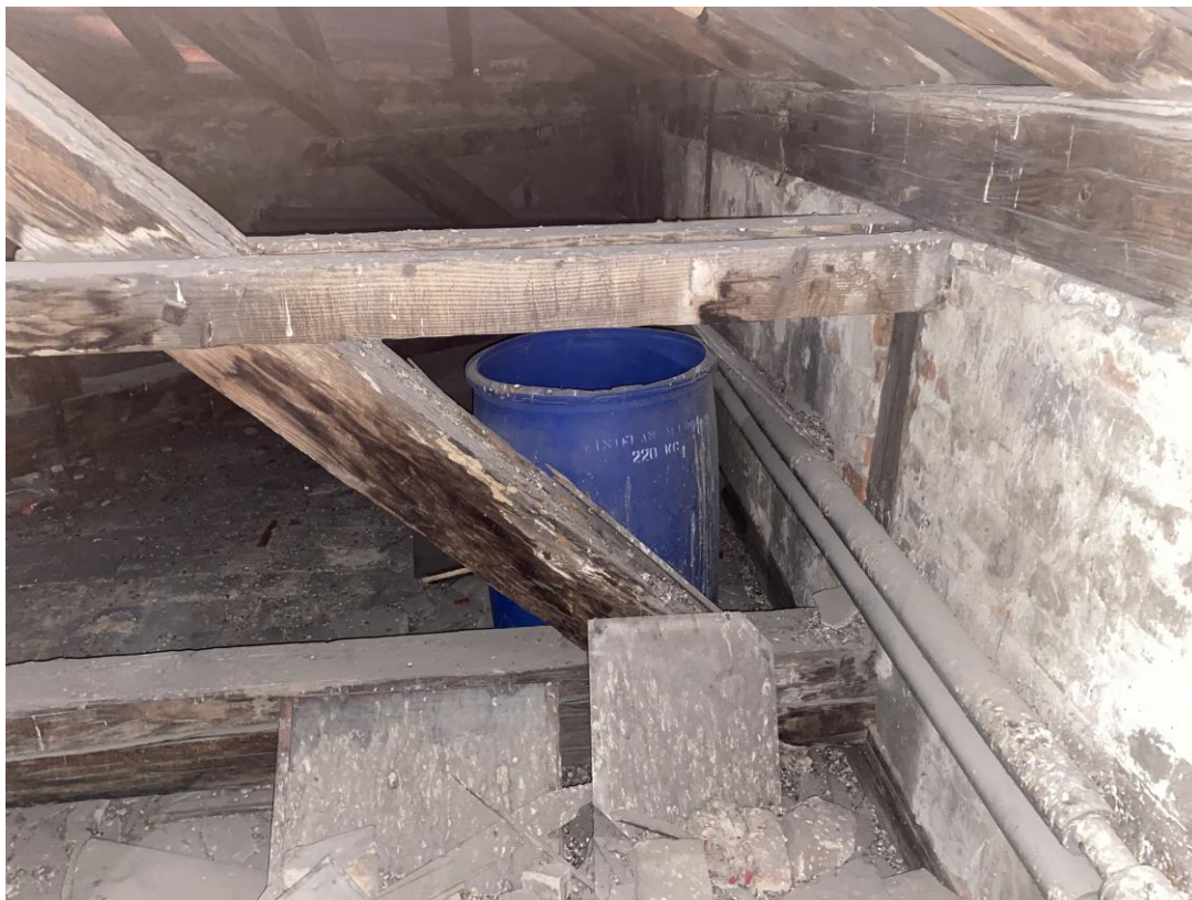
Foto 5 : Značne prehnutá vzpera v styku s väzným trámom v strednej časti objektu.
