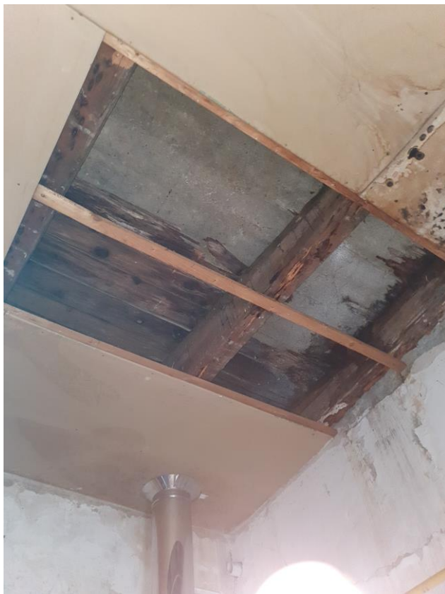
Foto 9 : Zatečený strop nad kotolňou s nahnutými drevenými trámami.
