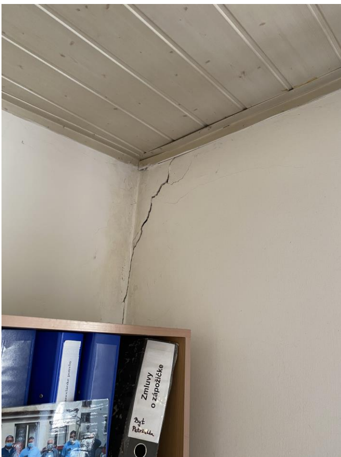
Foto 8 : Trhlina v dvorovej stene prízemia naľavo tesne pri veži.
