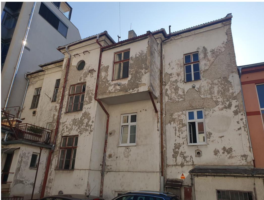
Foto 13 : Dvorová fasáda objektu D je značne zatečená, korunná rímsa je lokálne poškodená. Arkier vedľa schodiska je podopretý štíhlou oceľovou vzperou.
