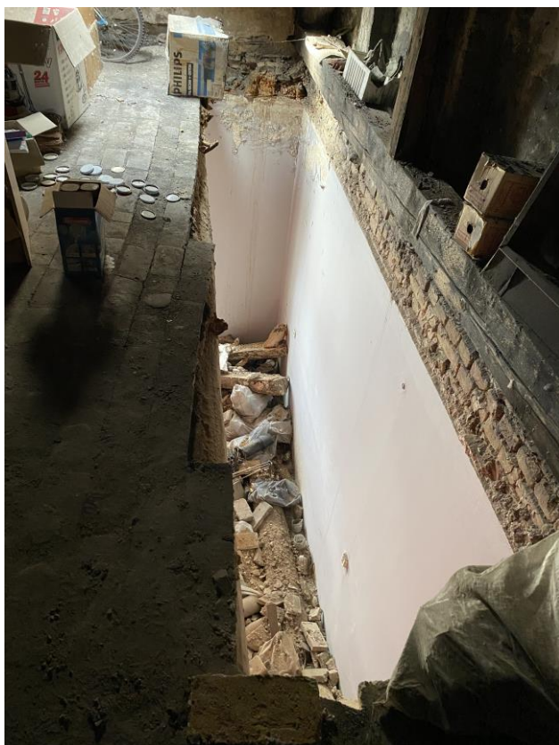
Foto 15 : Havarovaný povalový strop nad 3.NP, vidno zvyšky ušmyknutých trávov.
