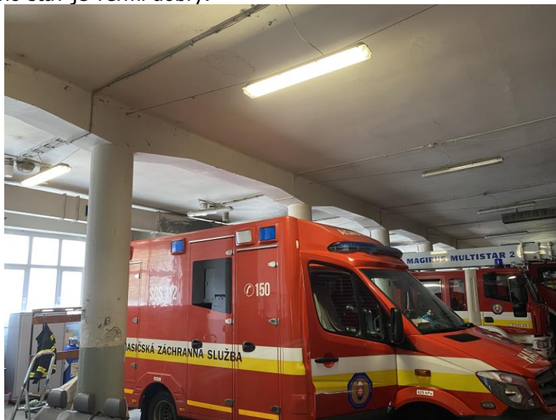
Foto 19 : Konštrukcie v garáži. V podhláde stropu sú pozdĺžne trhliny, strop vykazuje viditeľný priehyb. Podlaha je vysoko nad uličným chodníkom.
