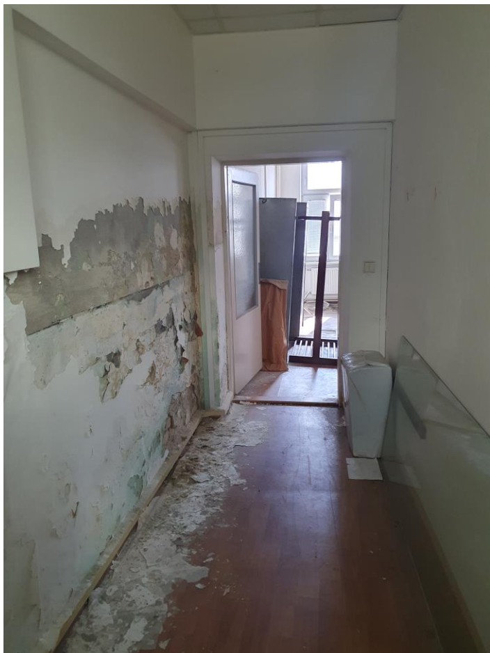
Foto 3 : Vzlínaním, príp. zatekaním poškodená obvodová stena prízemia popri objekte B.
