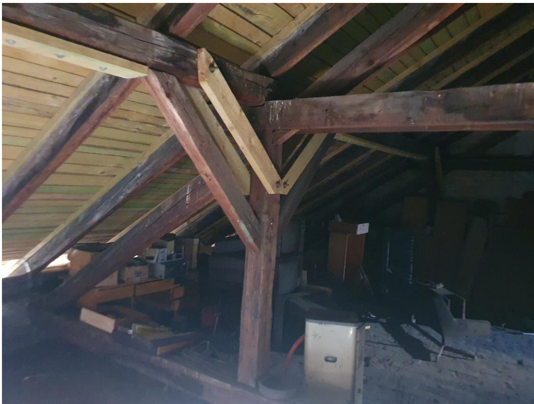
Foto 18 : Nevhodné a prakticky neúčinné zosilnenie pôvodného krovu.
