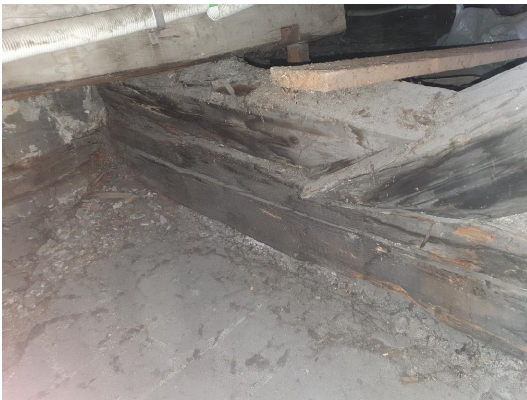
Foto 17 : Zlomený a prehnitý väzný trám s dolnou pomúrniciou, vybočená a poklesnutá vzpera v plnej väzbe pri schodisku.
