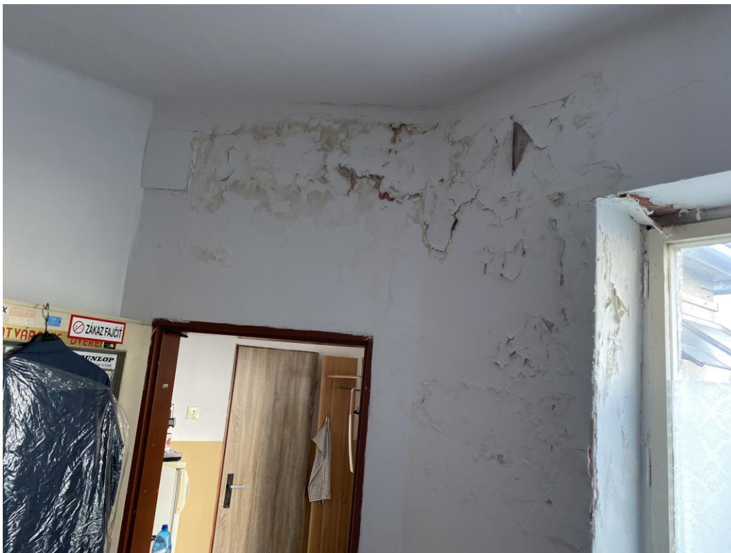
Foto 7 : Zatečená stena v kancelárii napravo od veže okolo vstupu z predsiene.
