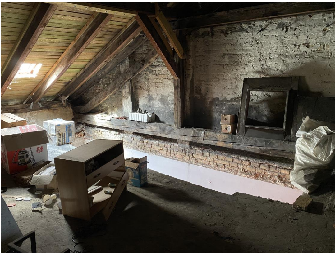
Foto 16 : Roh nad havarovaným stropom so zatečenými a prehnitými prvkami krovu.
