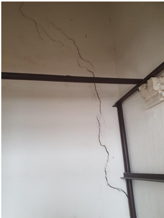
Foto 14 : Trhliny v priečkach na 3.NP oproti schodisku. Sú zrejme vymurované na málo tuhom drevenom strope.
