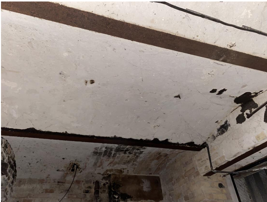
Foto 12 : Oceľové nosníky klenbičkových stropov v suteréne sú značne skorodované.
