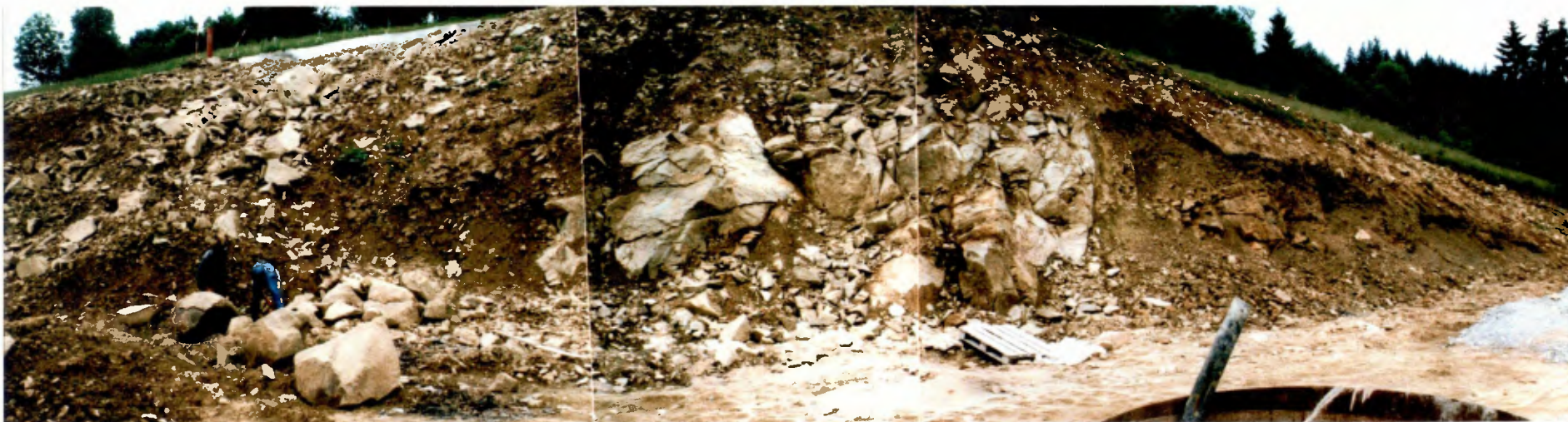
obr. č.11 Tektonické porušenie zlínskych vrstiev v spodnom záreze. Veľký blok masívnych, tektonicky porušených pieskovcov je v ľavej strane oddelený tektonickou poruchou vyplnenou porušenými pieskovecami charakteru ílovitokamenitej sutiny. V pravej strane je veľmi zreteľná tektonická porucha, oddelujúca blok pieskovca od porušených ílovcov.
