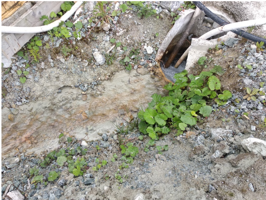
Obrázok č. 8: TU-OM1 – Výtok z odvodňovacej štôlne na VP
