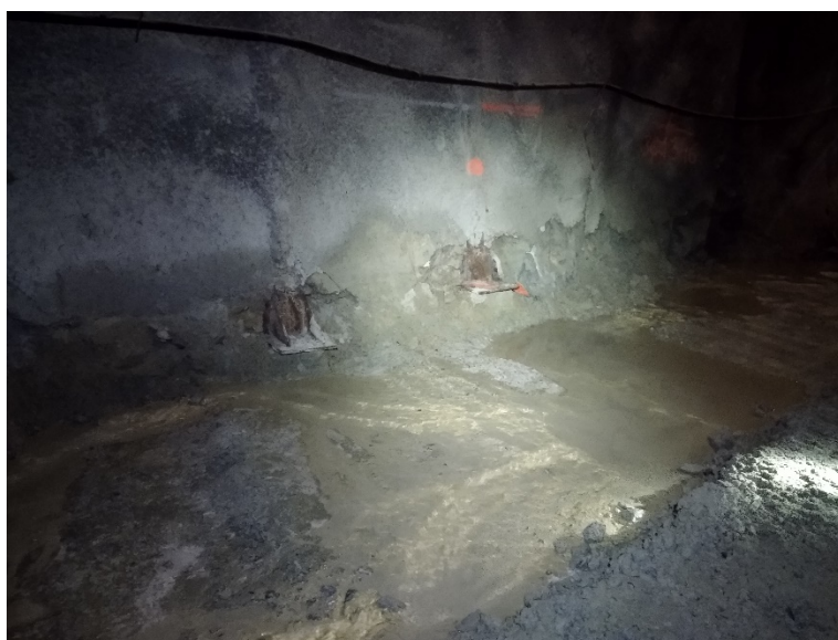
Obr.6 S382-385 - podkované nosníky na pravej strane
