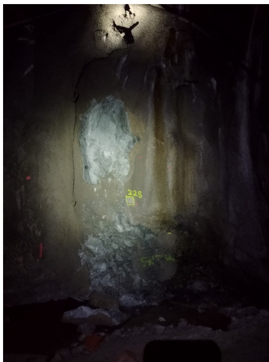
Obr.10 S 334 – Prítok vody, porušený výklenok
