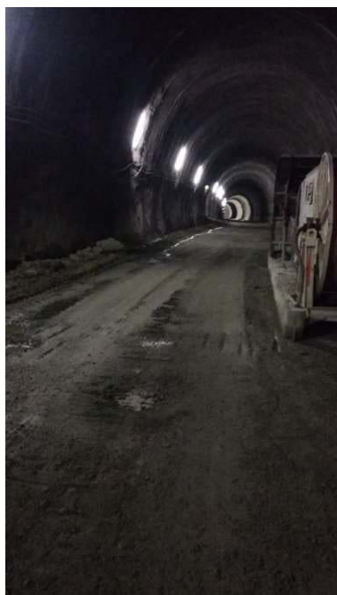
Obr.7 Úvod STR – východný portál - rozmočená počva (voda tečie rigolom)
