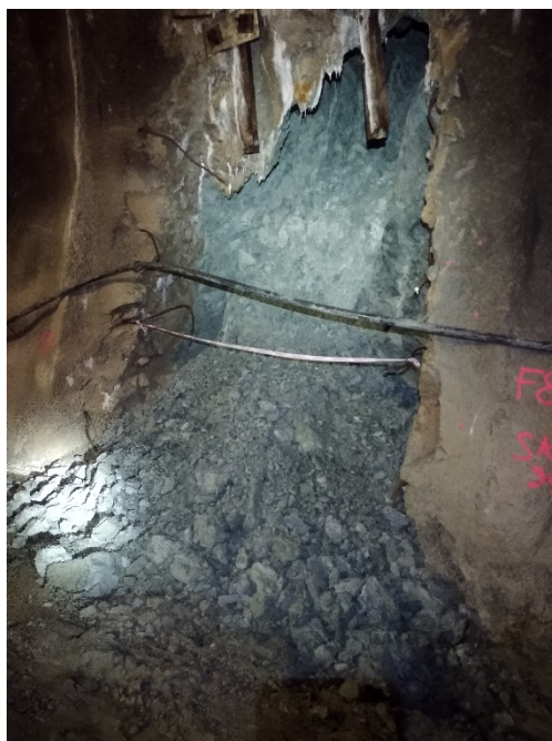
Obr.1 J595 – nepriaznivá geológia vo výklenku
