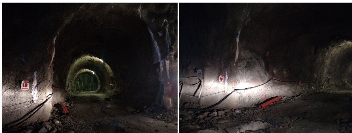
Obr.2 PP18 z JTR – vypadnutý striekaný betón
