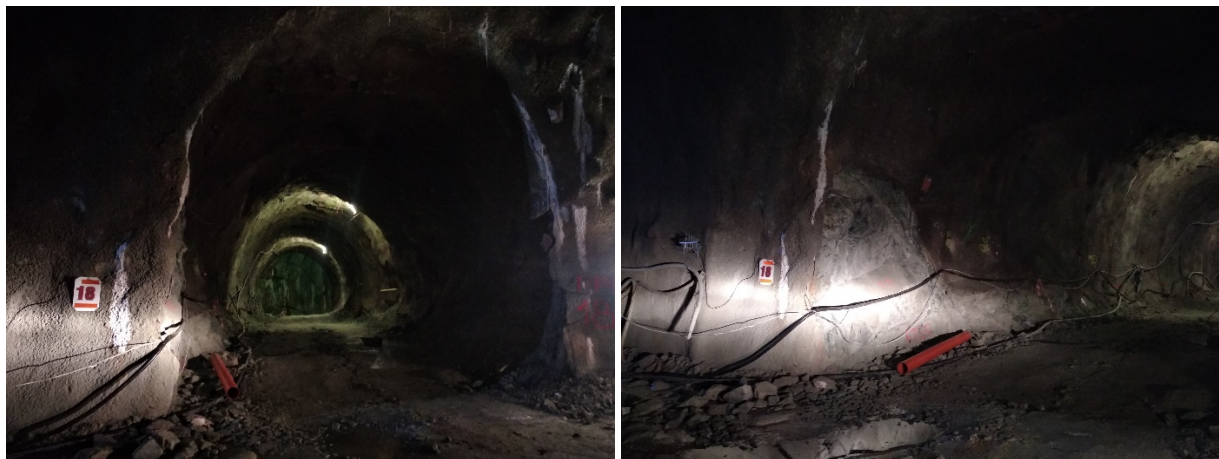
Obr.2 PP18 z JTR – vypadnutý striekaný betón
