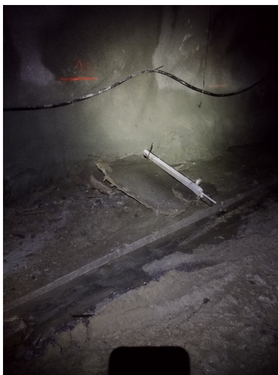
Obr.4 S367 – vypadnutý betón zo stropu
