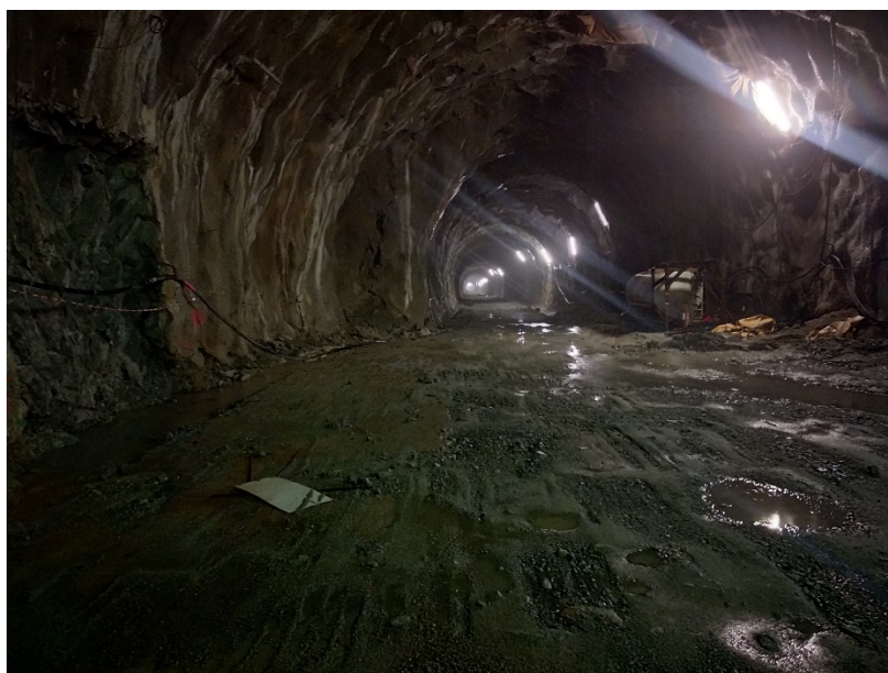
Obr.8 NZ 6 STR – nezastriekaný výklenok trhliny v primárnom ostení
