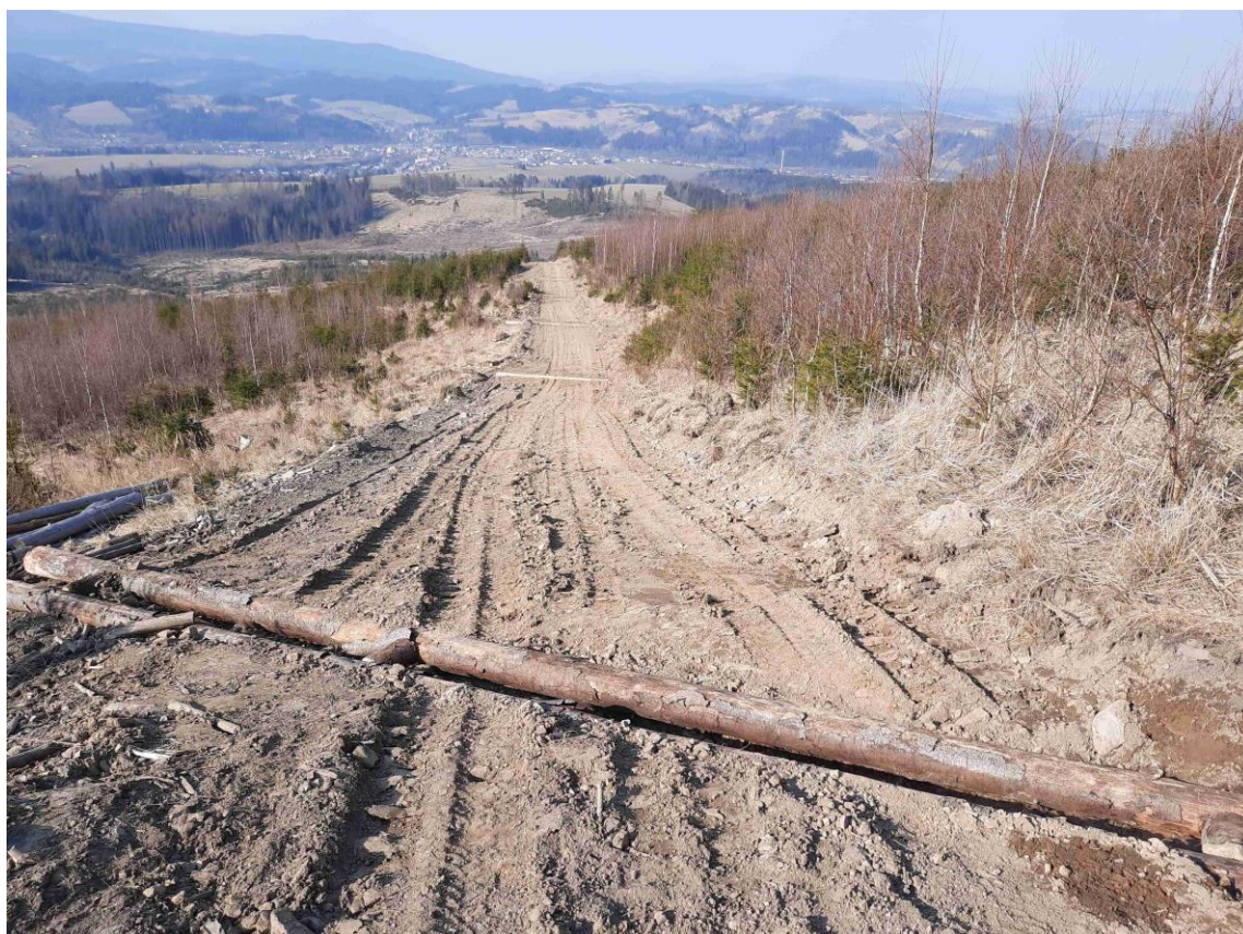
Obr. 2 Ukážka realizovaných drevených odrážok na zväžnici.
