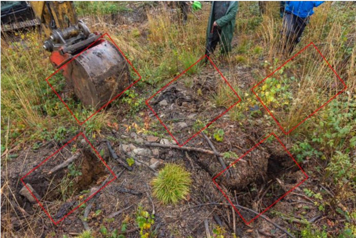
Obr.10. Ukážka vsakovacích vrypov, ktoré rozruší zhutnenú pôdu a umožní rýchlejšie vsakovanie vody do hlbších horizontov pôdy, tzv. vzor šachovnice.
