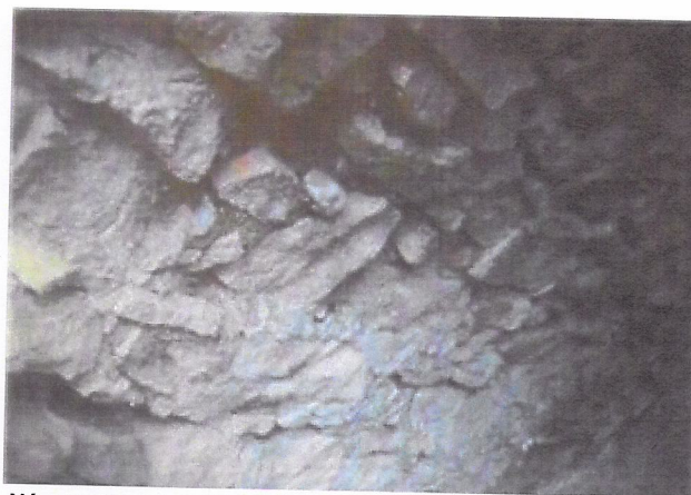
Názov: 2807-2, 57141-2 Nevyplnená kontaktná lepená škára v klenbe.jpg
