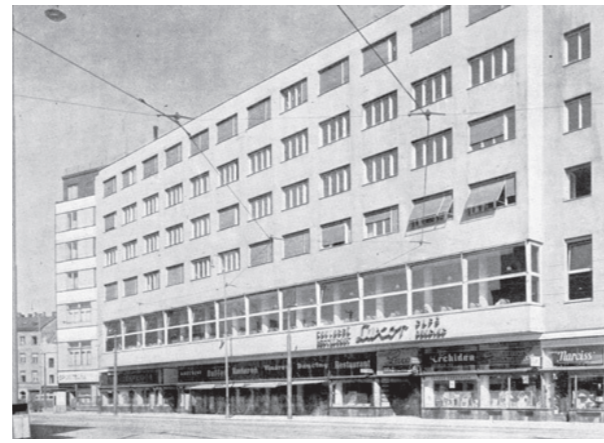
Bytový dom a kaviareň Luxor (J. Víšek, 1939) zdroj: Ústav stavebníctva a architektúry SAV Luxor café and apartment block (J. Víšek, 1939) source: Institute of Construction and Architecture of SAS
