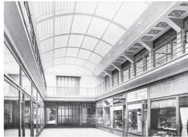
Centrálna pasáž (Andreas Szönyi, Franz Wimmer, 1929) zdroj: Ústav stavebníctva a architektúry SAV Central Passage (Andreas Szönyi, Franz Wimmer, 1929) source: Institute of Construction and Architecture of SAS
