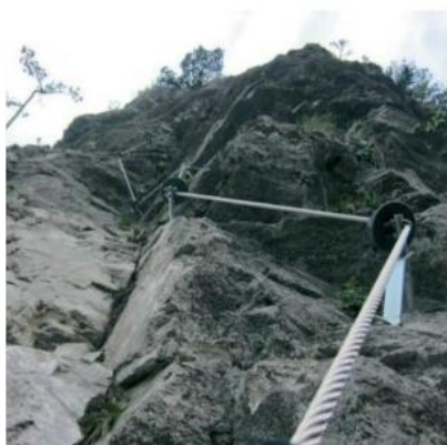
Vedenia oceľového lana kotveného v skale a detaily kotviacich prvkov a uchytenia
