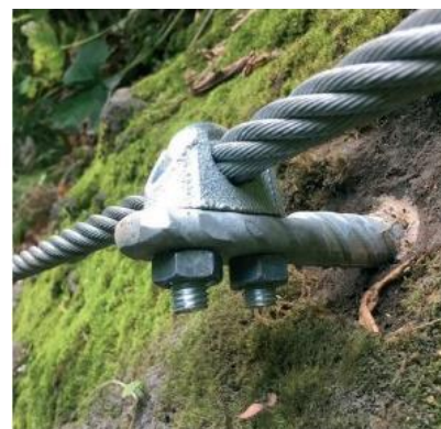
Vedenia oceľového lana kotveného v skale a detaily kotviacich prvkov a uchytenia
