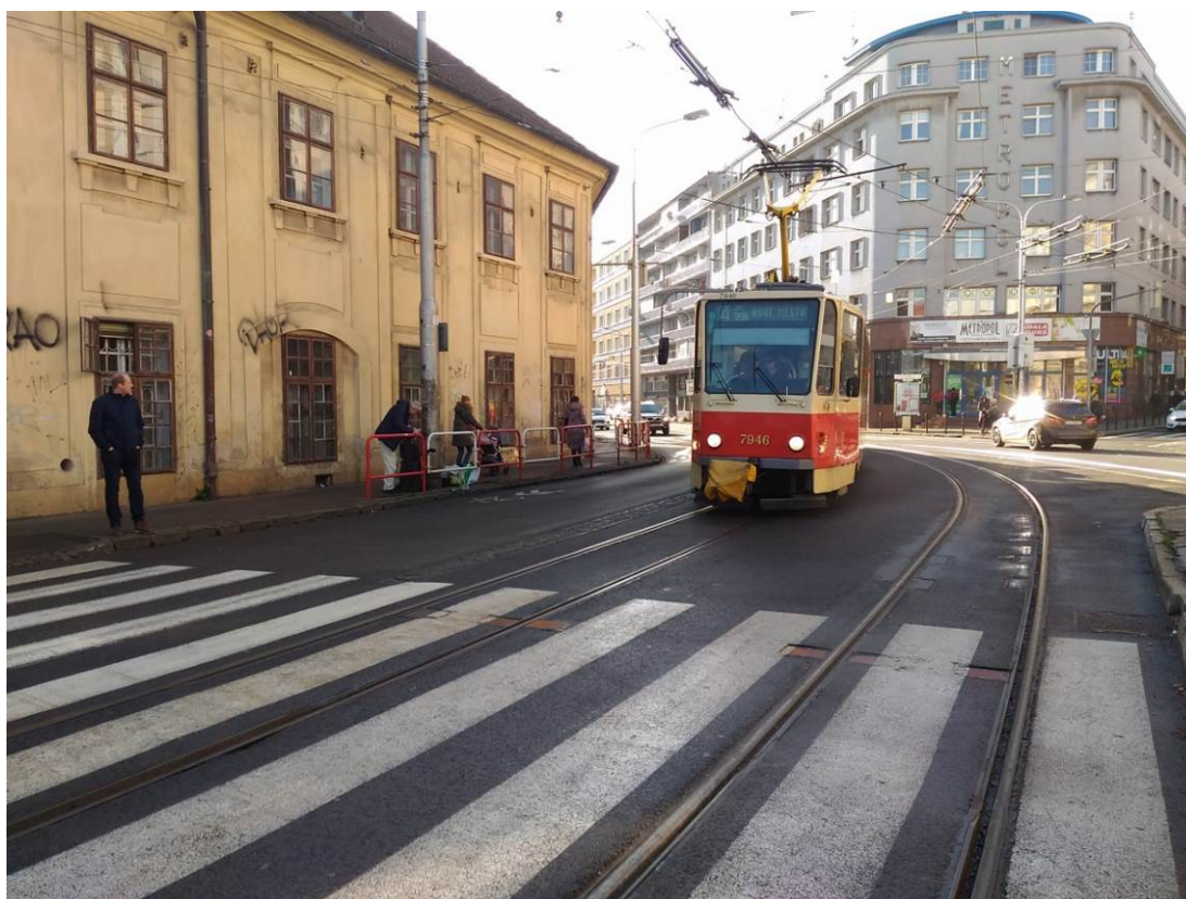
Obr. NI 2 Americké námestie v Bratislave pri meraní hluku a vibrácii na zrekonštruovanej električkovej trati.
