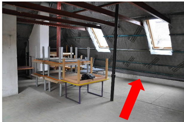
Zdjęcia archiwalne przed przebudową poddasza, pom. nr 2.13 ze wskazaniem wieńców do ocieplenia
