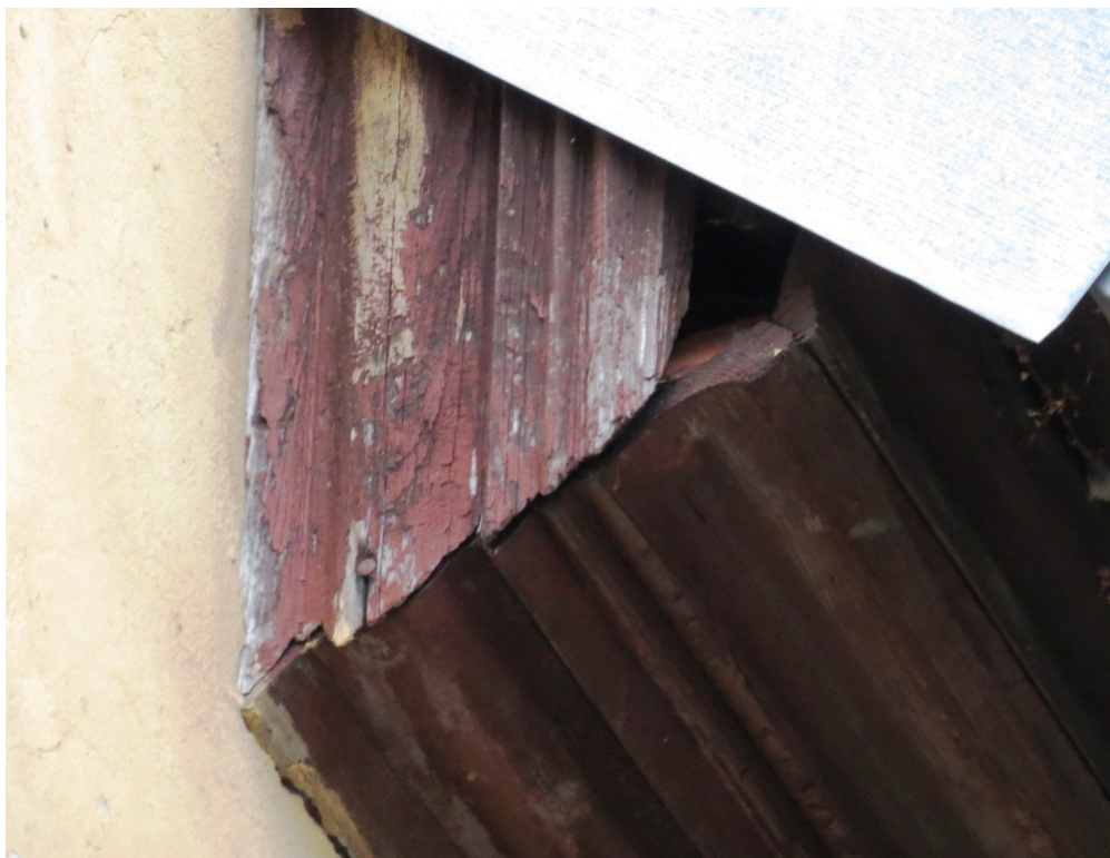
Fot.2. Ubytek w zbliżeniu (aut. Szymon Wójcik).
