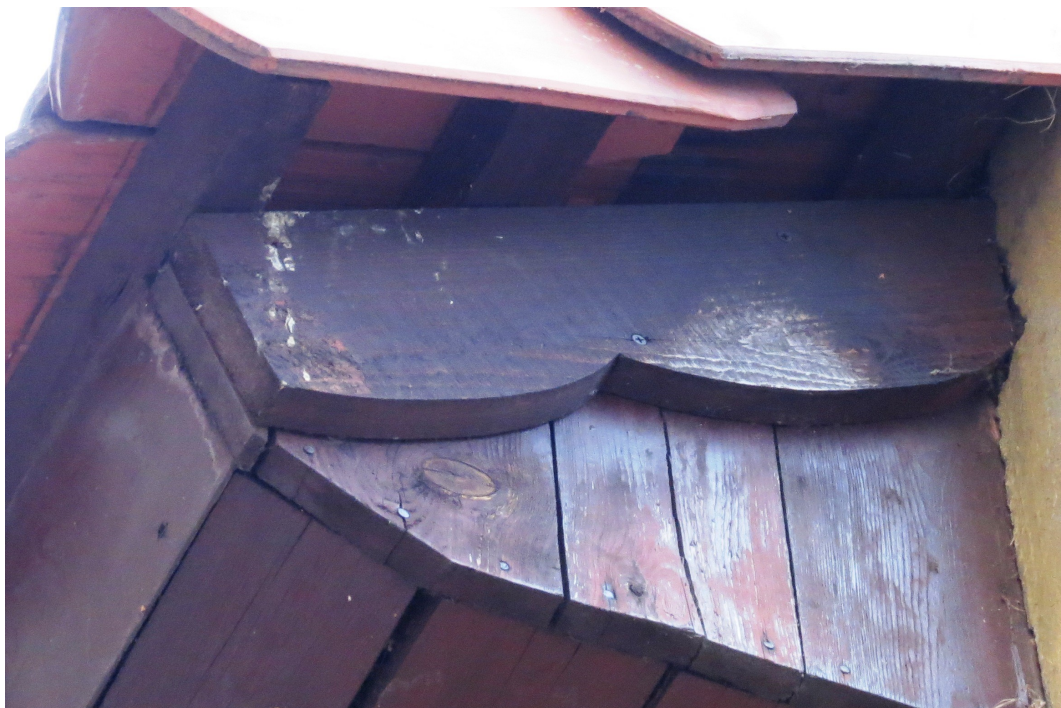
Fot.5. Ubytek w zbliżeniu; widoczne są odchody ptaków (aut. Szymon Wójcik).
