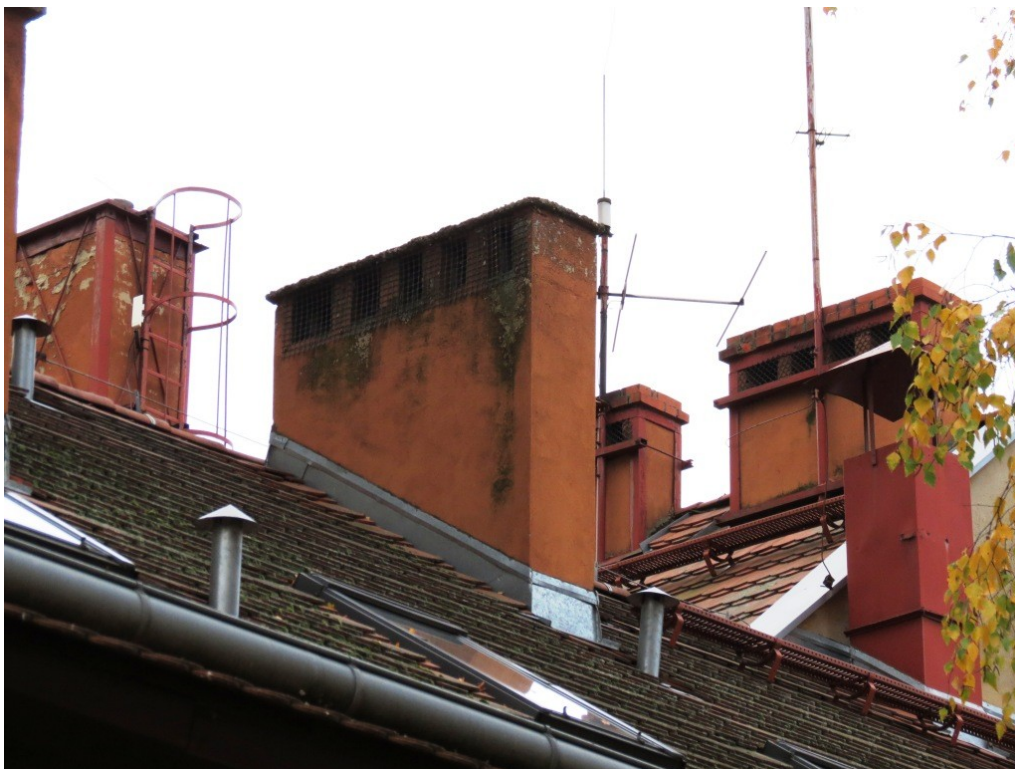
Fot.9. Kominy uszczelnione są kratkami (aut. Szymon Wójcik).
