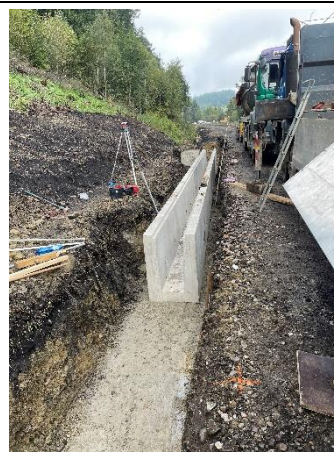
Montáž priekopových múrikov na podkladný betón
