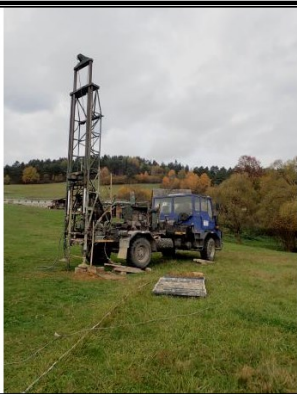
Vrtanie hydrogeologického vrtu HG-10-03
