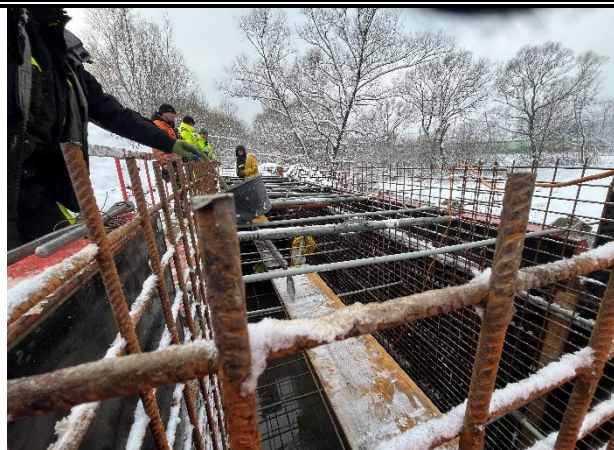
Viazanie armatúry drieku OP1
