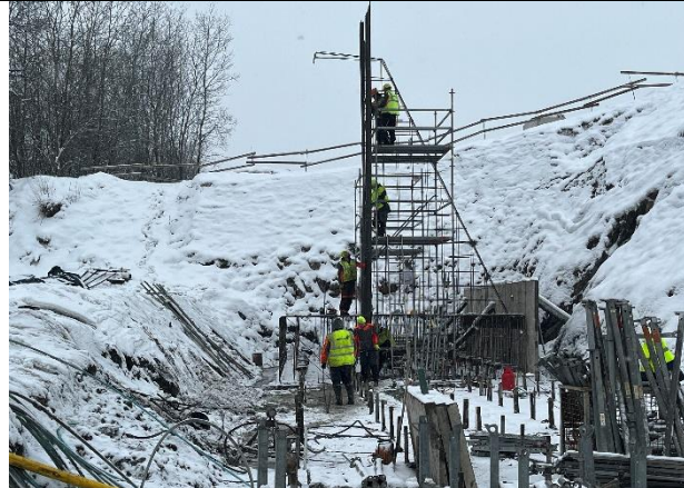
Viazanie armatúry základu a drieku rovnobežného krídla pri OP1
