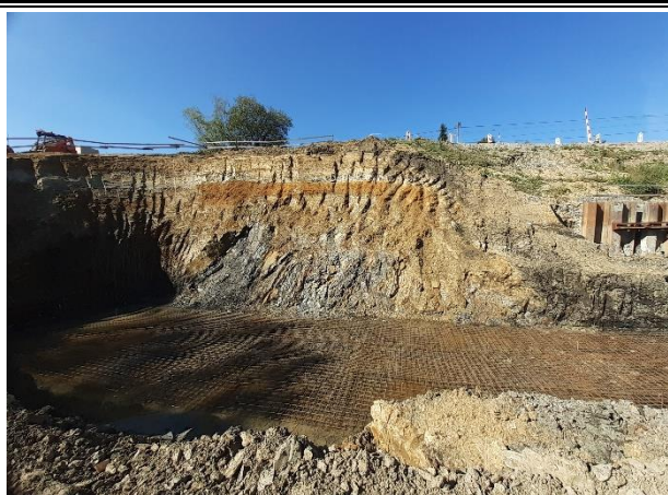
Armatúra podkladného betónu OP1 a rovnobežného krídla
