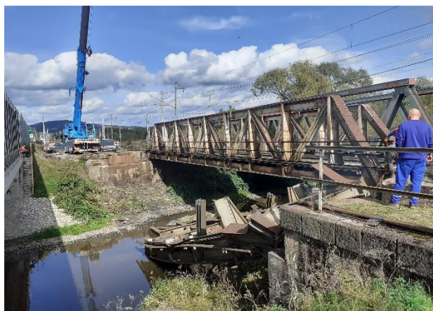
Demontáž nosnej konštrukcie stávajúceho mosta
