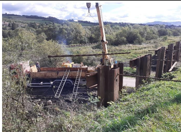
Realizácia pažiacej štetovnicovej steny
