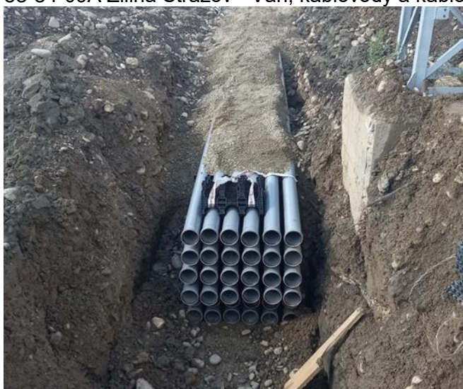
53-34-09A Žilina Strážov - Váh, káblovody a káblové trasy - hlavná káblová trasa
